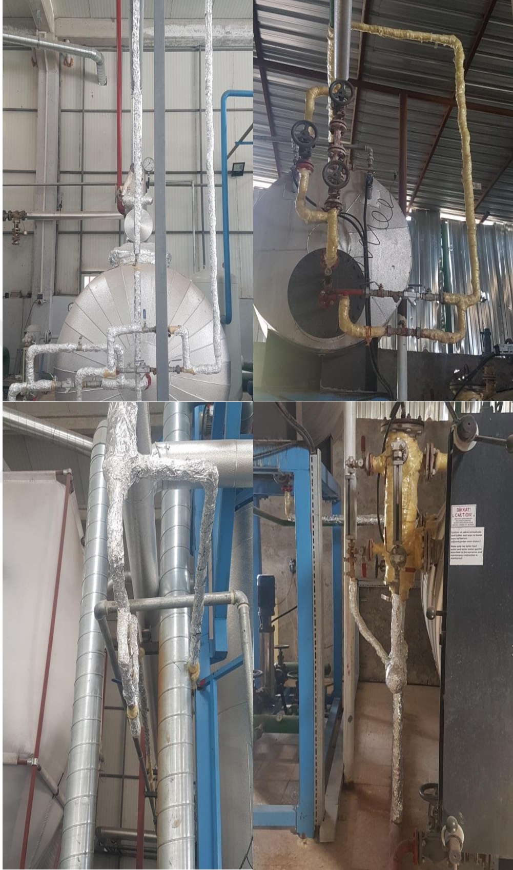
Şekil 4.25. Farklı bölümlerde yalıtım uygulaması görüntüsü
