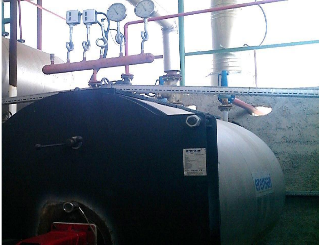
Şekil 3.5. Fabrikadaki buhar kazanı
