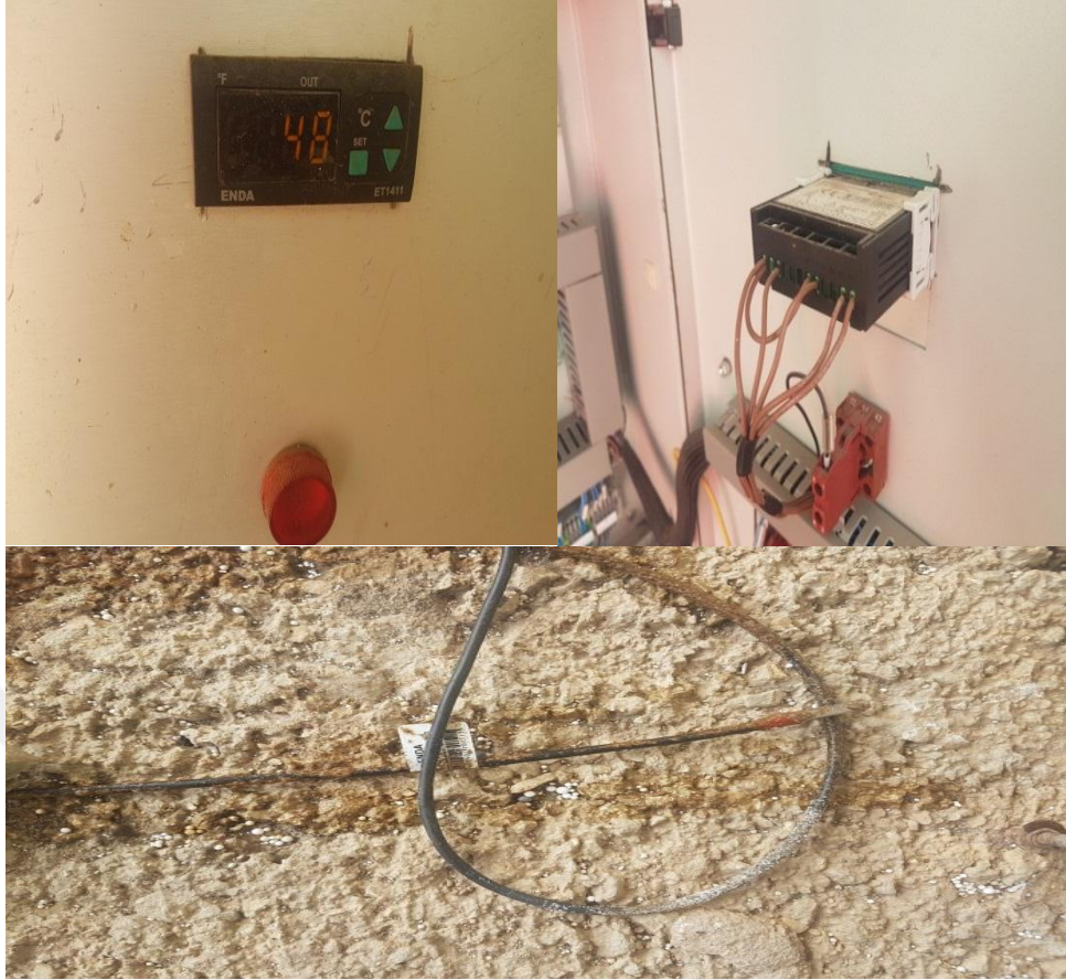
Şekil 4.22. Soğutma kulesi panosuna termostat montajı
