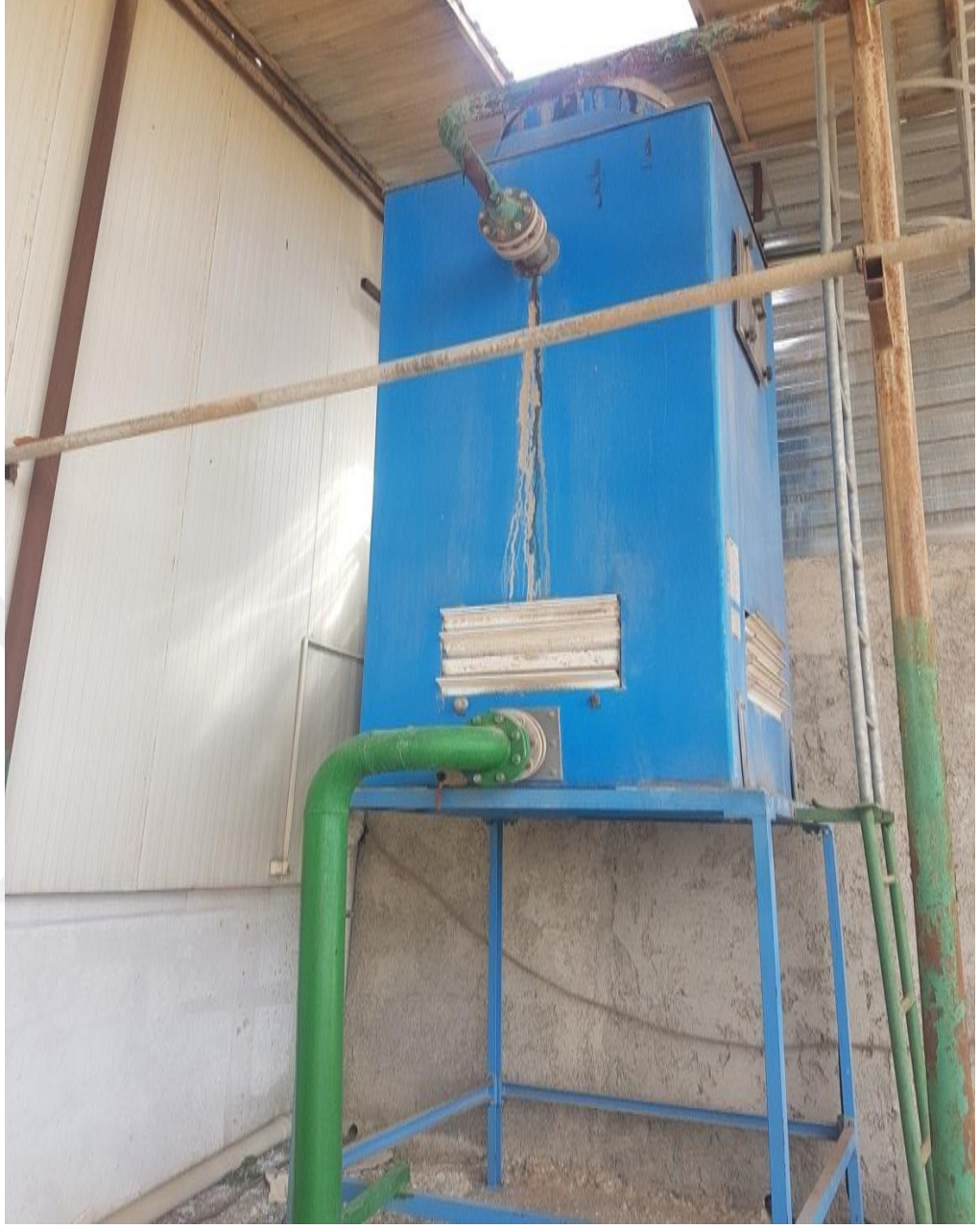
Şekil 4.21. Soğutma kulesinin gösterimi
