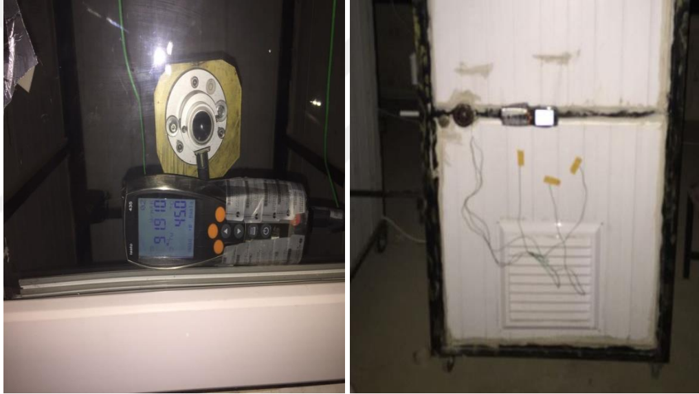
Şekil 3. 15. Camın ve duvarların toplam ısı transfer katsayısı ölçümü
