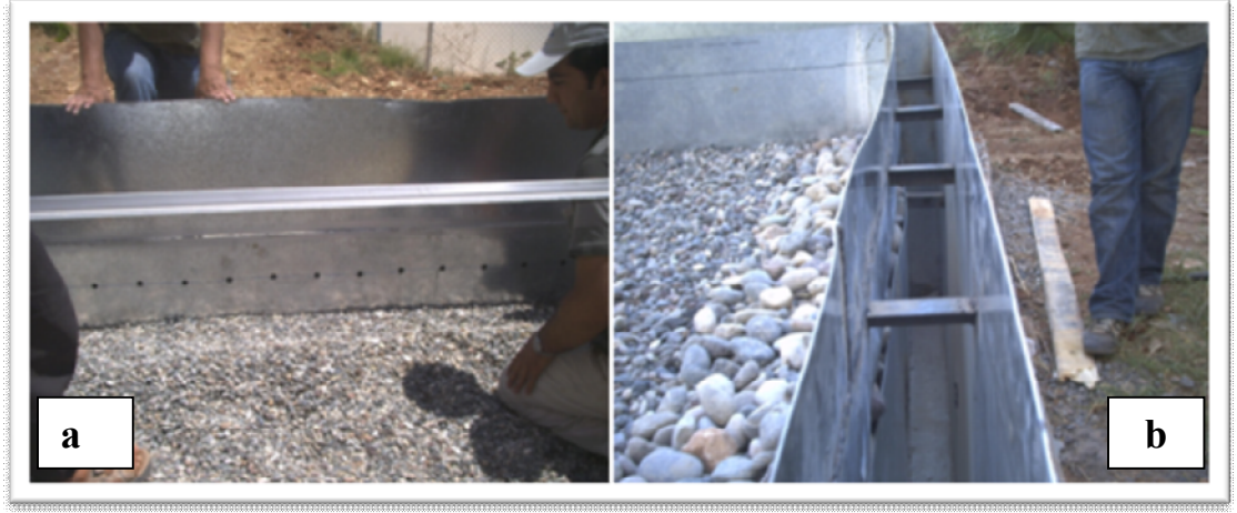
Şekil 3.4. Yüzeyaltı akışlı sistem giriş (a) ve çıkış (b) yapısı ( Naz, 2008)
