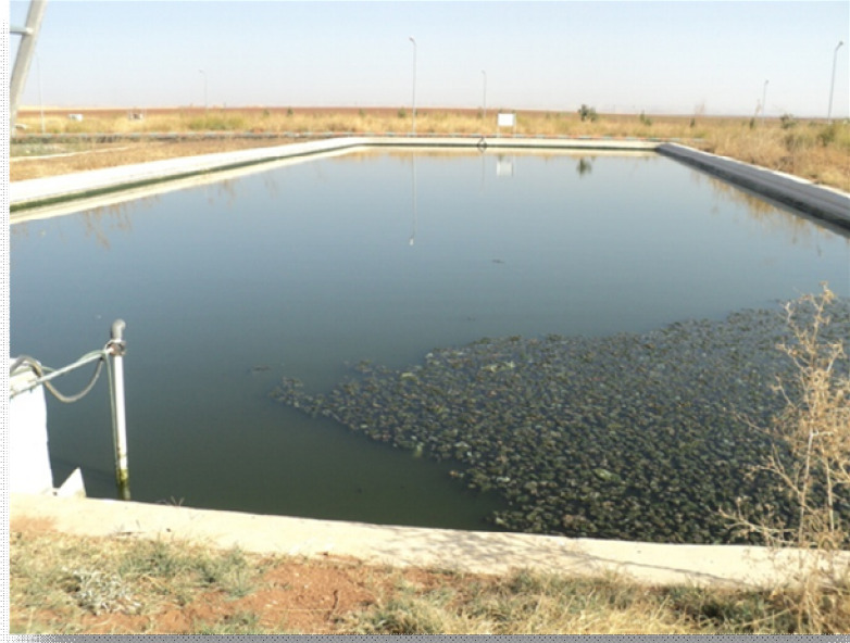
Şekil 3.3. Osmanbey atıksu arıtma tesisi stabilizasyon havuzu
