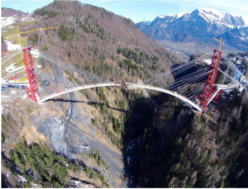
Şekil 3.32. Tamina betonarme kemer köprüsünün (İsviçre) kemerinin konsol uzatımı tekniği kullanılarak tamamlanmak üzere olan hali (Url-24)
