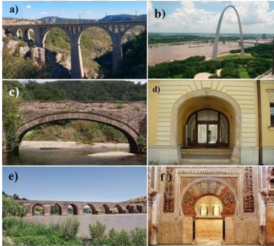
Şekil 3.4. Geometrilerine göre kemer örnekleri: a) Dairesel kemer- Varda köprüsü, Karaisalı, Adana (Fotoğraf: Mehmet TANRIVERDİ), b) Parabolik kemer- Gateway arch, ABD (Url-5), c) Elips eksenli kemer- Llanelltyd Bridge, Wales, İngiltere (Url-7), d) Sepet kulpu eksenli kemer- Black Adler Inn, Romanya (Url-8), e) Sivri kemer- Dicle köprüsü, Diyarbakır (Url-9), f) At nalı şekilli kemer- Bir kapı at nalı kemeri, Kordoba, İspanya (Url-6)
