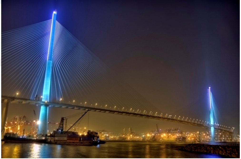
Şekil 3.12. Stonecutters Köprüsü (Hong Kong, Çin) (Url-2)
