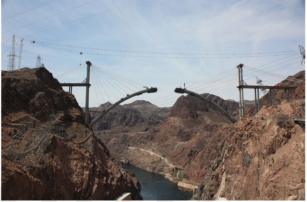
Şekil 3.33. Hoover Barajı (ABD) betonarme kemer köprüsünün konsol uzatımı tekniği ile yapımı (Url-25)
