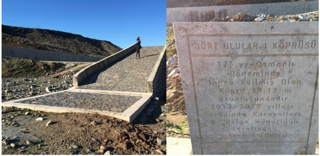
Şekil 3.44. Çarpıran Köprüsü onarım sonrası görünüşü ve yeni kitabesi (Fotoğraf: Mehmet TANRIVERDİ)
