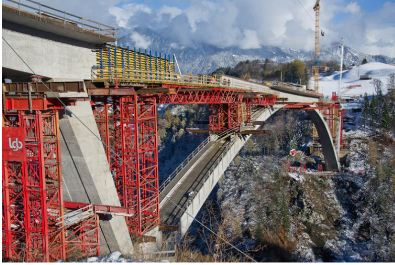
Şekil 3.31. Tamina betonarme kemer köprüsünün (İsviçre) tabliyesinin inşa edilişi (Url-24)
