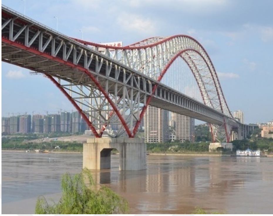
Şekil 3.26. Chaotianmen Köprüsü, NananQu / Çin(Url-22)
