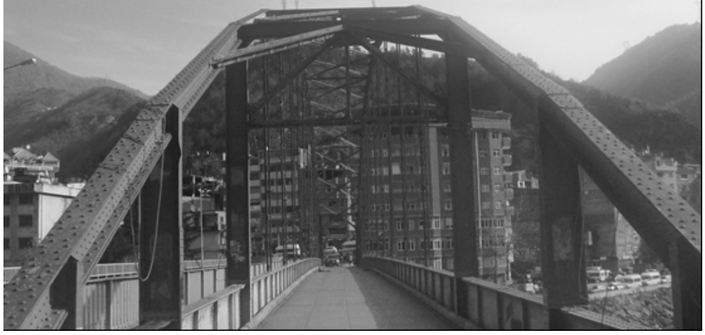
Şekil 3.30. Borçka Çelik Kemer Köprüsü, Borçka / Artvin (Bayraktar ve ark., 2015)
