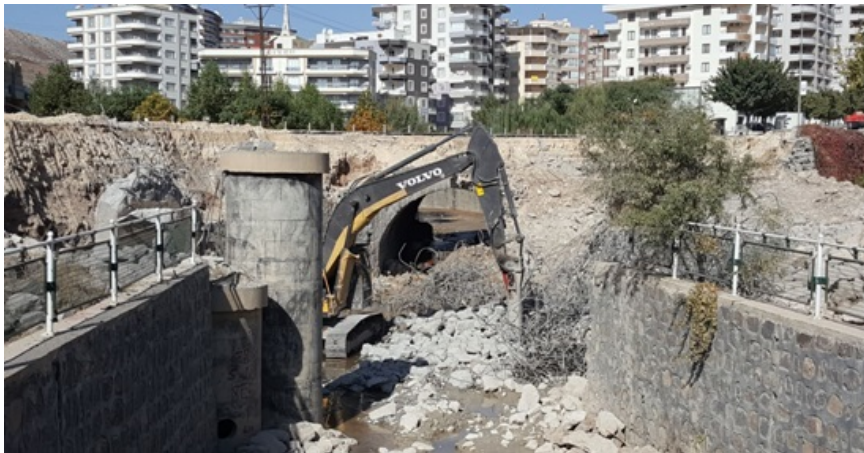
Şekil 3.41. Kara Köprü'nün yıkım çalışmaları sırasında çekilen bir fotoğrafı (Url-29)
