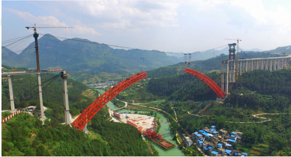
Şekil 3.35. Daxiaojing Köprüsü (Çin) çelik kemerinin konsol uzatımı tekniği ile yapımı (Url-27)
