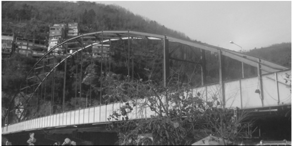
Şekil 3.29. Borçka Çelik Kemer Köprüsü, Borçka / Artvin (Bayraktar ve ark., 2015)
