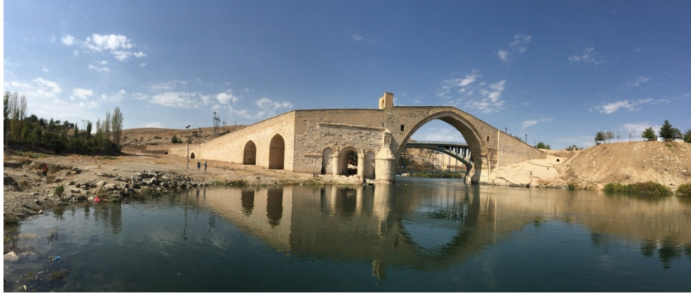
Şekil 3.20. Malabadi Köprüsü Silvan / Diyarbakır(Fotoğraf: Mehmet TANRIVERDİ)
