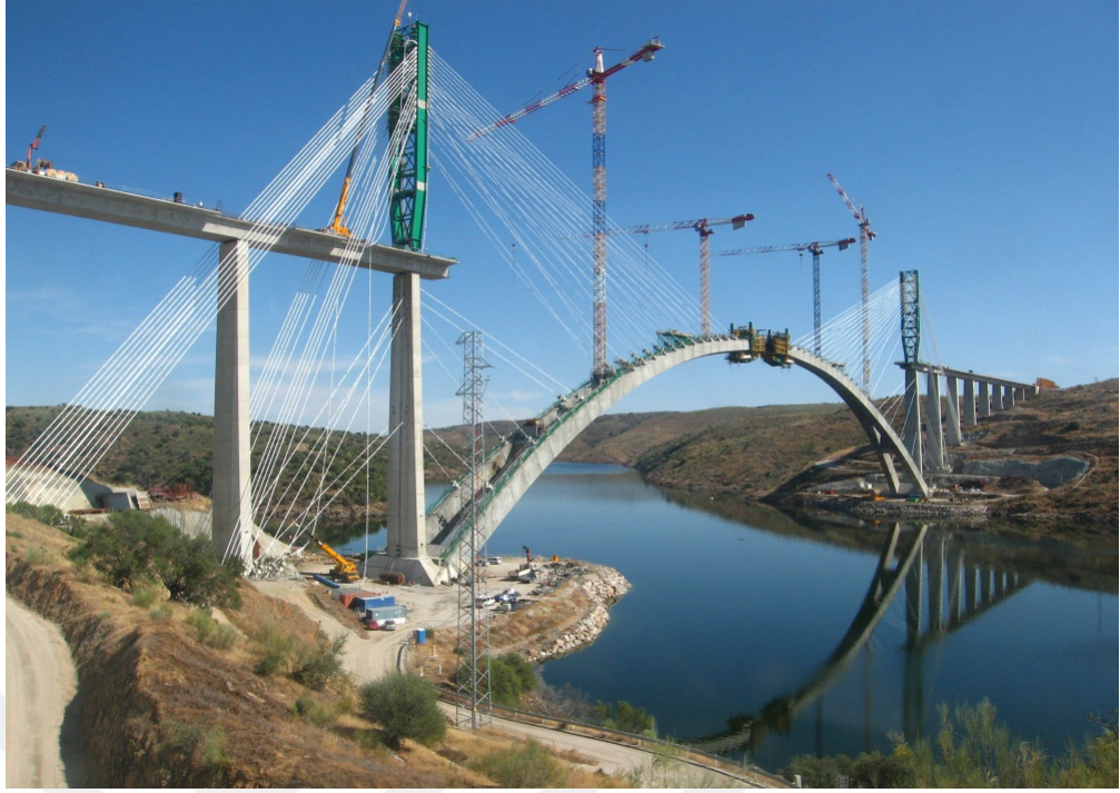
Şekil 3.34. Almonte Nehri (İspanya) betonarme kemer köprüsünün konsol uzatımı tekniği ile yapımı (Url-26)
