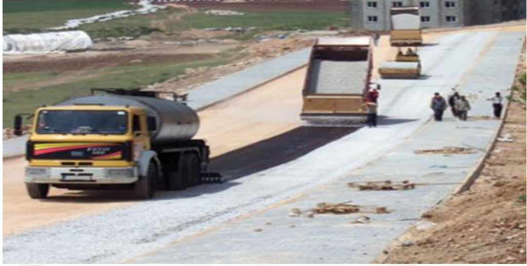
Şekil 2.1. Tek katlı sathi kaplama uygulaması
