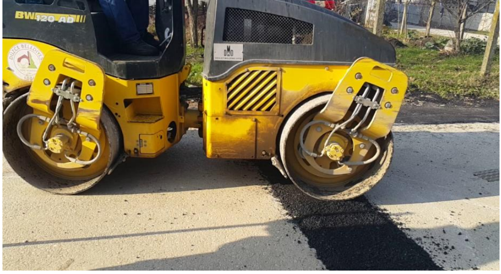
Şekil 2.3. Bitümlü soğuk karışım uygulaması
