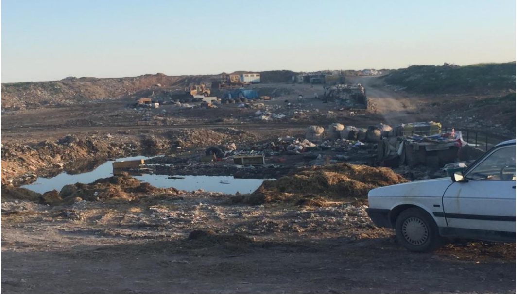
Şekil 4.8. Adıyaman İli Merkez İlçesi Katı Atık Düzensiz Depo Sahasında biriken yağmur sularını gösterir fotoğraf
