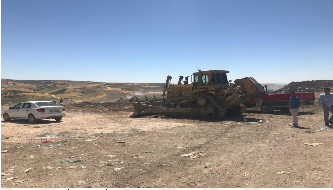
Şekil 4.9. Adıyaman İli Merkez İlçesi Katı Atık Düzensiz Depo Sahasında atıkların sıkıştırılması için kullanılan kepçeyi gösterir fotoğraf
