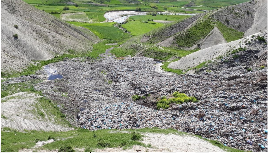
Şekil 4.7. Adıyaman İli Merkez İlçesi Katı Atık Düzensiz Depo Sahasında atıkların aşağı akışını gösterir fotoğraf
