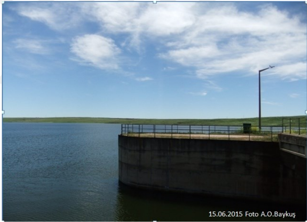
Şekil 3.2. Birinci istasyonun (Baraj set)görüntüsü
