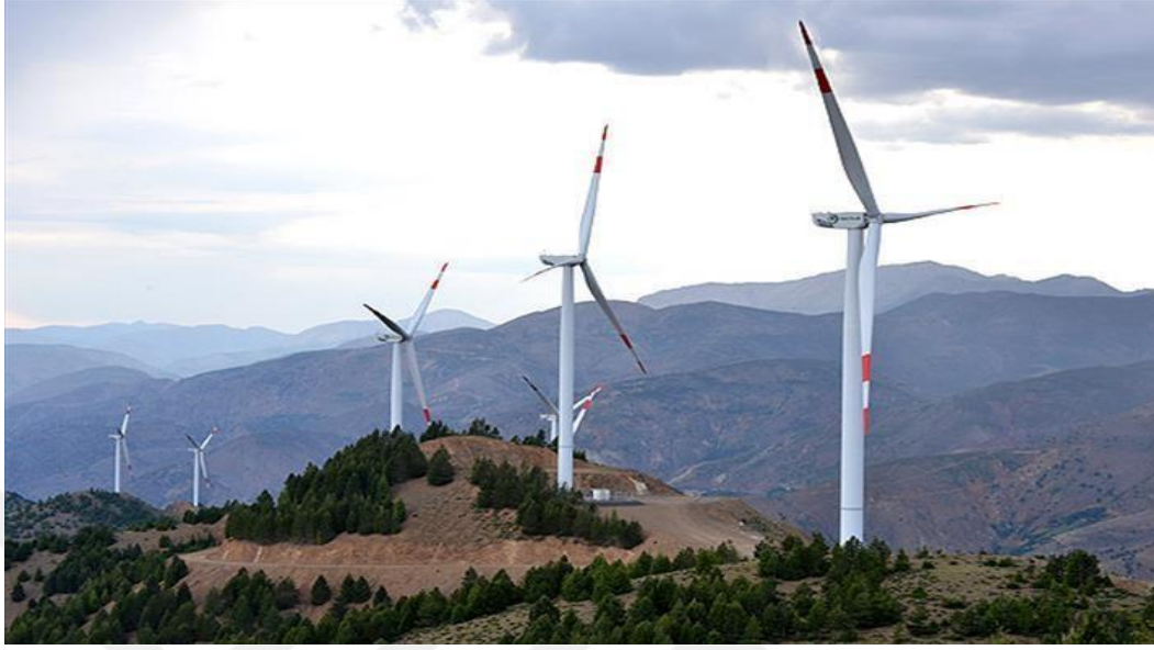
Şekil 4.12. Adiyaman Sincik rüzgâr enerji santrali.
