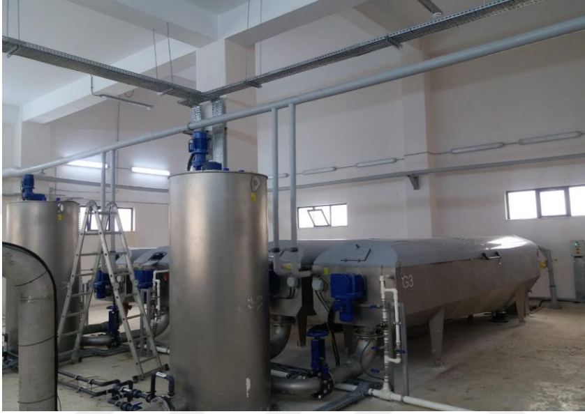
Şekil 3.4. Mekanik yoğunlaştırıcılar
