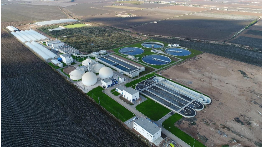
Şekil 3.1 Şanlıurfa merkez atıksu arıtma tesisi
