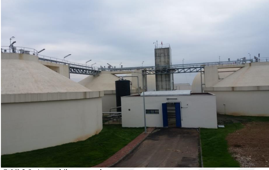
Şekil 3.5. Anaerobik çürütücüler
