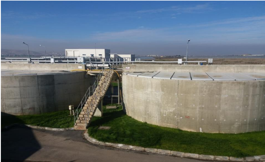
Şekil 3.2. Graviteli yoğunlaştırıcılar
