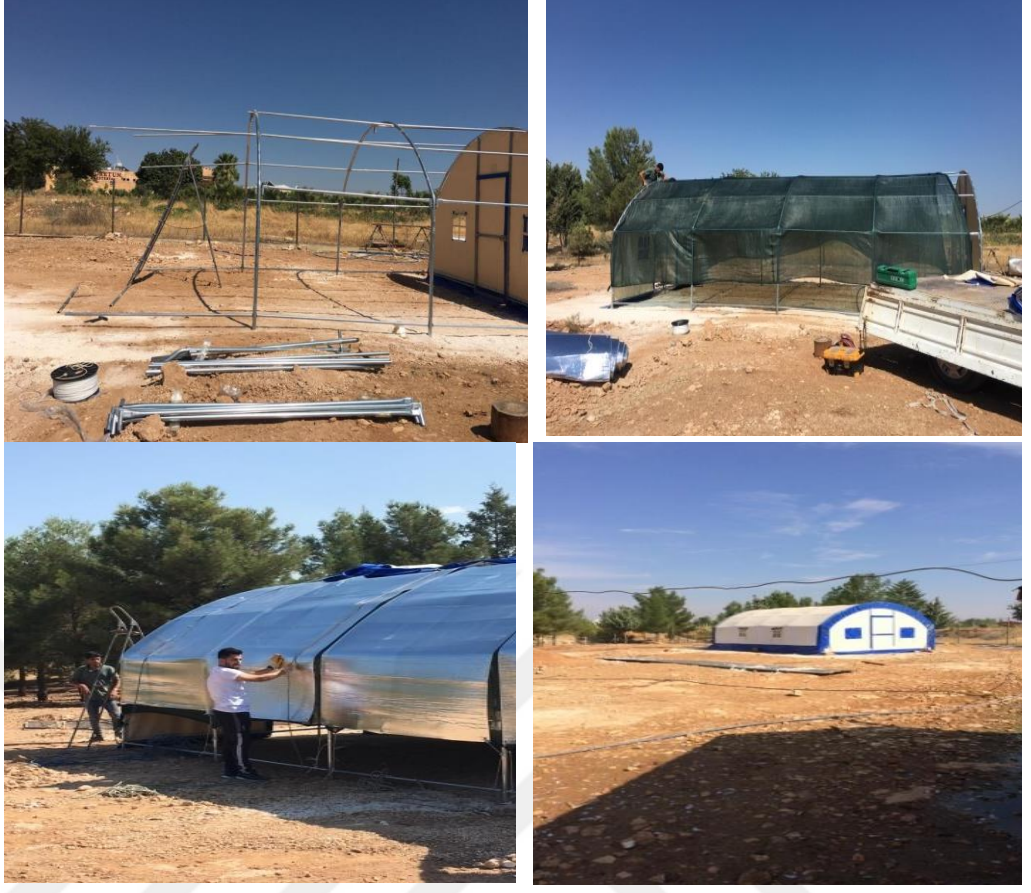
Şekil 3.2. Çadırın aşamalı olarak kurulması
