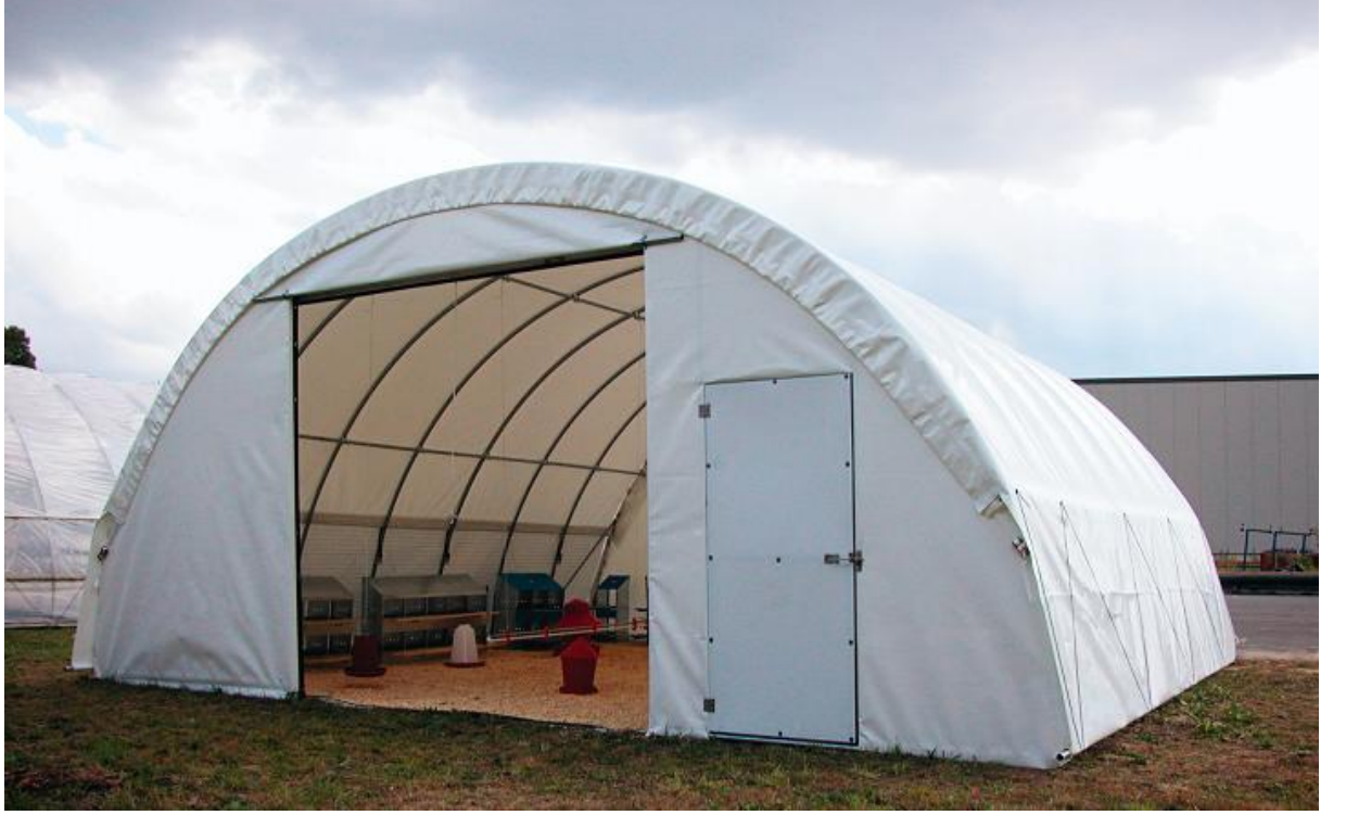
Şekil 4-15: Membran yapılı geçici atölye
