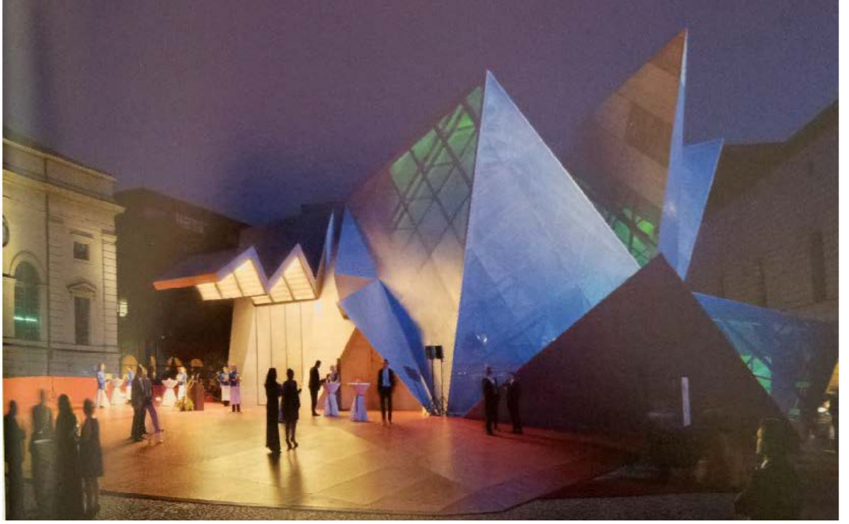
Şekil 4-6: Pavilion 21 Mini opera binası
