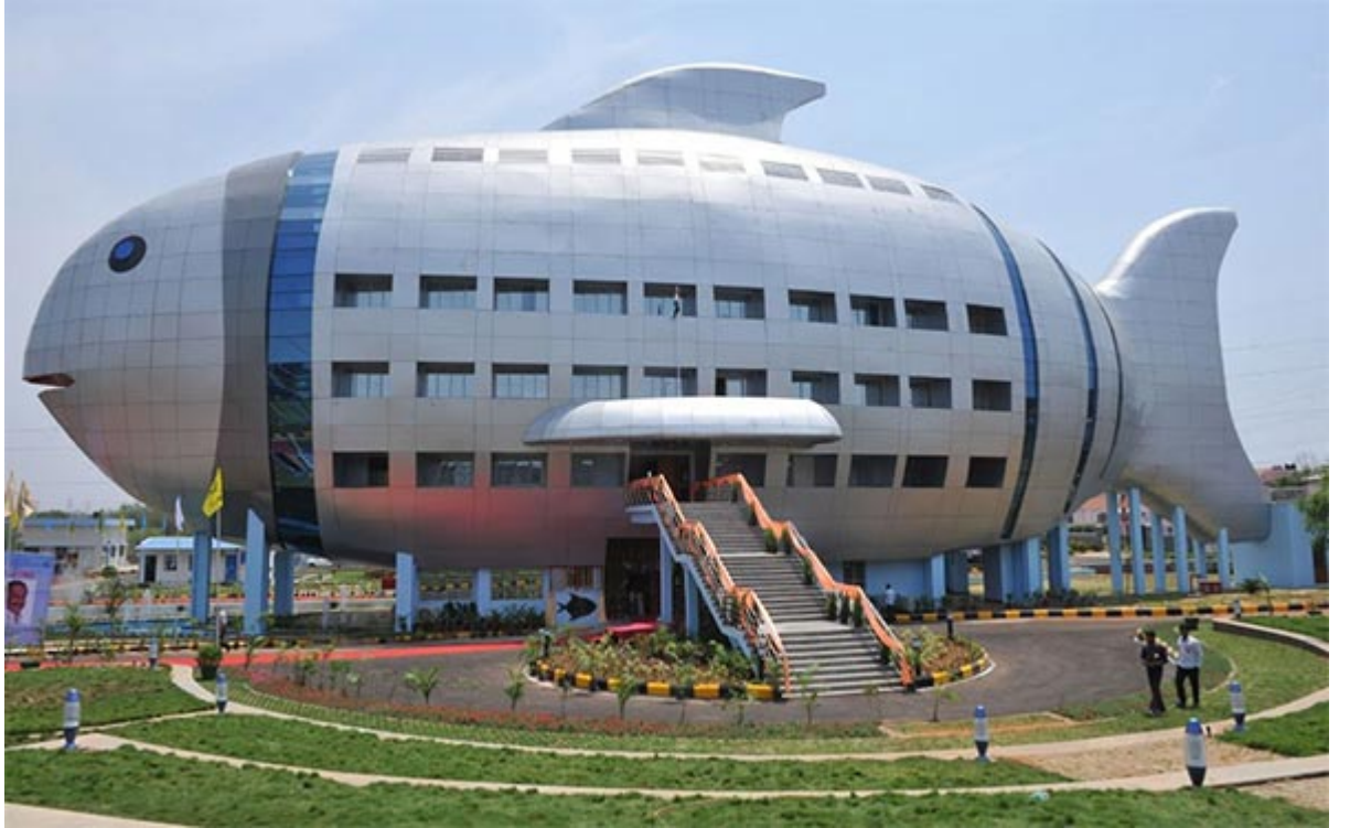
Şekil 1-10: Haydarabaddaki Balıkçılar Birliği Binası
