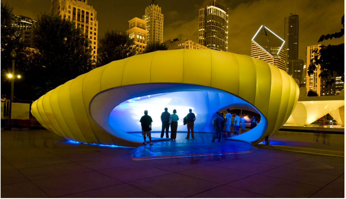
Şekil 7-9: Dış mekan için kurulmuş geçici membran yapı
