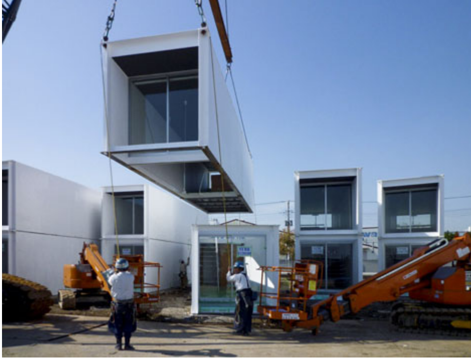
Şekil 4-20: Japonya depreminde kullanılmak üzere tasarlanmış konteyner evler
