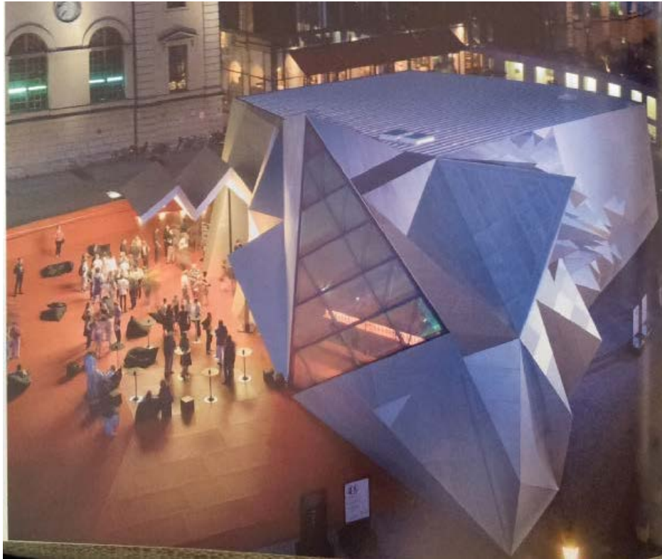
Şekil 4-7:Pavilion 21 Mini opera binası
