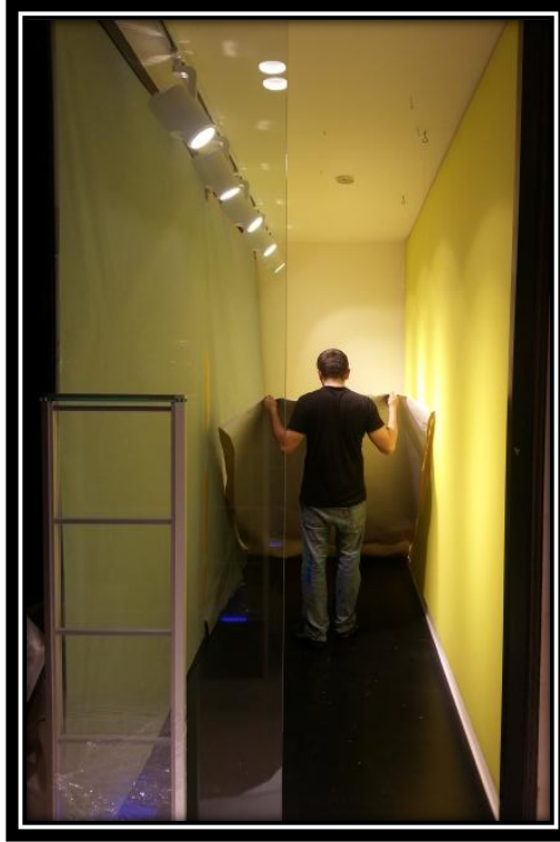
Şekil 7.26. Vitrinin zeminine laminasyonlu folyo yerleştirilmesi
