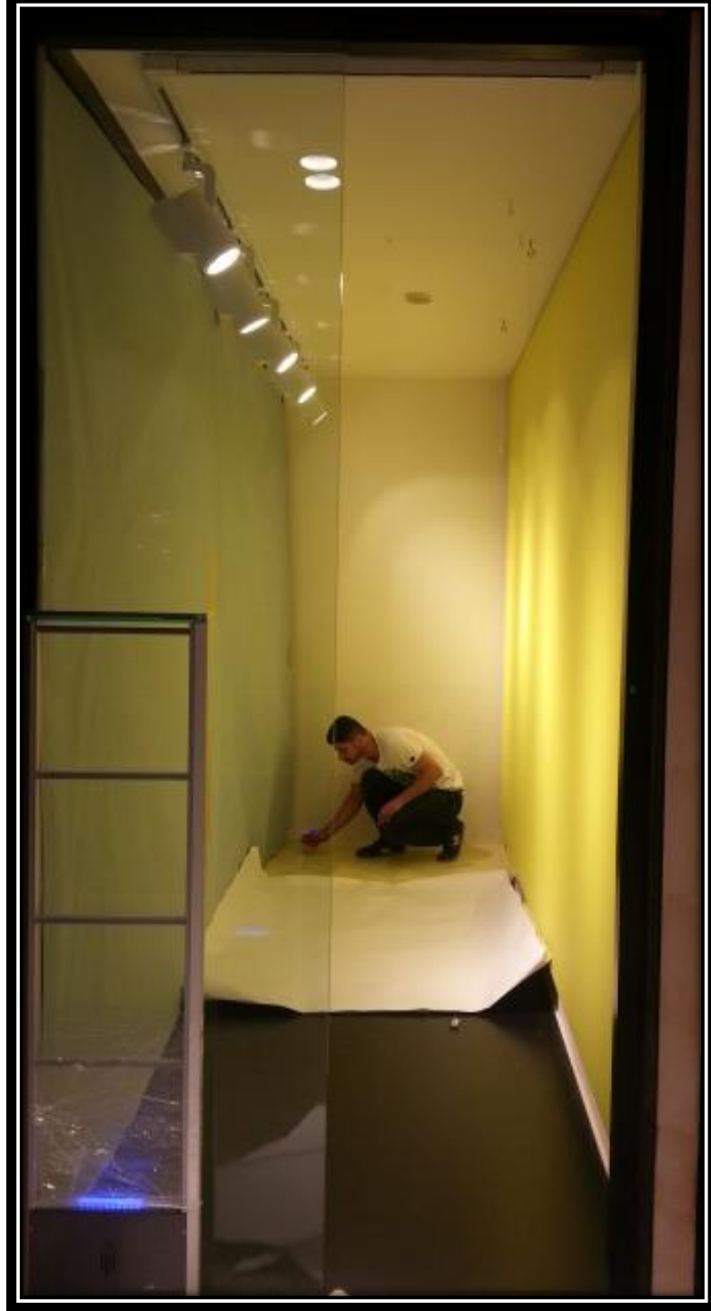
Şekil 7.27. Vitrinin zeminine laminasyonlu folyo yerleştirilmesi
