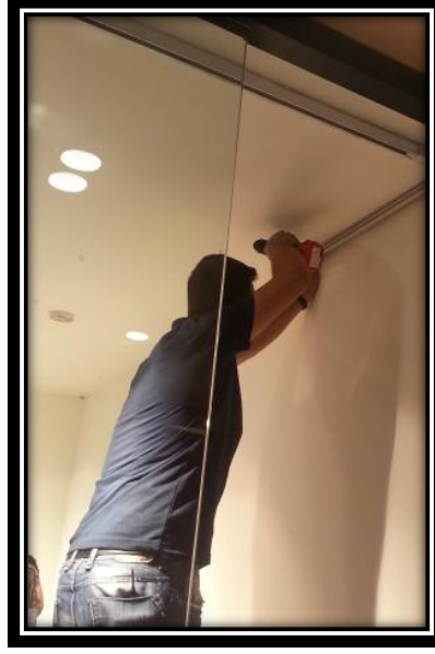
Şekil 7.23. Vitrinin arka fonundaki vinili takmak için yerleştirilen apartlar
