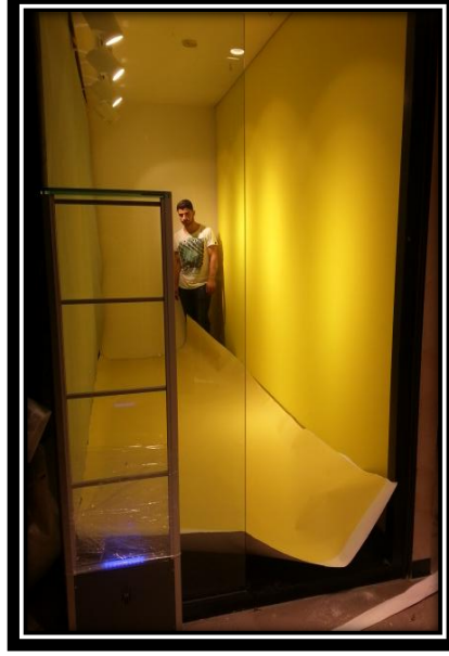
Şekil 7.25. Vitrin zeminine laminasyonlu folyo yerleştirilmesi
