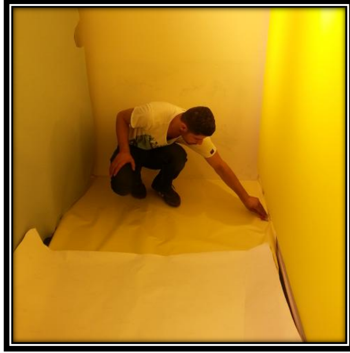
Şekil 7.28. Vitrinin zeminine laminasyonlu folyonun yapıştırılması
