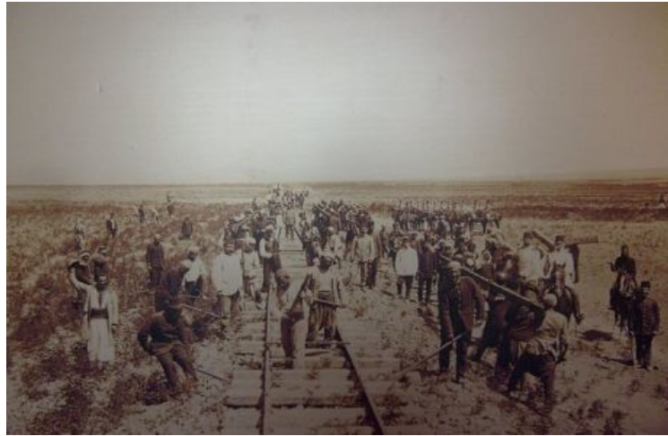
Şekil.3.9.; 1850 Yılıının Sonu, 1860 Yılıının Başına Ait Fotoğrafta İzmir Aydın Demiryolu İnşaatında Çalışan İşçiler
