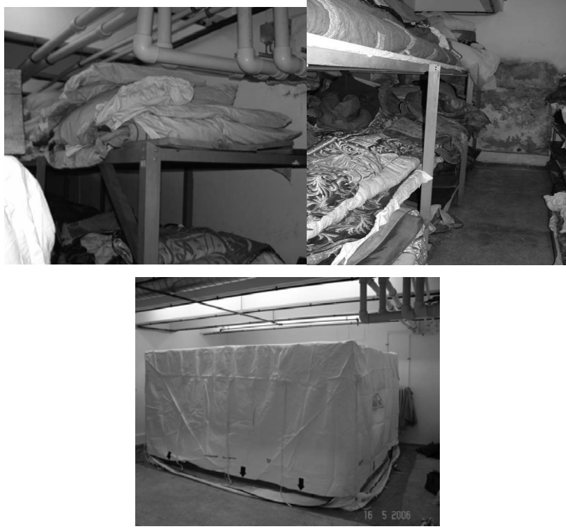
Şekil.8.37.; Sudan Dolayı Rutubetin Görüldüğü Depo ve Alınan Kısmi Önlemlerden Koruma Kılıfı Kullanımı
