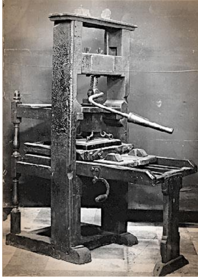
Şekil 2.5 : Gutenberg'in Baskı Makinası
