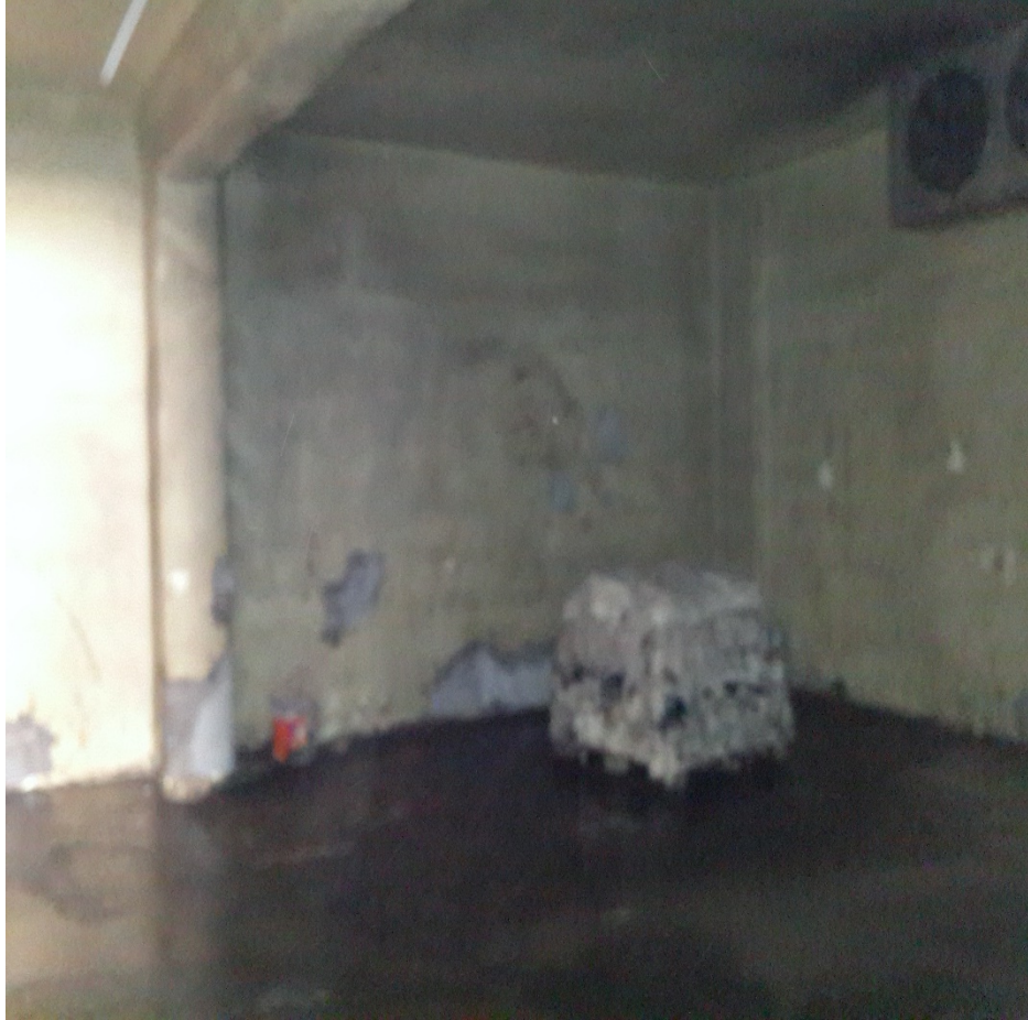
Şekil 6.1.1. Hamderi Deposunda derilerin saklanması. Kaynak: Semra ANAMUR
