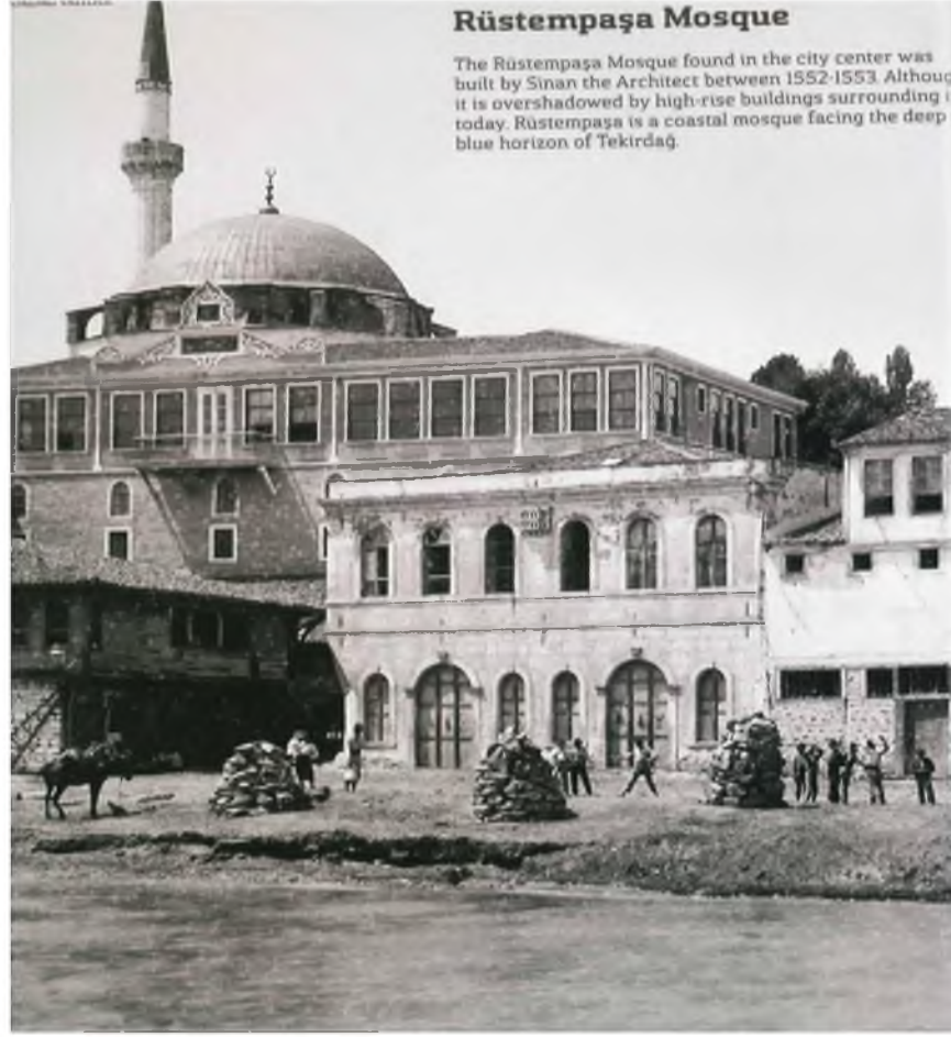
Şekil.7.21.Rüstem Paşa Külliyesi
