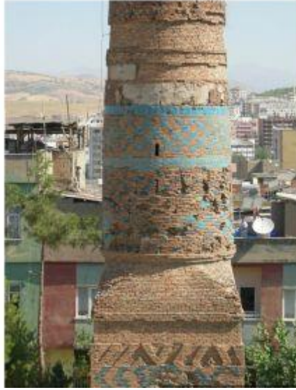
Şekil 5.1. Siirt Ulu Camii Minaresinden Bir Görünüm
