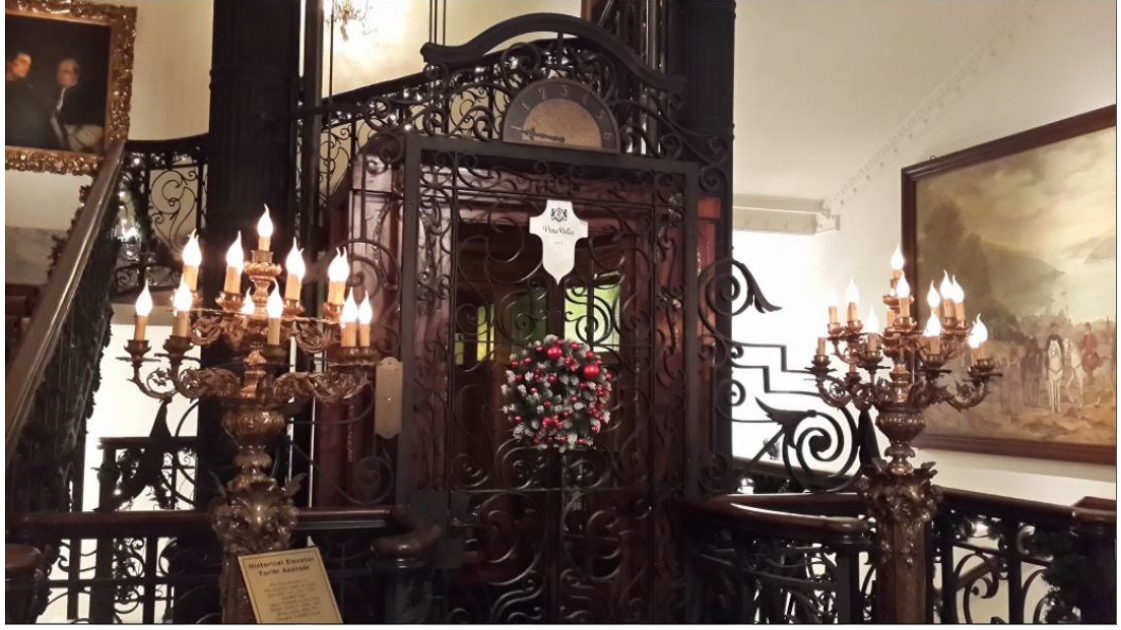
Şekil 4.31. Pera Palas Oteli,Dökme Demirden Yapılmış Tarihi Asansör
