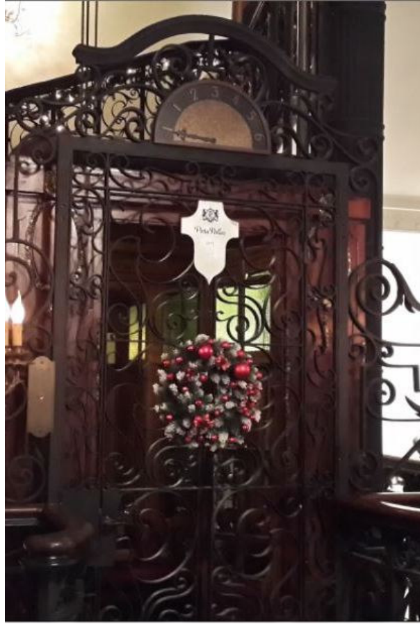
Şekil 4.32. Pera Palas Oteli,Dökme Demirden Yapılmış Tarihi Asansör Detayı
