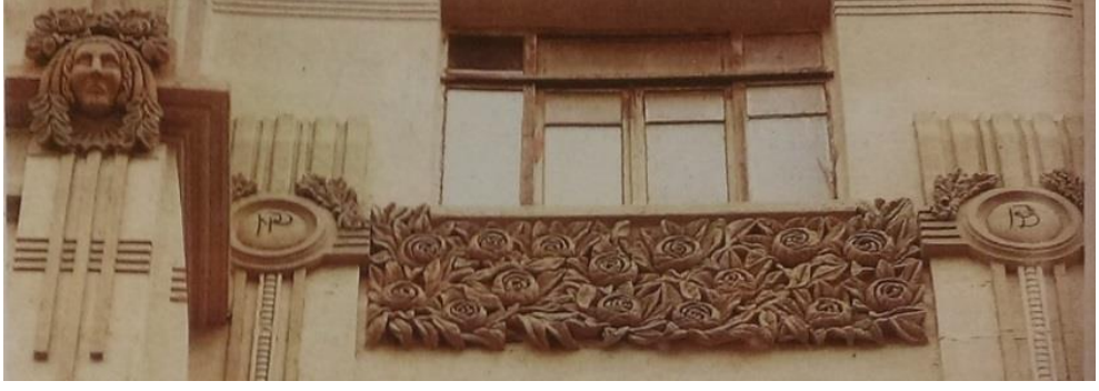
Şekil 5.2. Apartman ön cephesi (ayrıntı)
