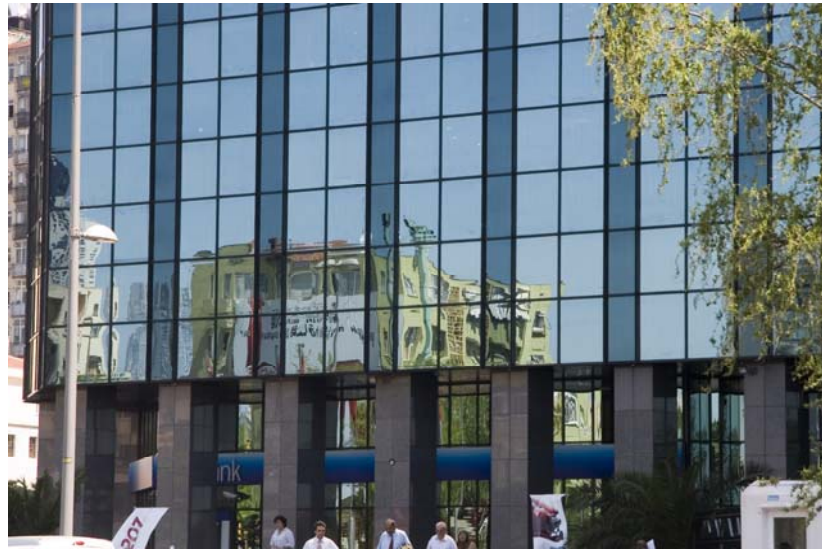
Resim 4-18: Maya Akar Center Cephesinden Bir Bölüm
