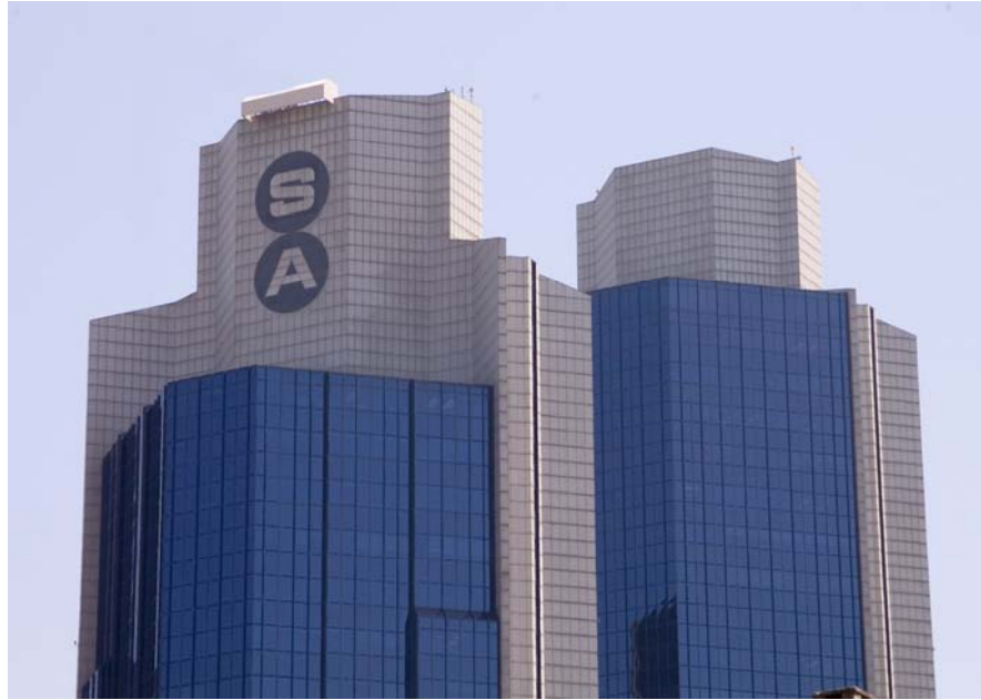
Resim 4-3: Sabancı Center'in cephesinden bir bölüm
