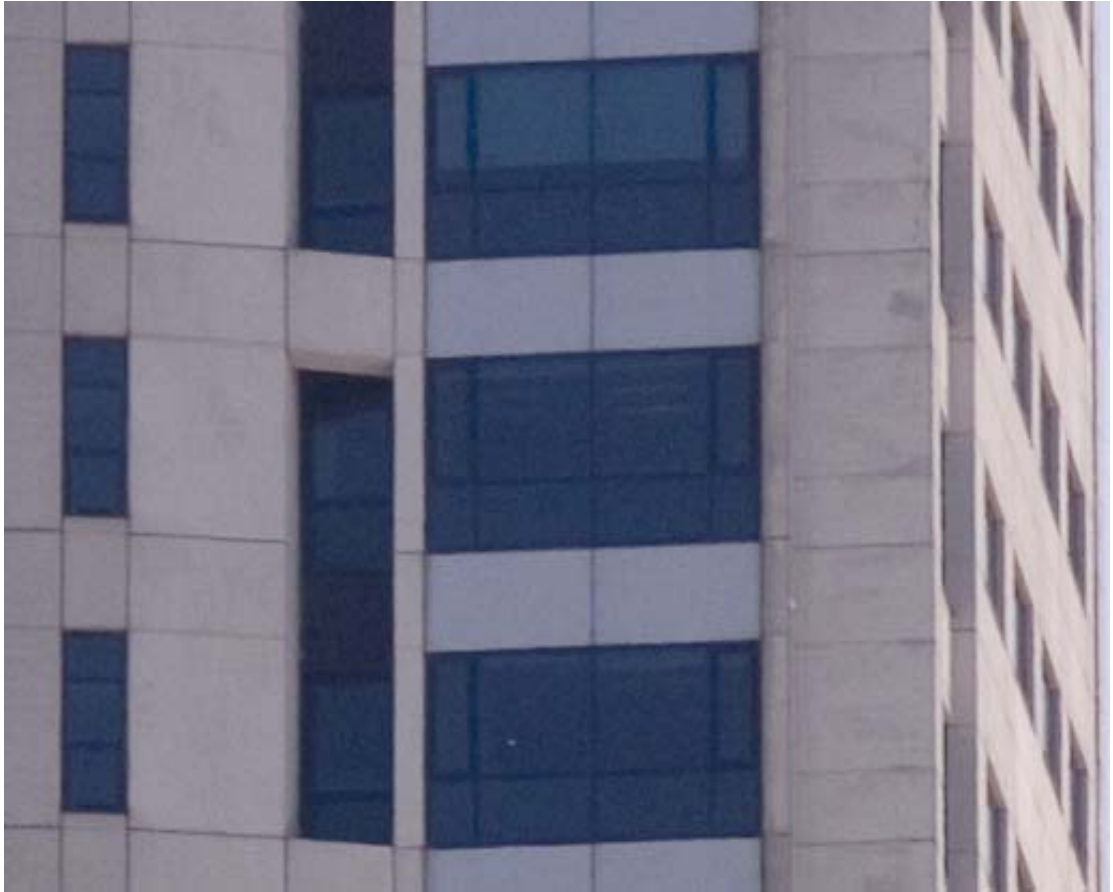
Resim 4-11: Metrocity Büro Binası Cephesinden Bir Bölüm
