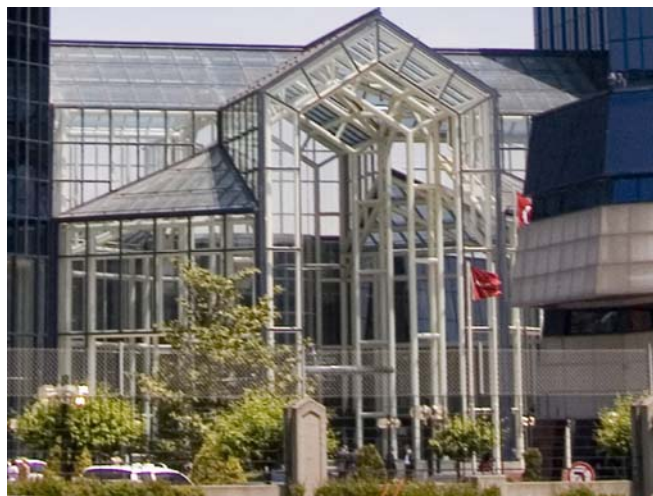
Resim 4-4: Sabancı Center'in Girişi
