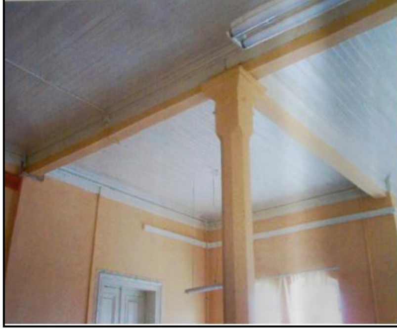
Şekil 5.64: Kaldırılan Taşıyıcı Duvarların Yerine Konulan Sekizgen Ahşap Sütun
