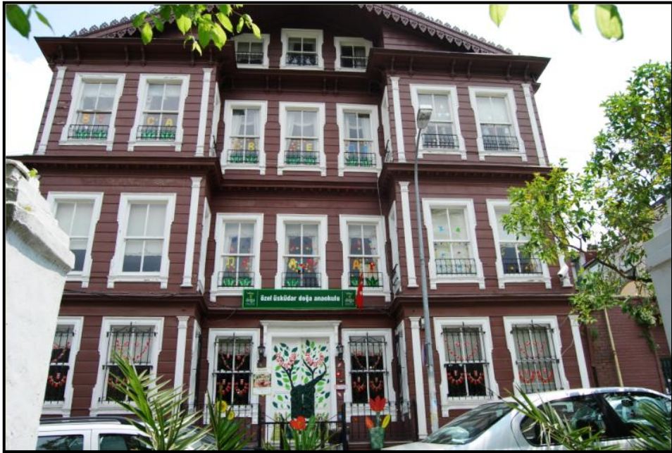
Şekil 5.167: Konağın Ön Cephesinin Günümüzdeki Hali
