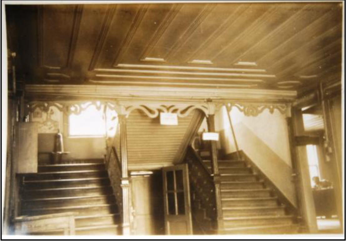
Şekil 5.164: Konağın Selamlık Merdiveninin Restorasyondan Önceki Hali
