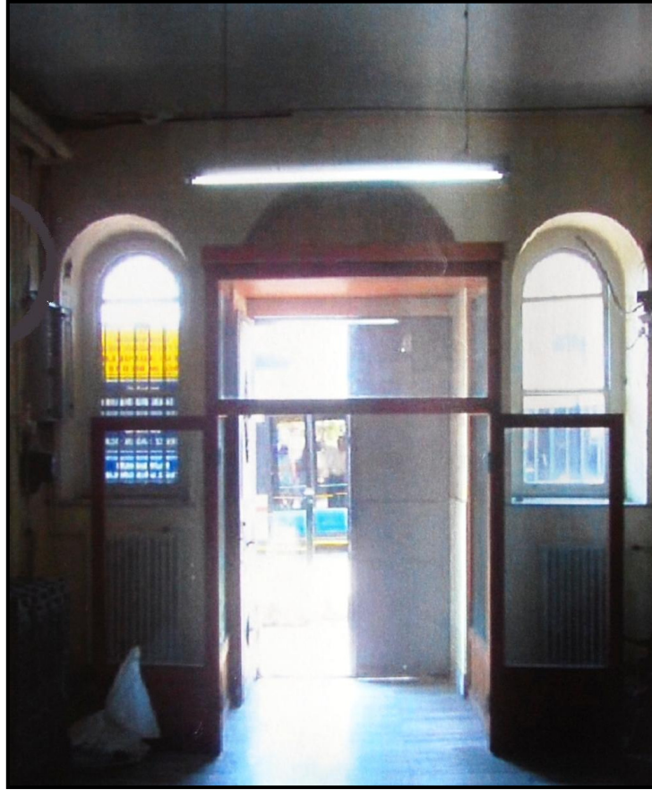
Şekil 5.61: Konağın Ana Girişinden Görünüş
