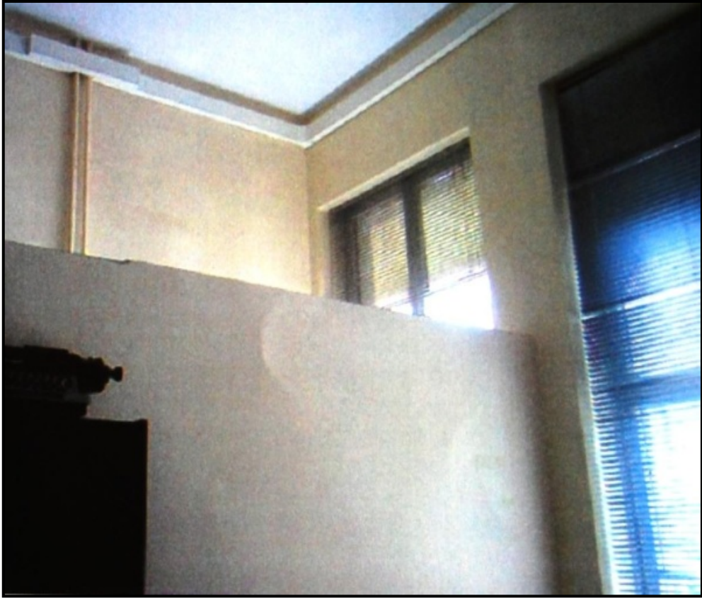
Şekil 5.62: Birinci Katta Girişin Üzerindeki Mekânın Alçıpan Duvar İle Bölünmesi
