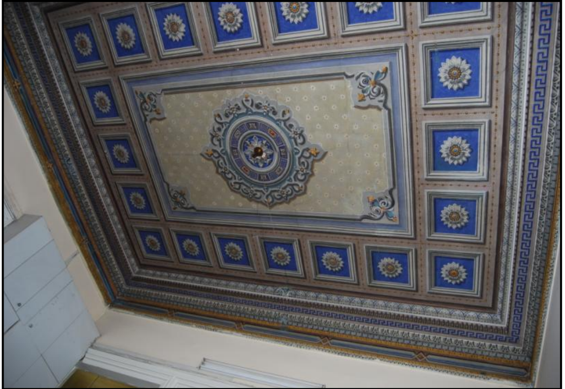
Şekil 5.123: Giriş Mekânının Korunmuş Olan Tavanı
