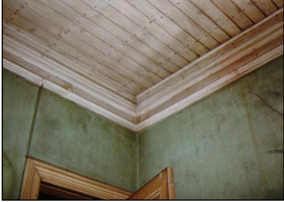
Şekil 5.106: Konağın Tavanının Restorasyondan Önceki Hali
