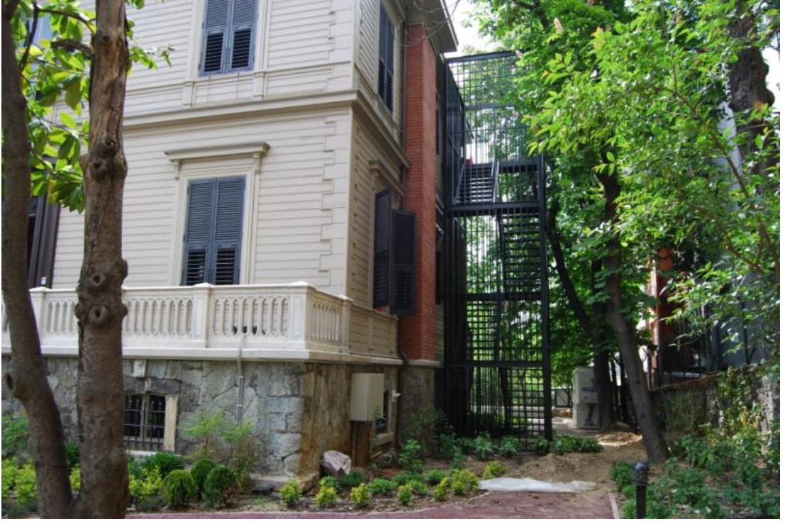
Şekil 5.111: Konağa Eklenen Yangın Merdiveni
