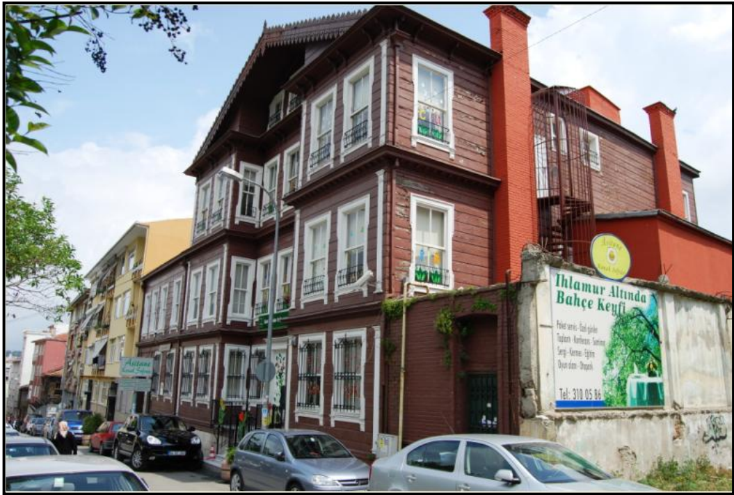
Şekil 5.169: Konağın Bulunduğu Sokağın Günümüzdeki Hali
