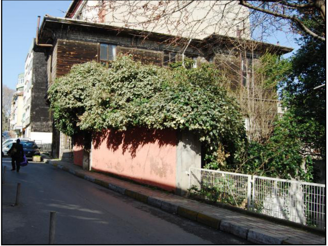
Şekil 5.1: Beşiktaş'ta Sadece Selamlık Bölümü Kalan Emin Paşa Konağı
