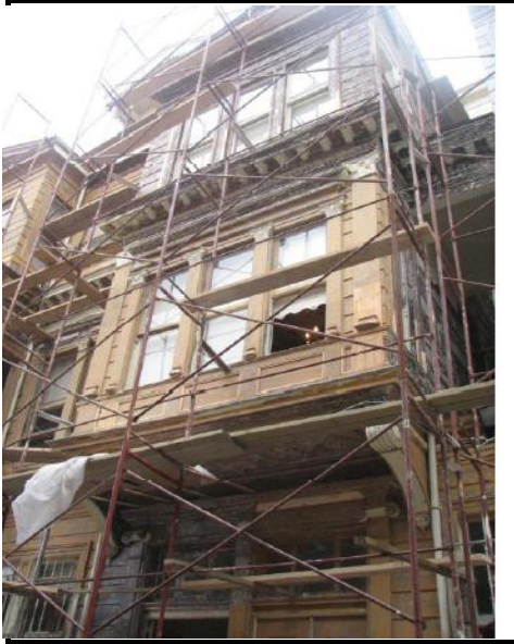
Şekil 5.8: Konağın 2006 Yılındaki Restorasyonu
