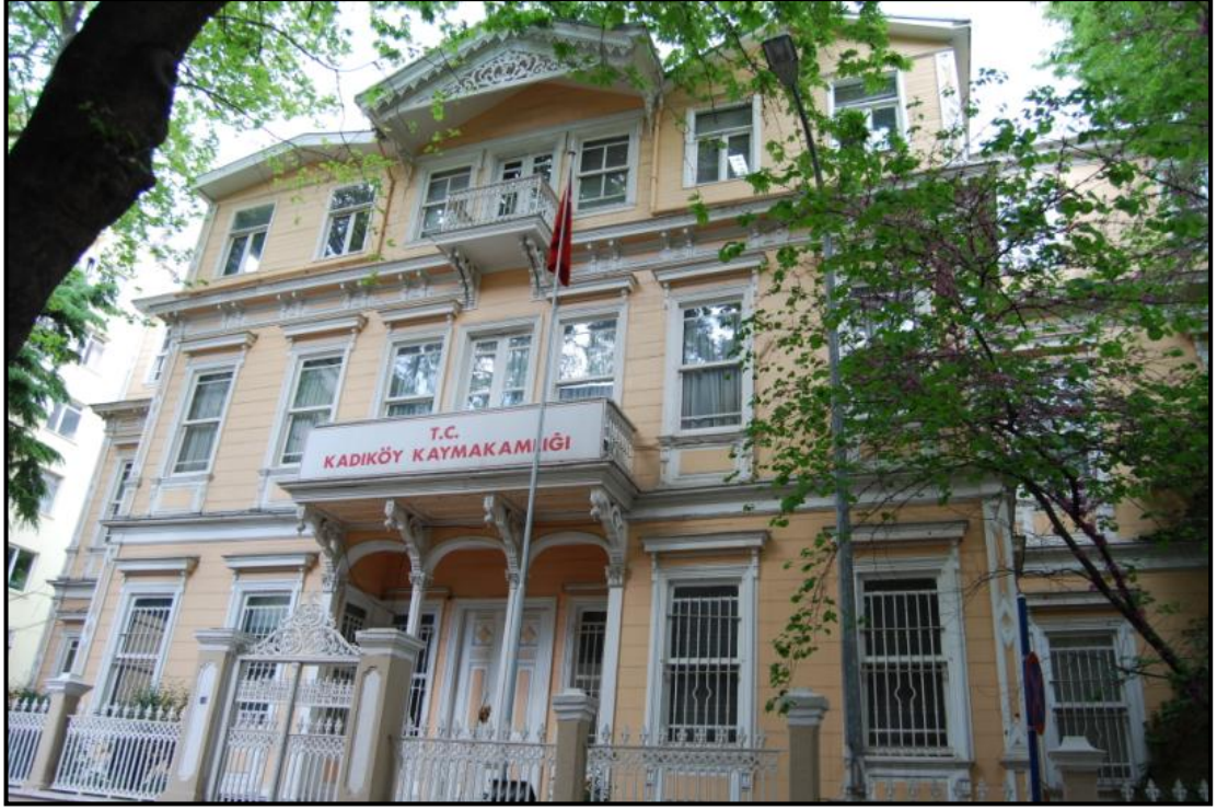
Şekil 5.131: Konağın Ön Cephesinin Günümüzdeki Hali
