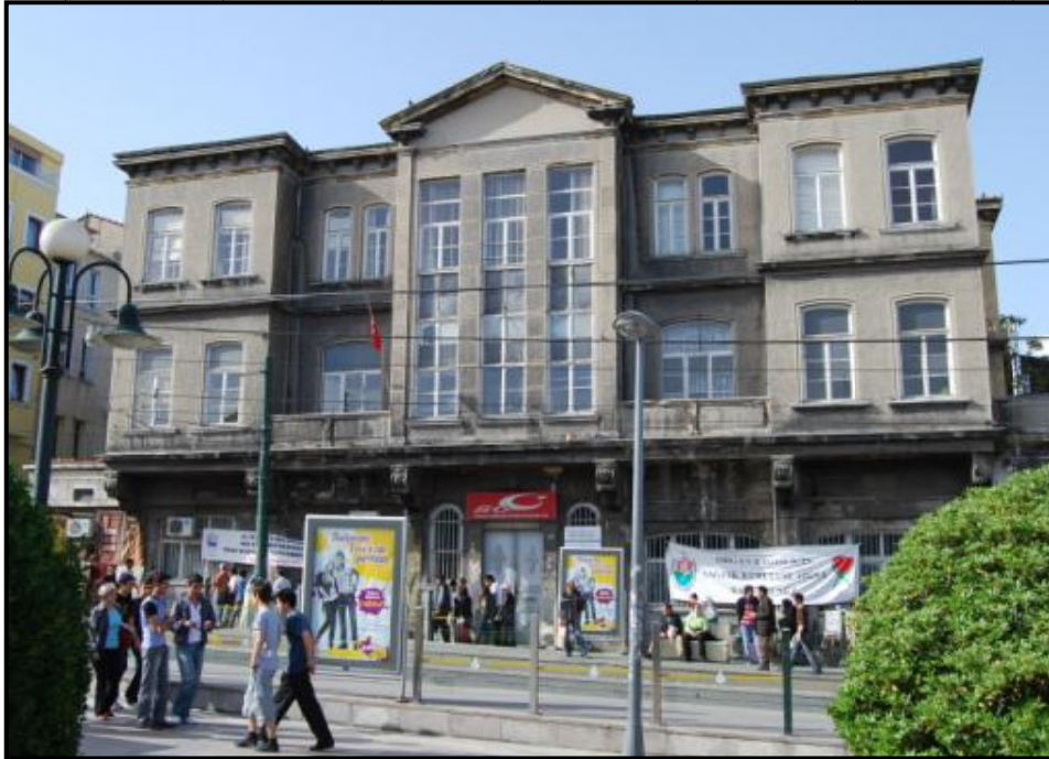
Şekil 5.60: Konağın Ön Cephesinin Günümüzdeki Hali
