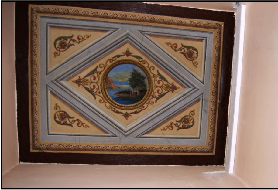
Şekil 5.130: Birinci Kat Sofasının Doğu Tarafındaki Odaya Geçişteki Koridorun Korunmuş Olan Tavanı
