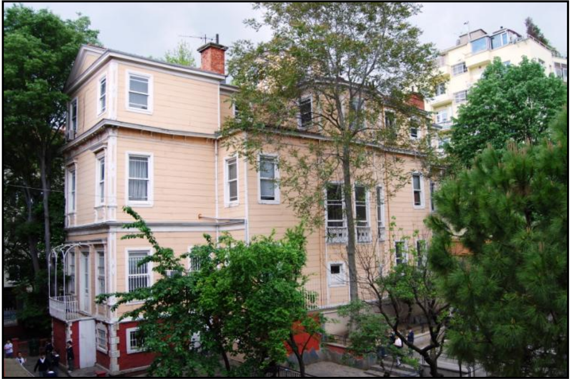
Şekil 5.132: Konağın Arka Cephesinin Günümüzdeki Hali
