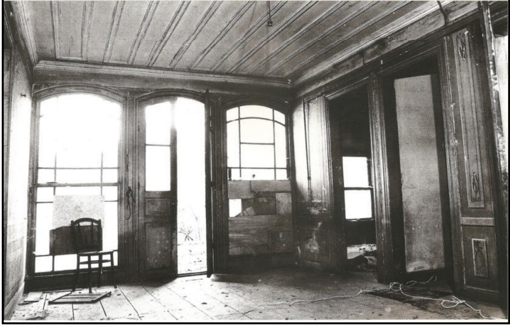
Şekil 5.40: Zemin Kat Sofasının Eski Hali
