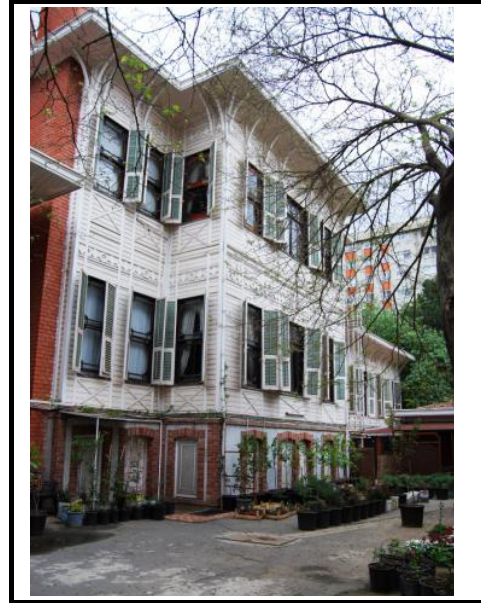
Şekil 5.142: Konağın Arka Cephesinin Günümüzdeki Hali
