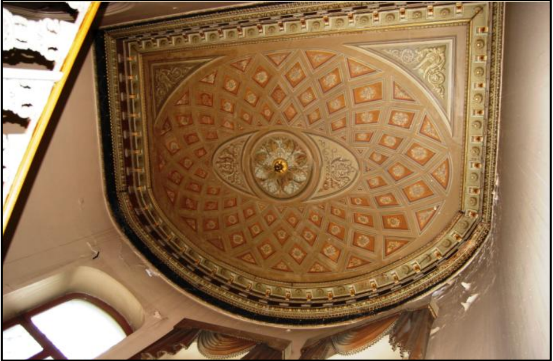
Şekil 5.81: Merdiven Sahanlığının Tavanı
