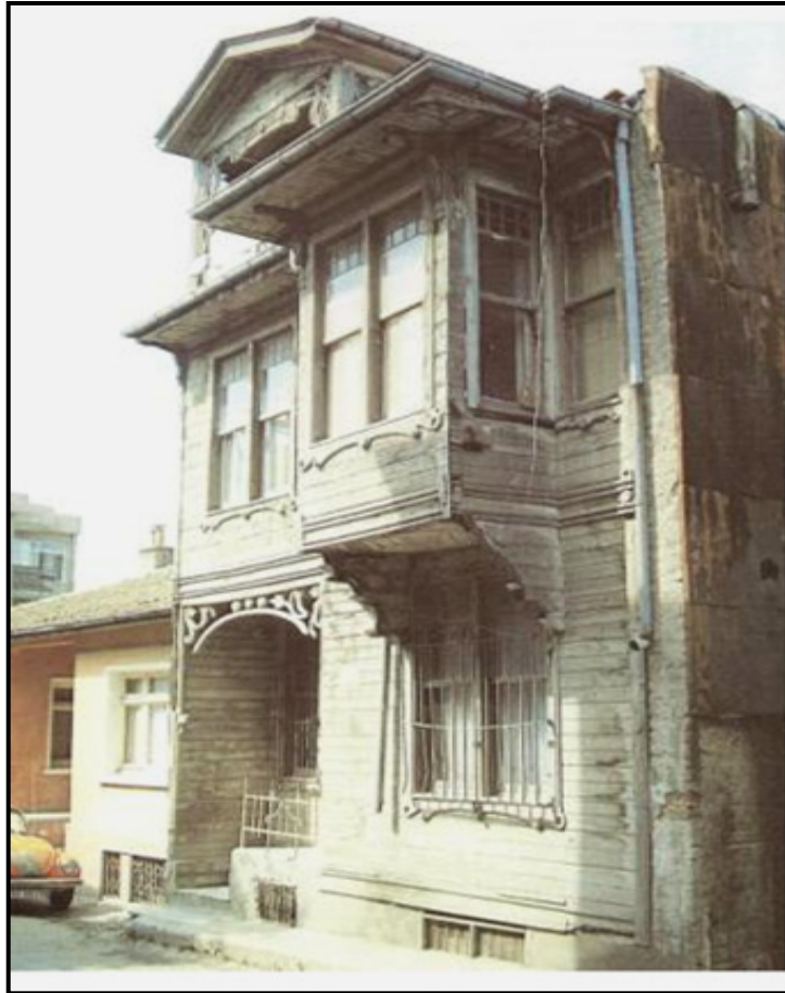
Şekil 2.16: Beylerbeyinde, Eklektik üslupta İnşa Edilmiş Bir Ev
