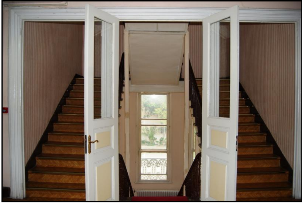
Şekil 5.126: Konağın Merdiveninden Görüntü
