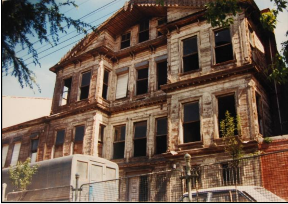
Şekil 5.166: Konağın Ön Cephesinin Restorasyondan Önceki Hali
