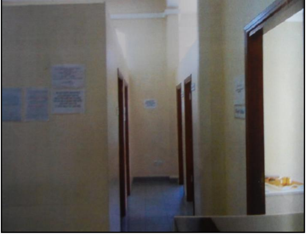
Şekil 5.63: Taşıyıcı Duvarların Kaldırılması ve Bölücü Duvarlarla Oluşturulan Mekânlar
