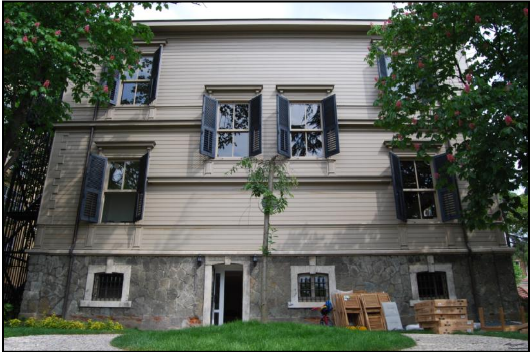
Şekil 5.110: Konağın Arka Cephesinin Günümüzdeki Hali
