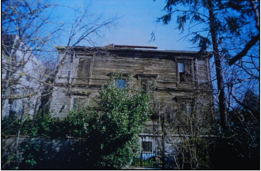
Şekil 5.109: Konağın Arka Cephesinin Restorasyondan Önceki Hali
