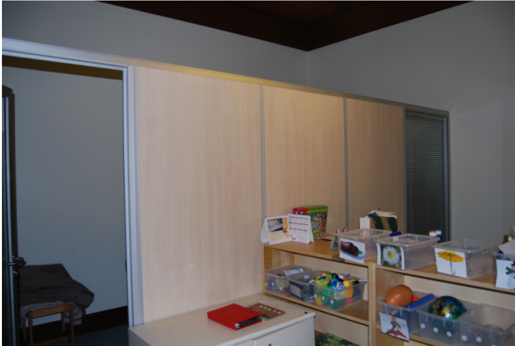
Şekil 5.103: Konağın Zemin Katında Sınıf Olarak İşlevlendirilen Oda ve Bölücü Panel
