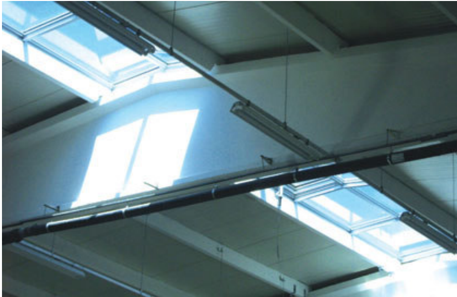
Resim 2.7 – Yağmur suyu toplama boruları
