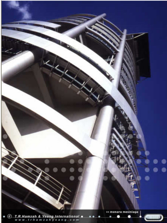
Resim 5.2 Menara Mesinaga cephe açıklık mekanlardan görünüş.
