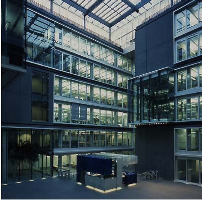
Resim 4.10 Carre Mainz Landstrasse ofis binası İç avludan görünüm
