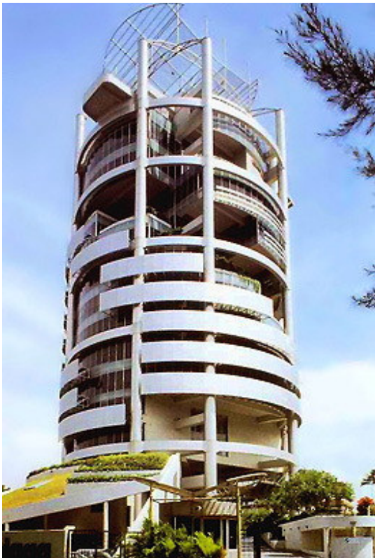
Resim 2.5 - Menara Mesiniaga binası önden görünüş
