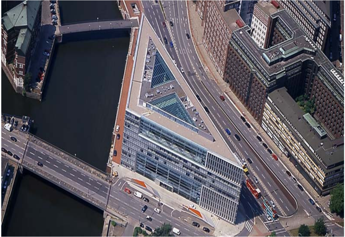
Resim 4.2 Deichtor ofis binası üstten görünüş
