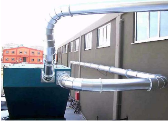
Resim-25. Yuvarlak Kesitli Sac Kanal Uygulama Örnekleri.
