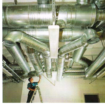
Resim-25. Yuvarlak Kesitli Sac Kanal Uygulama Örnekleri.
