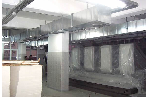
Resim-22. Hava Kanallarının Kat Tavanına Montajı.
