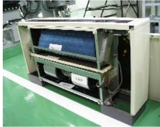
Resim-40. Fan-Coil Uc Üniteleri.
