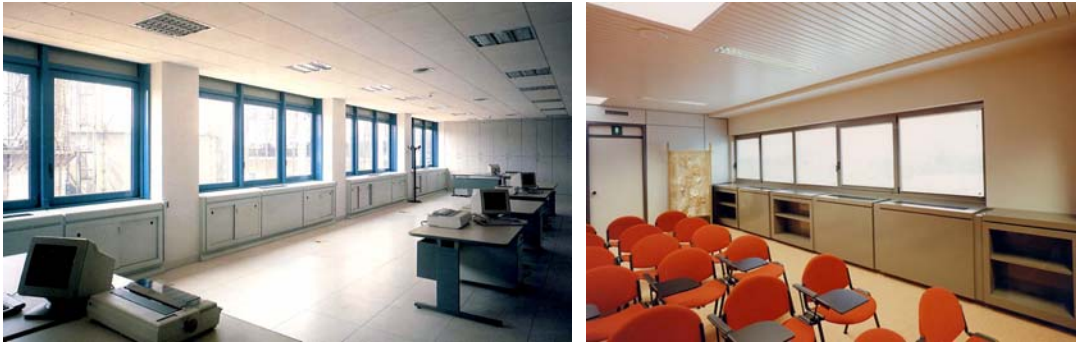
Resim-41. Fan-Coil Uc Ünitelerinin Çevre Zonlara Yerleşimi.
