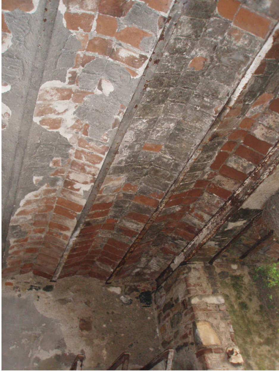
Resim 3-15: Taş Mektep Döşeme Detayı
