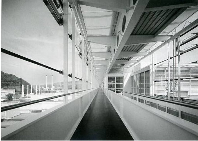
Şekil 5.38: (Duffy:1997)Abb Konnex üstte dış cephe, İç içe geçmiş iki cam katmandan oluşan cephenin dış katmanı ısıtılmıyor ve binaya iklim kontrolü sağlıyor, altta yaya köprüsü
