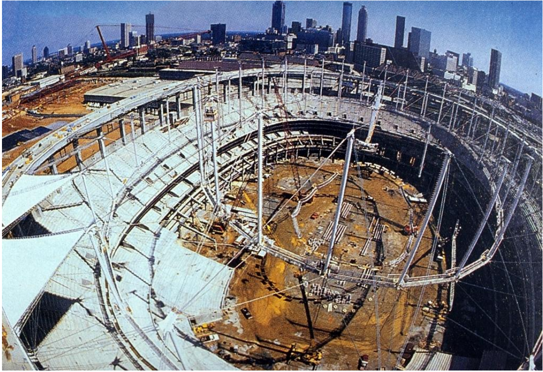
Şekil 3.6: Georgia Kubbesi çatı yerleşiminin inşaat hali
