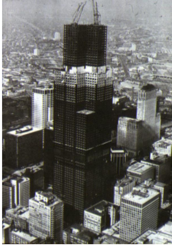
Şekil 3.39: Sears Tower'ın cephe inşaat halindeki resmi
