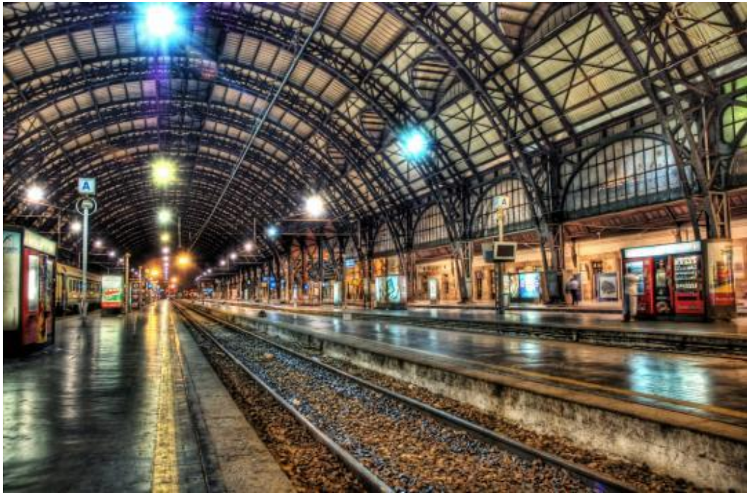
Şekil 2.13: Milan Tren İstasyonu
