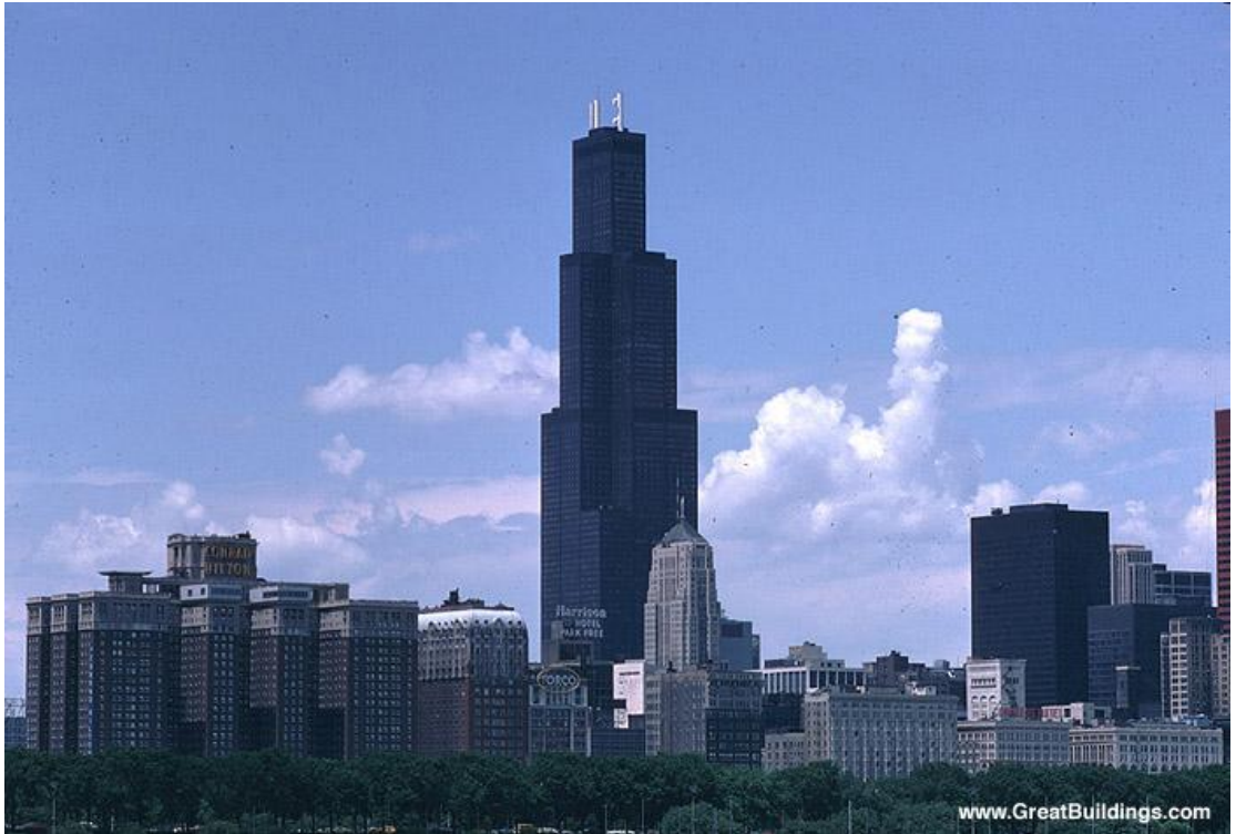
Şekil 3.31: Sears Tower genel görünüş
