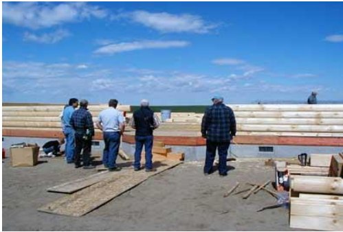
Resim17:Ahşap yapıda uygulama.
