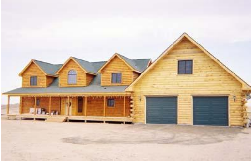
Resim21:Ahşap yapının bitmiş hali..
