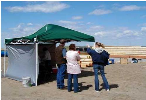
Resim18:Ahşap yapıda uygulama
