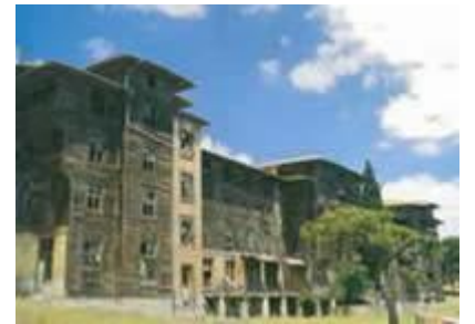
Resim 25:Dünyanın en yüksek ahşap yapısı.
