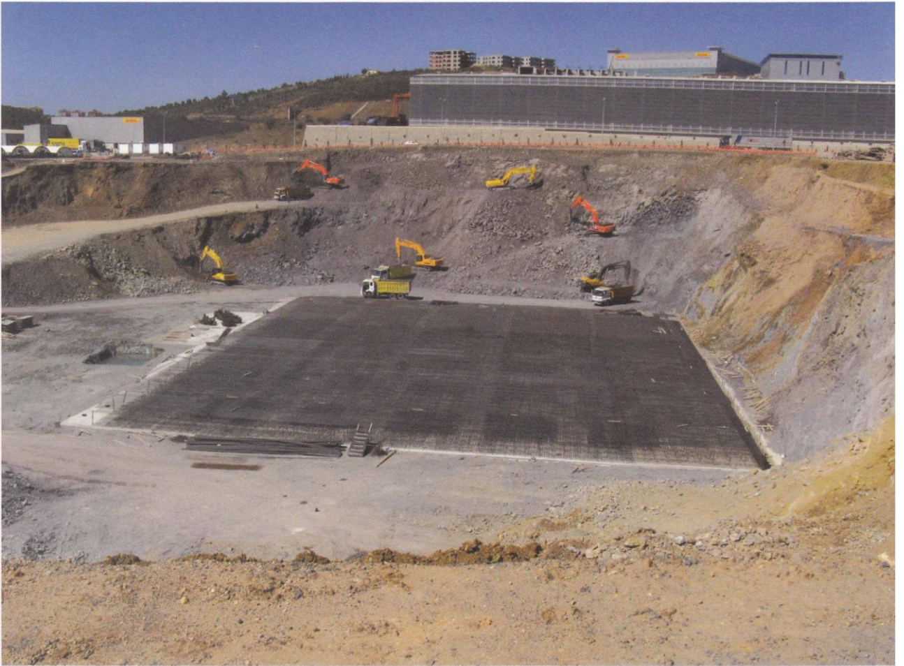
Proje: AVON Fabrikası, Alke İnşaat Yeri: Gebze-İzmit, 2006
