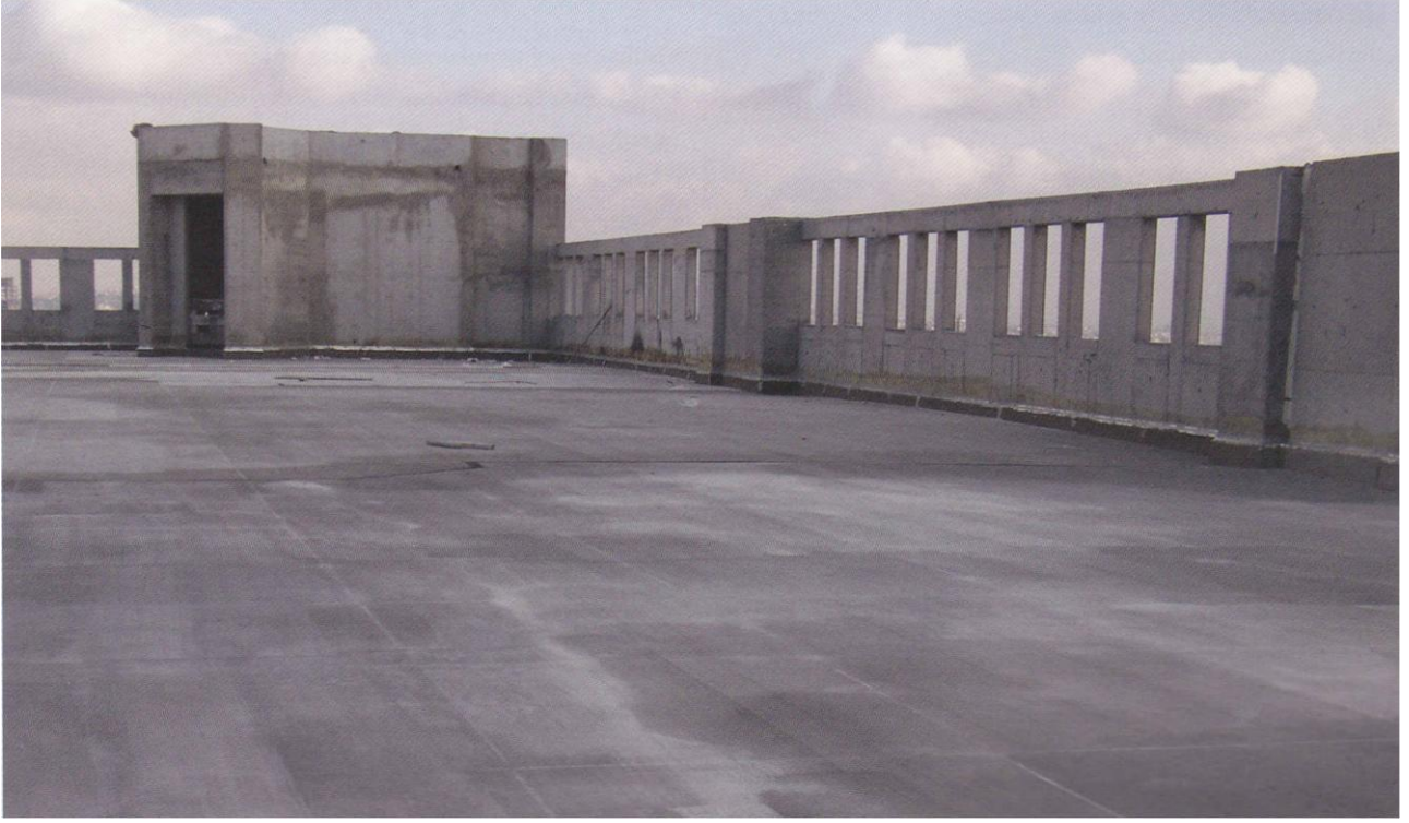
“Şekil 9.3” Elastomerik membran uygulaması.
