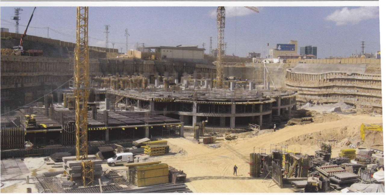
“Şekil 9.30” Nida İnşaat Yeri: Kozyatağı-İstanbul, PVC su yalıtım membran uygulaması.
