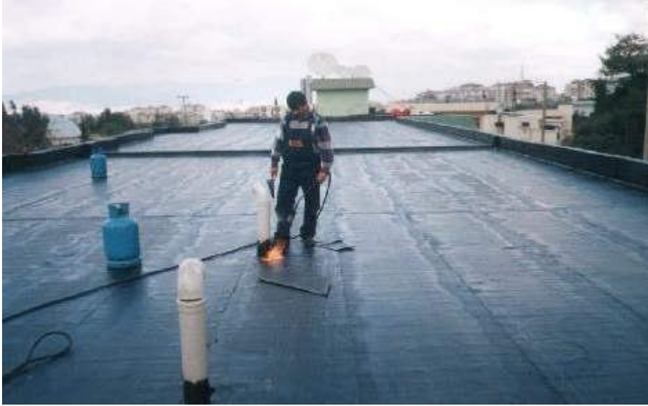
“Şekil 2.7” Teras Çatılarda Su Yalıtımı Örneği
