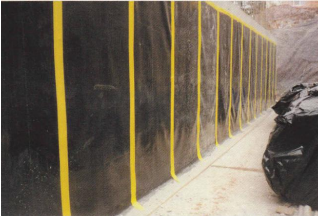
“Şekil 9.33” Bentonit membran uygulaması
