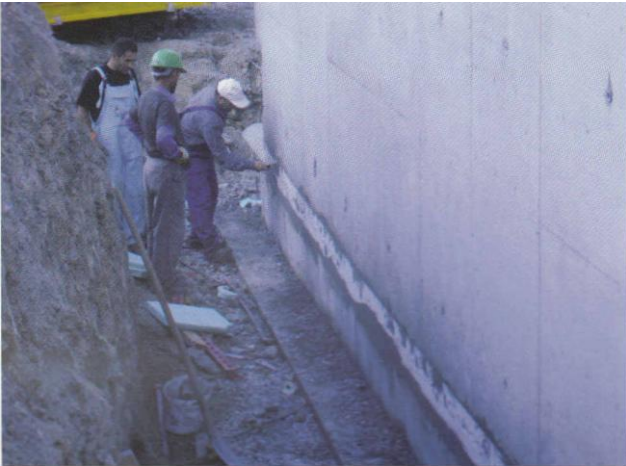
“Şekil 9.45” Kristalize kapiler esaslı su geçirimsizlik beton katkısı uygulaması
