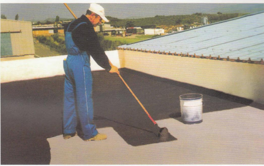
“Şekil 9.26” Likit membran uygulaması.
