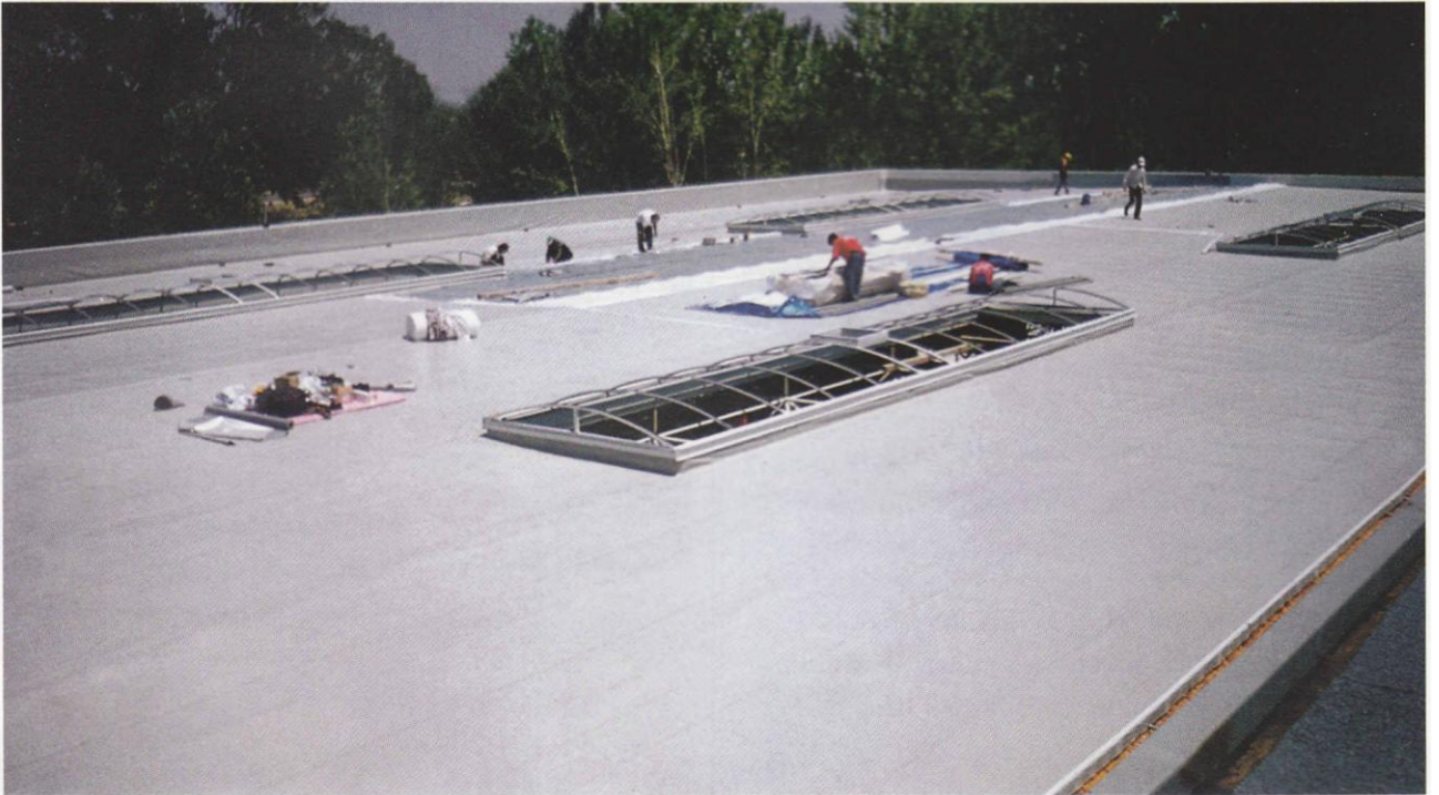
“Şekil 9.18” TPO membran uygulaması.
