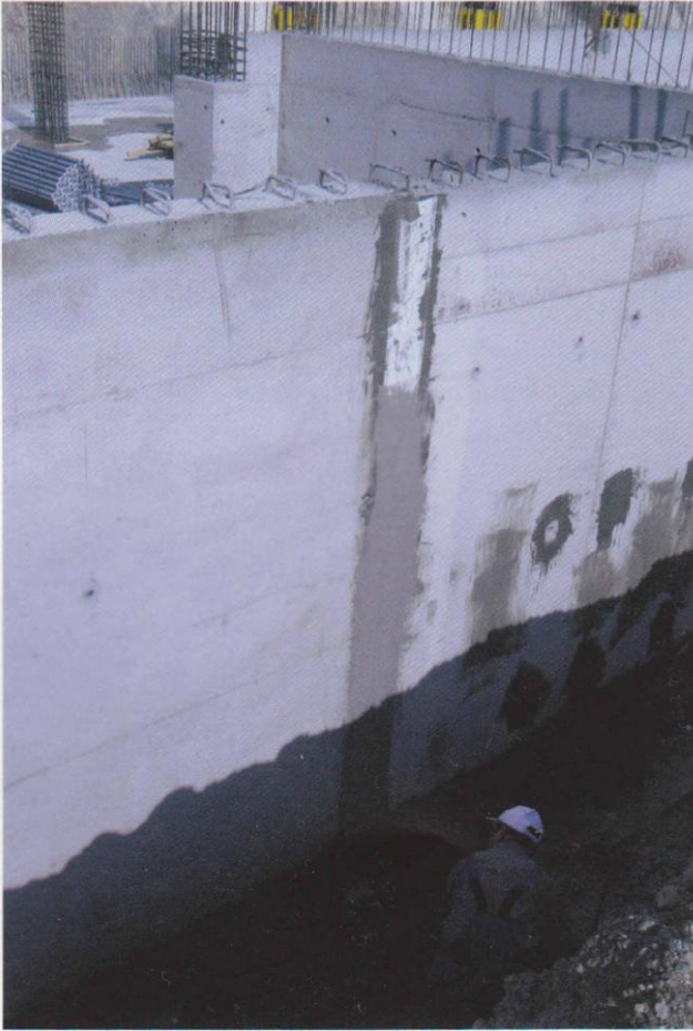
“Şekil 9.43” Çift komponentli elastik izolasyon harcı uygulaması.
