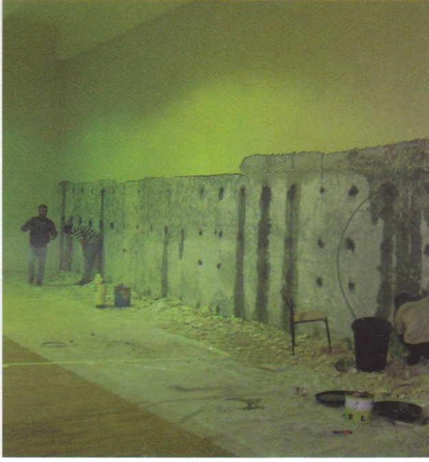
“Şekil 9.42” Elastomerik izolasyon harcı uygulaması.
