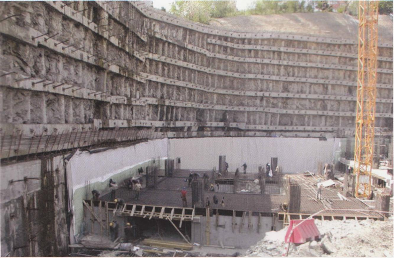
Proje: Boyner Alışveriş Merkezi-ÖZ-KA İnşaat Yeri: İkitelli-İstanbul, 2007-2008
