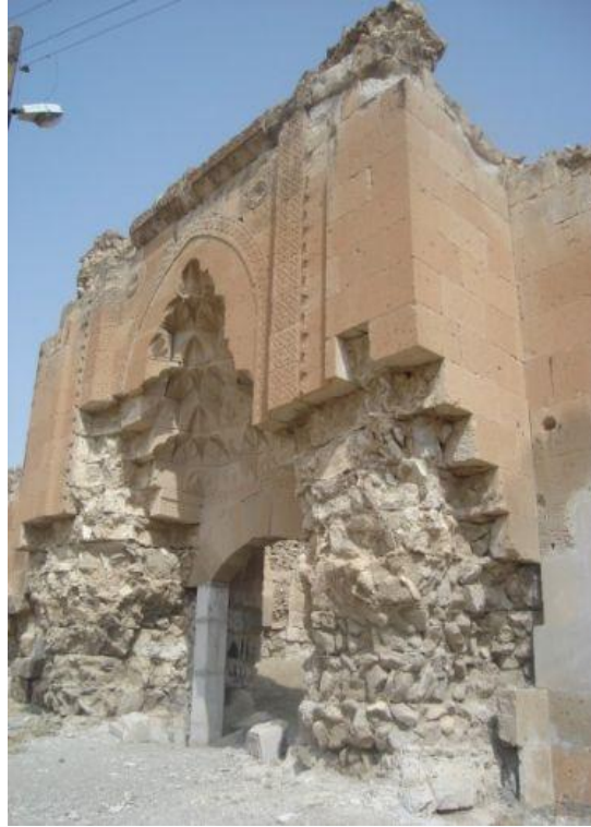
Resim 4.32 Alay han, güneydoğu cephesi giriş kapısı (Acun.H.2007)
