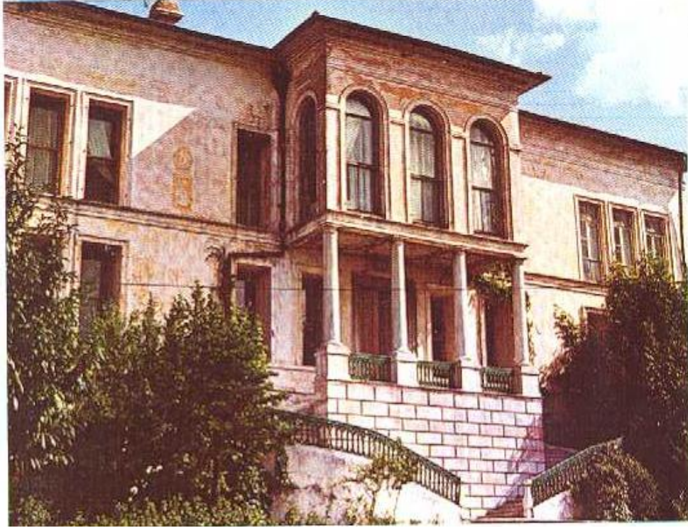
Resim 37: Adile Sultan Sarayının Görünümü
