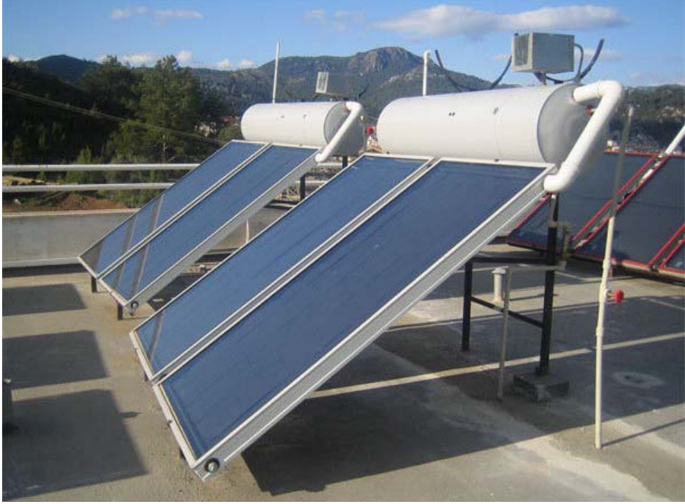
Fotoğraf 7. Aktif güneş enerjisi elemanı güneş kolektörü 96
