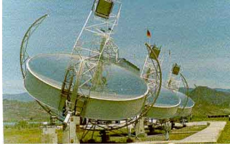
Fotoğraf 3. Parabolik çanak kolektör 78
