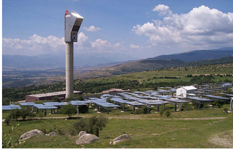
Fotoğraf 6. Heliostat Kule 86
