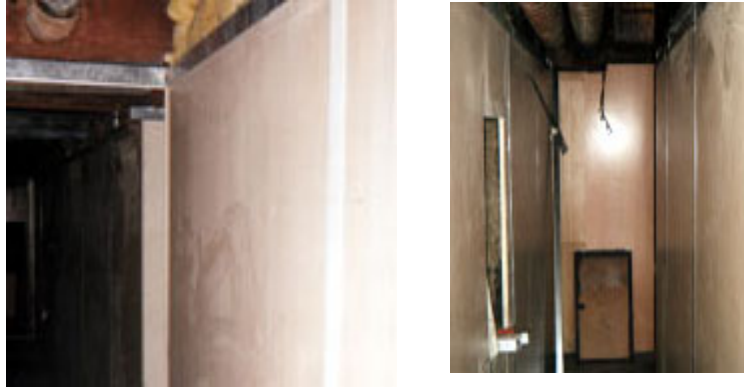
“Şekil 8.21” : Vermikülit esaslı yangın yalıtım paneli
