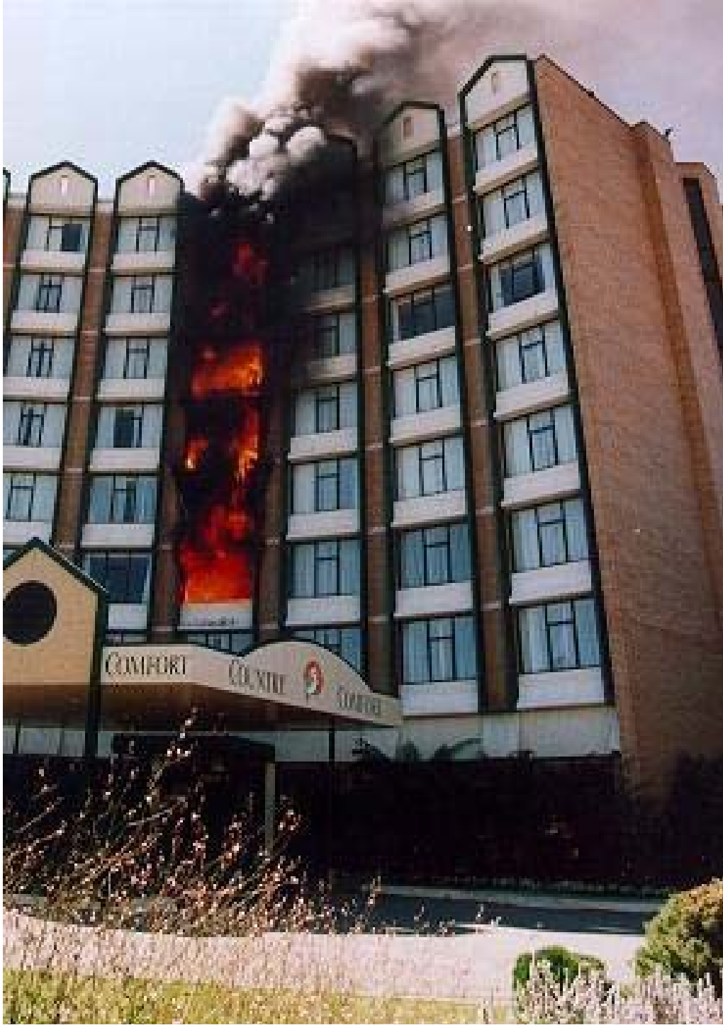
“Şekil 6.3” Bina Yangınlarında Duman ve Alevin Yönlenişi Motel fire, NSW, Australia 1999. Parapetlerde kullanılan PVC malzemenin yangını desteklemesi ile üst katlara yayılan cephe yangını
