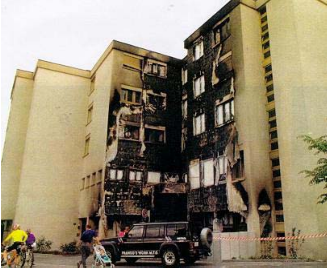
“Şekil 6.2” Bina Yangınlarında Duman ve Alevin Yönlenişi Apartment Building, Munich,1996. Yanıcı cephe kaplamasının bir çöp varilinden alev alması sonucu cephe yangını oluşmuştur.
