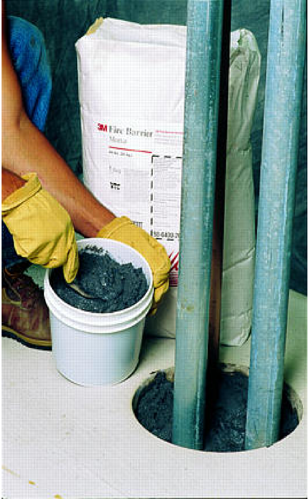
“Şekil 8.27’’: Yangın koruyucu harçla tesisatın yalıtımı
