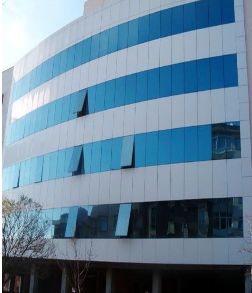
Resim 6.1. Giydirme Cephe Örneği
