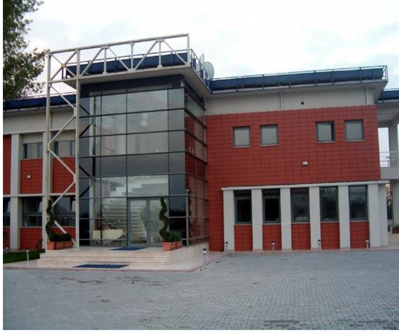
Resim 6.4. Giydirme Cephe Örneği
