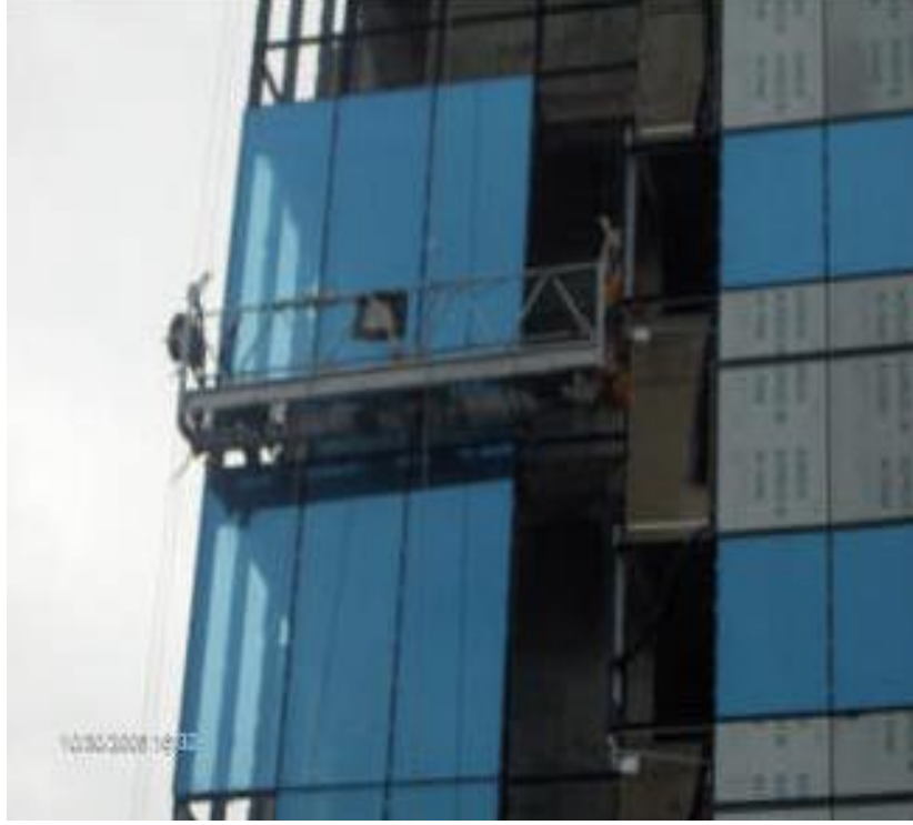
Resim 5.1. Cam Malzeme Montajı İçin Yatayda ve Düşeyde Hareket Edebilen Asma İskele
