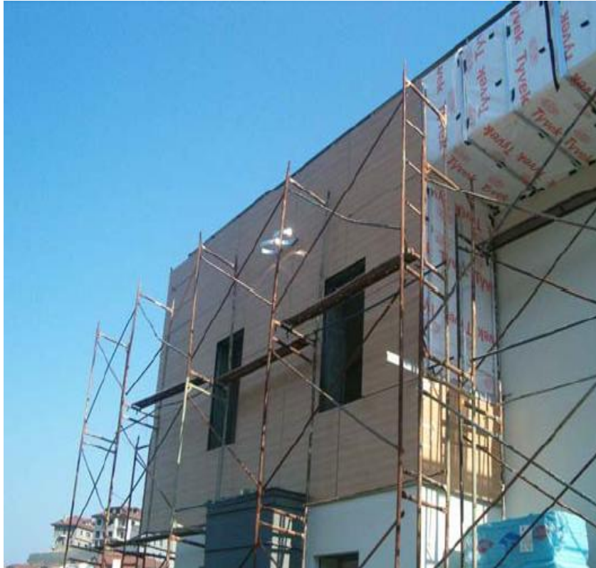
Resim 4.20. Kompakt Laminat Giydirme Cephe Sistemi Arkasında Isı Yalıtımı ve Buhar Dengeleyici Uygulaması (Acarkent Ergun Işıkel Evi)
