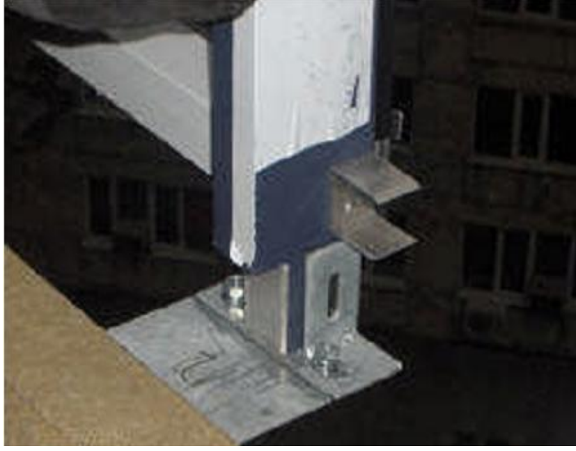
Resim 5.21. Yatay Profillerin Düşey Profillerde Monte Edilen Takozlara Yerleştirilerek Montajının Yapılması
