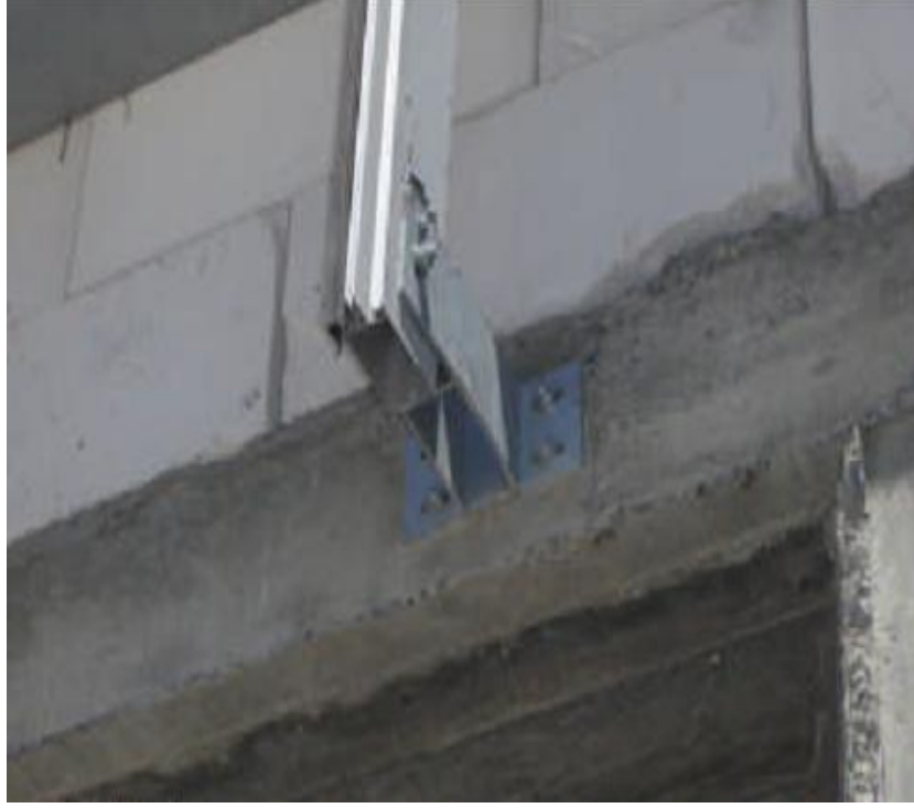
Resim 5.11. Kiriş Önden Montajı Yapılan Ankraj
