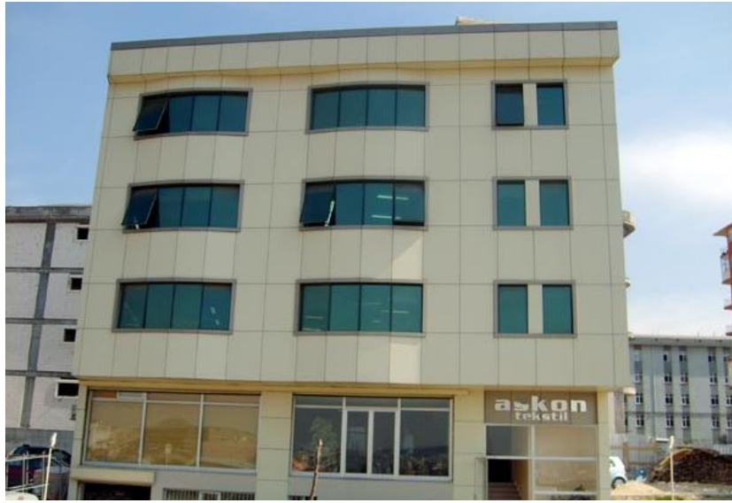
Resim 6.5. Giydirme Cephe Örneği
