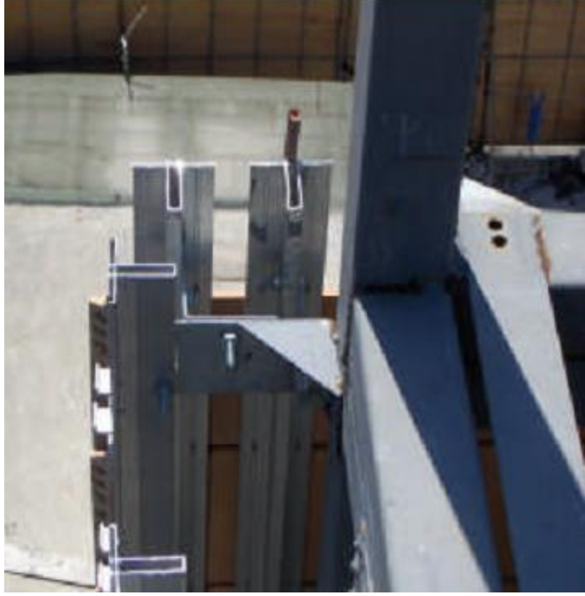
Resim 5.25. Montajı Tamamlanmış Kaplamanın Köşe Detayı
