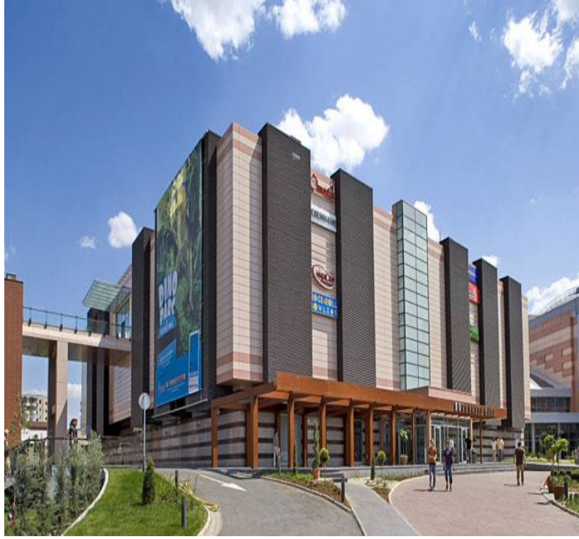
Resim 4.12. Kompozit Panel Cephe Görünüşü (Bucuresti Mall, Bükreş, Romanya,2006)
