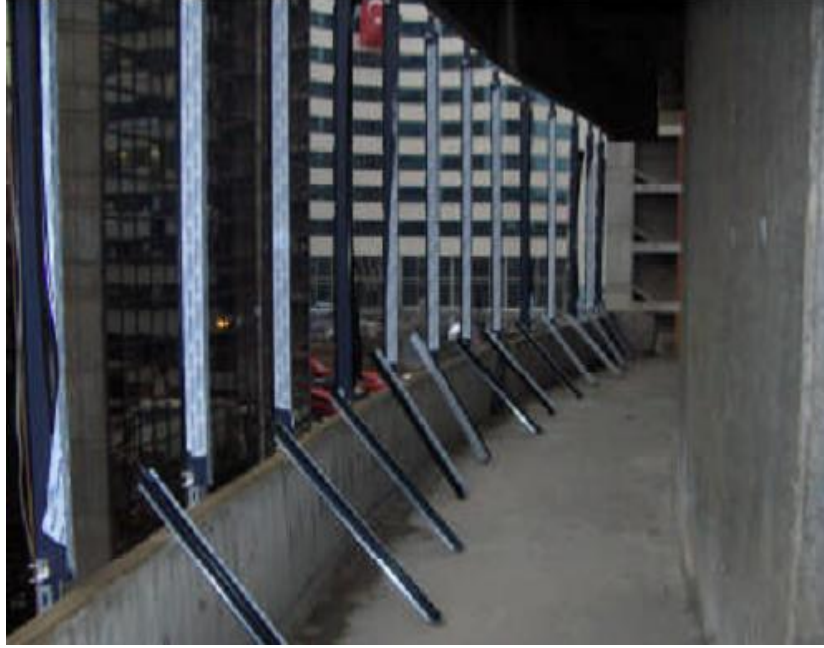
Resim 5.19. Yatay Profillerin DüŖey Profillere Montaj Hazırlığı
