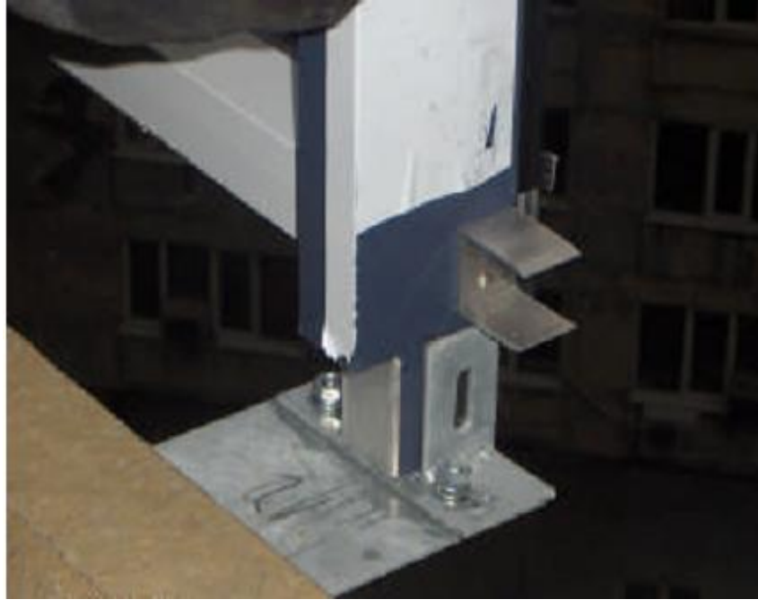
Resim 5.4. Ankrajları Parapet Duvara Montajı Yapılan Bina Cephesi
