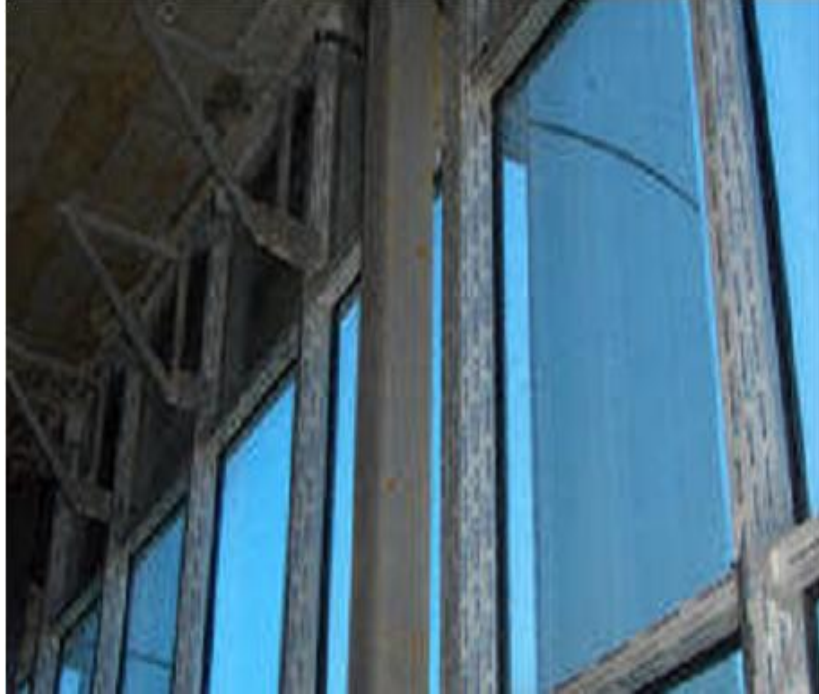
Resim 5.23. Kiriş Altına Sabitlenmiş Ankrajlar, Montajı Tamamlanmış Profiller
