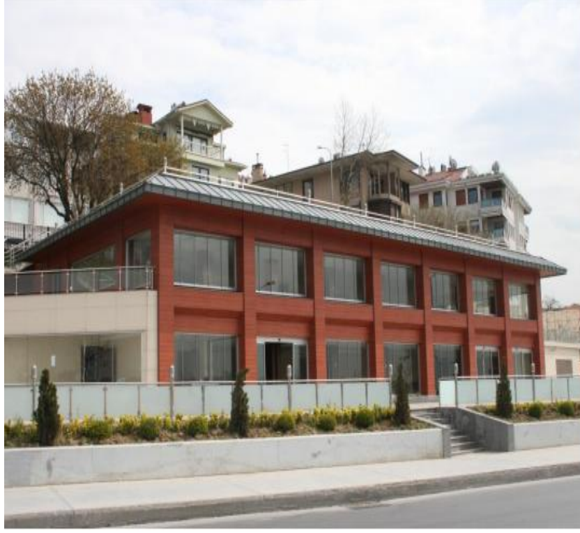
Resim 4.21. Kompakt Laminat Giydirme Cephe Görünüşü
