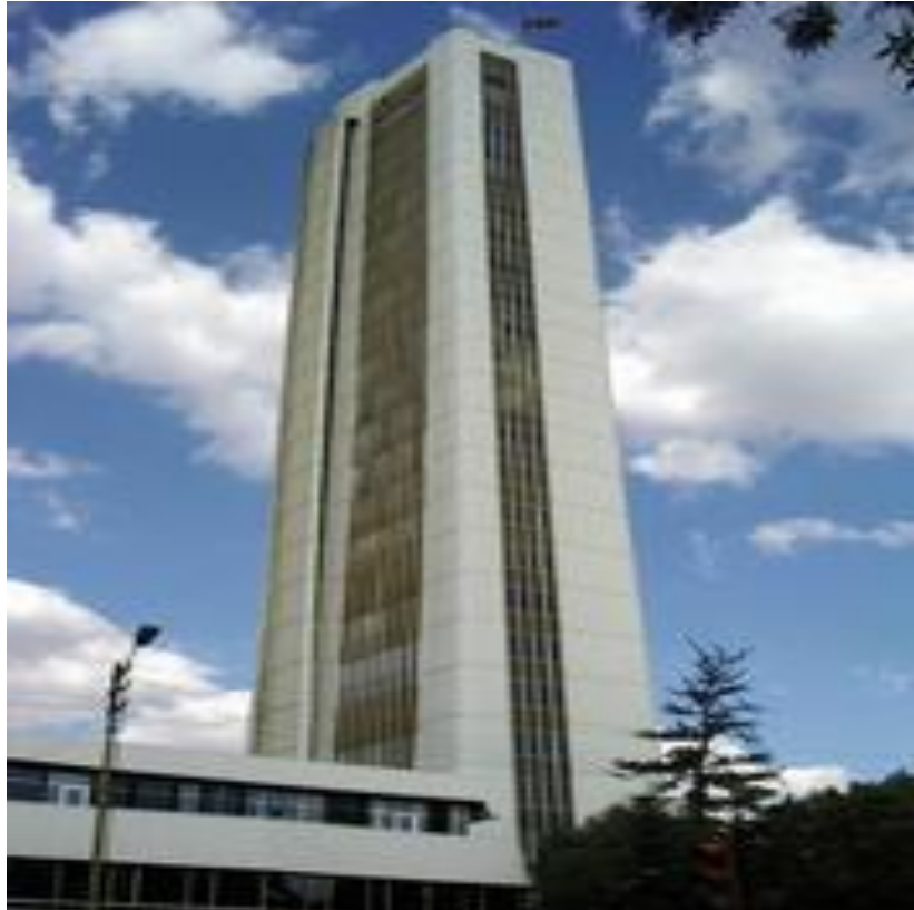
Resim 3.3. Giydirme Cephe Örneği (Türkiye İş Bankası)
