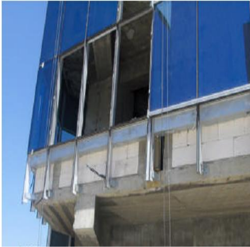
Resim 5.18. Katlar Arası Sızdırmazlık Profili Görünüşü
