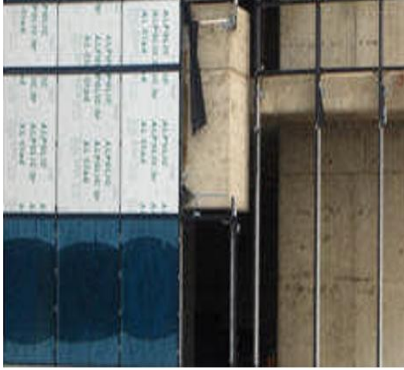
Resim 5.5. Ankrāj Montaj Tamamlanan ve Devam Eden Cephe Görünüşü
