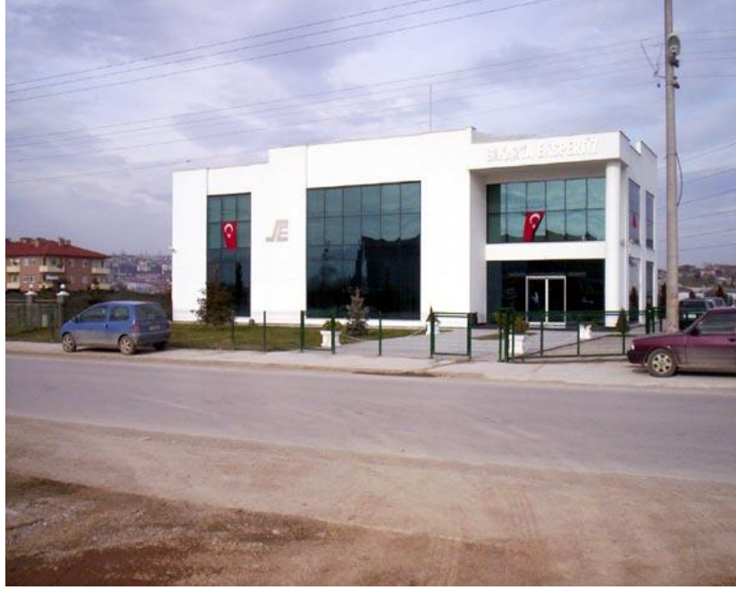
Resim 6.2. Giydirme Cephe Örneği
