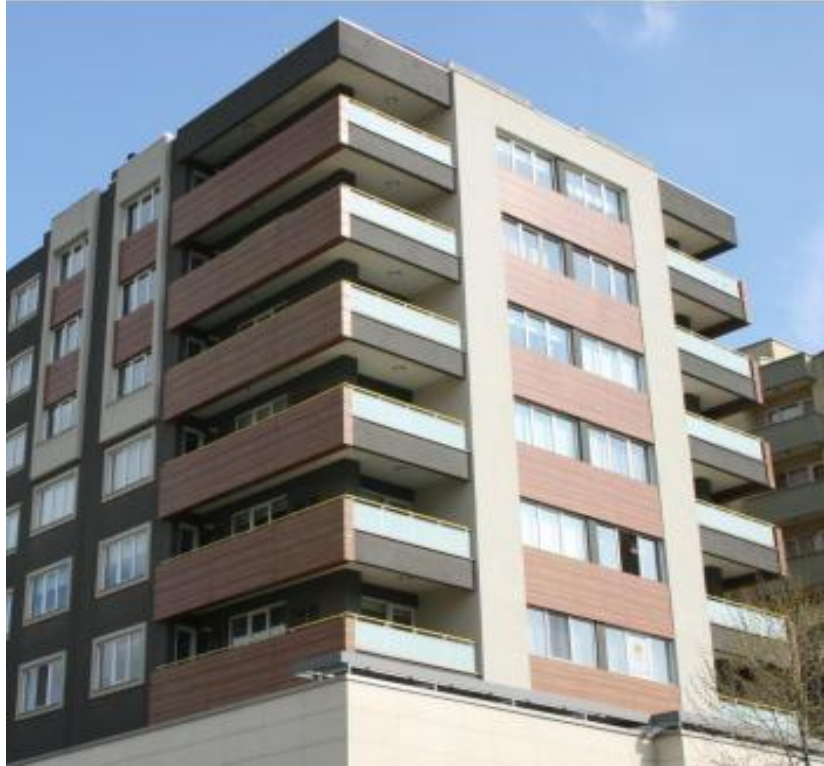
Resim 4.22. Kompakt Laminat Giydirme Cephe Görünüşü
