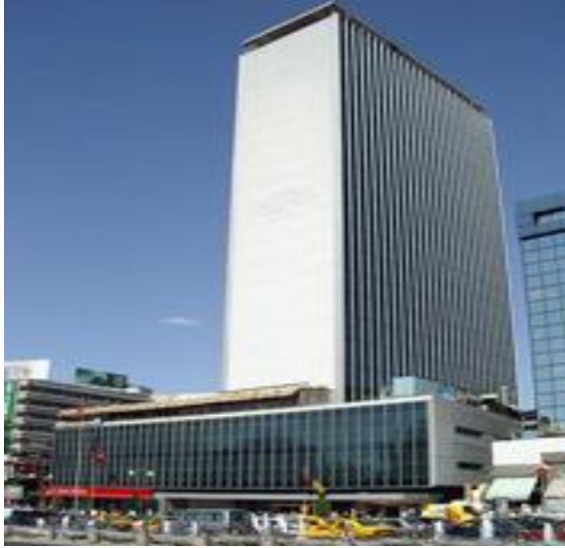
Resim 3.2. Giydirme Cephe Örneği (Kızılay Emek İşhanı)
