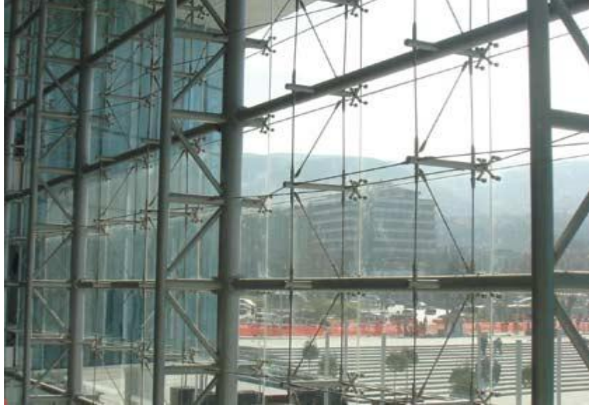
Resim 4.4. Transparan Giydirme Cephe Bağlantı Elemanları Örneği
