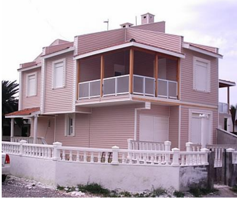
Resim 4.27. Yalı Baskısı Sistemi Uygulanan Cephe Görünüşü (Çeşme Mercan Koy Evleri, Çeşme)
