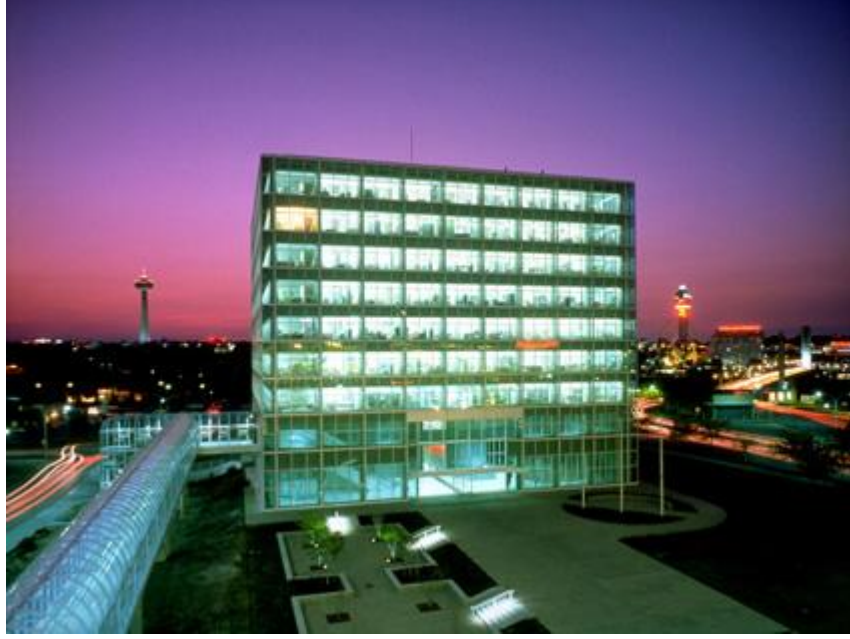
Resim 4.31. Bina Yüksekliğinde Havalandırma Kanallı Çift Tabakalı Sistem Dış Görünüşü (Occidental Chemical Centre Binası)
