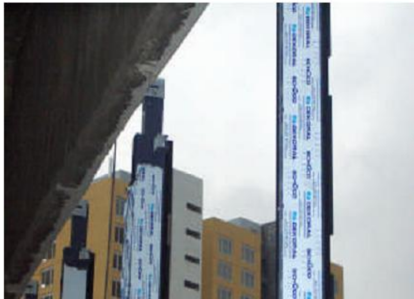
Resim 5.14. Ankrajlara Monte Edilen Düşey Profiller
