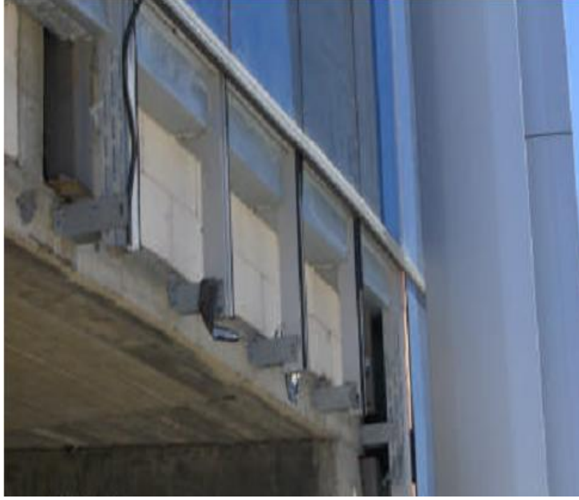
Resim 5.17. Cephede Düşey Profillerin Bitiş Noktaları
