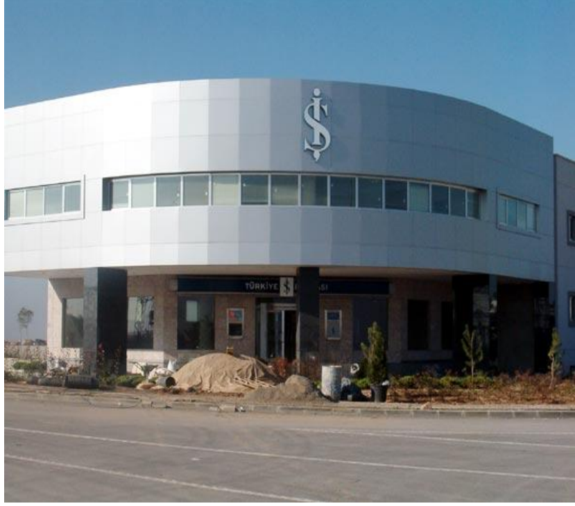
Resim 6.10. Giydirme Cephe Örneği
