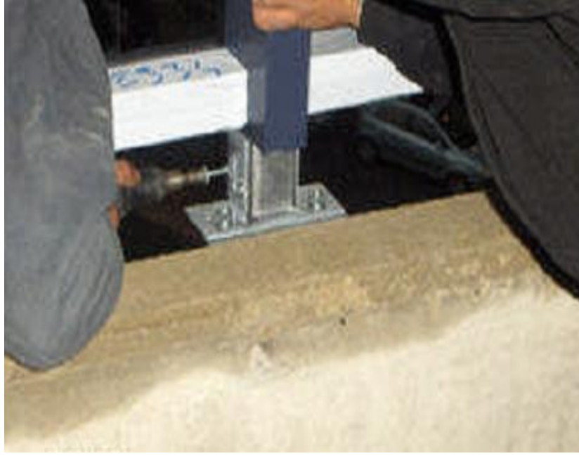
Resim 5.13. Profillerin, Ankrajlara Çelik Cıvata ve Vidalarla Monte Edilmesi
