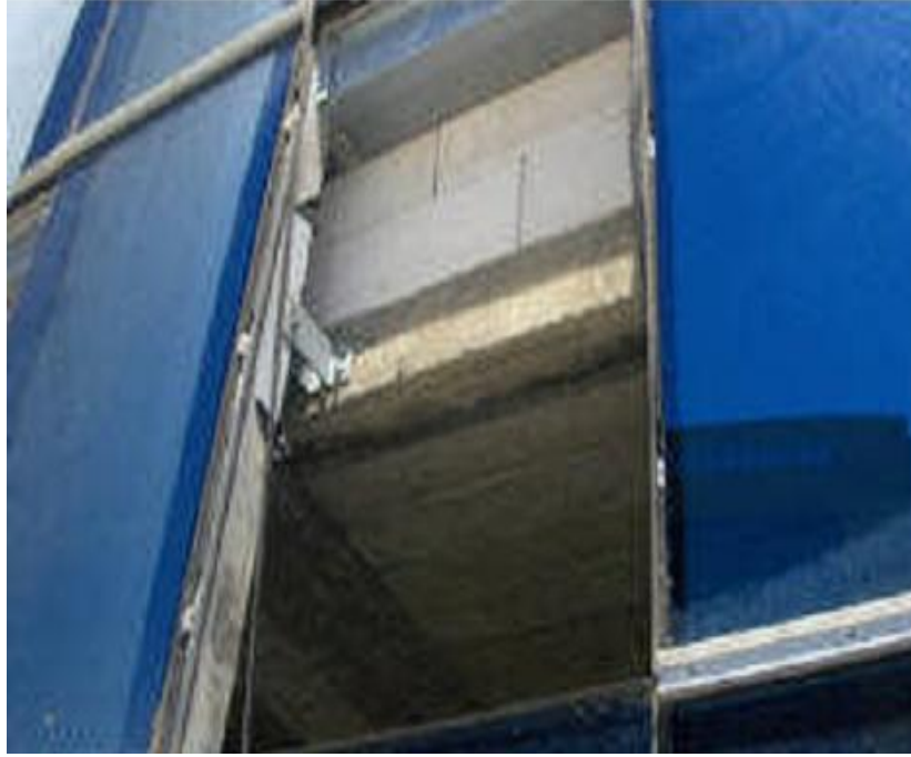
Resim 5.26. Montajı Tamamlanmış Cephe Görünüşü
