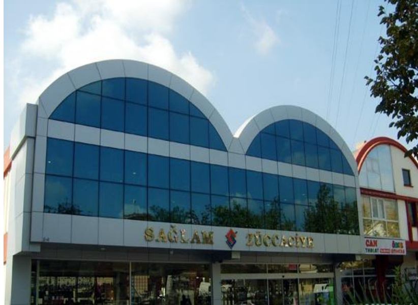
Resim 6.11. Giydirme Cephe Örneği
