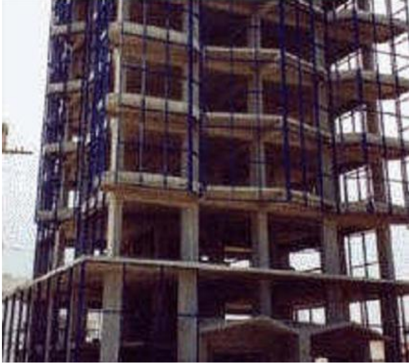
Resim 5.22. Düşey ve Yatay Profilleri Döşenmiş Cephe Görünüşü
