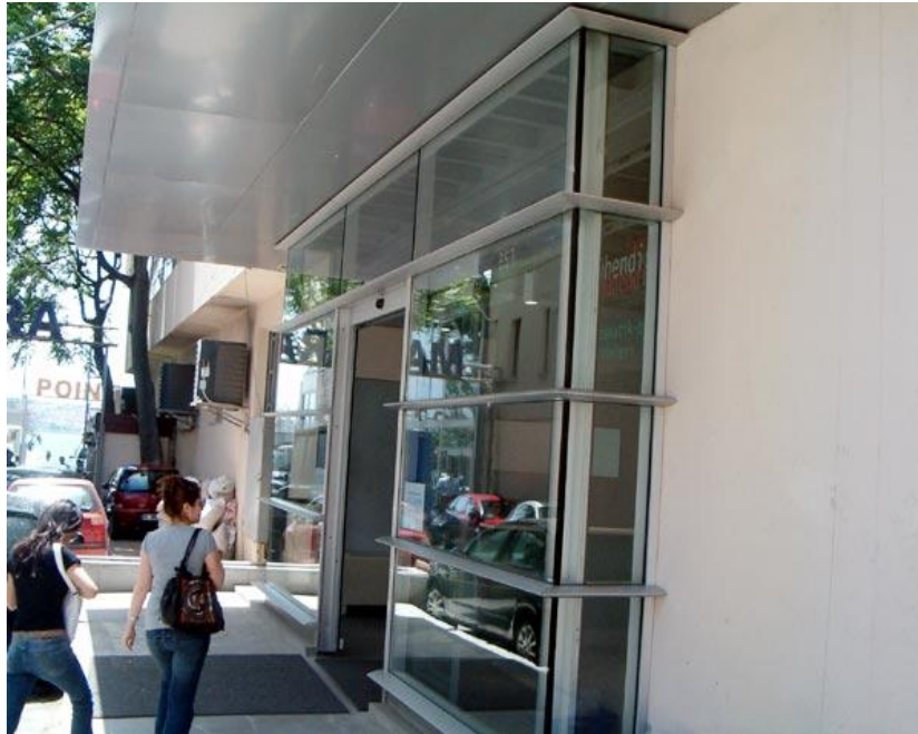
Resim 6.3. Giydirme Cephe Örneği
