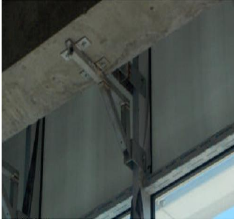
Resim 5.10. Kiriş Altı Montajı Yapılan Ankraj
