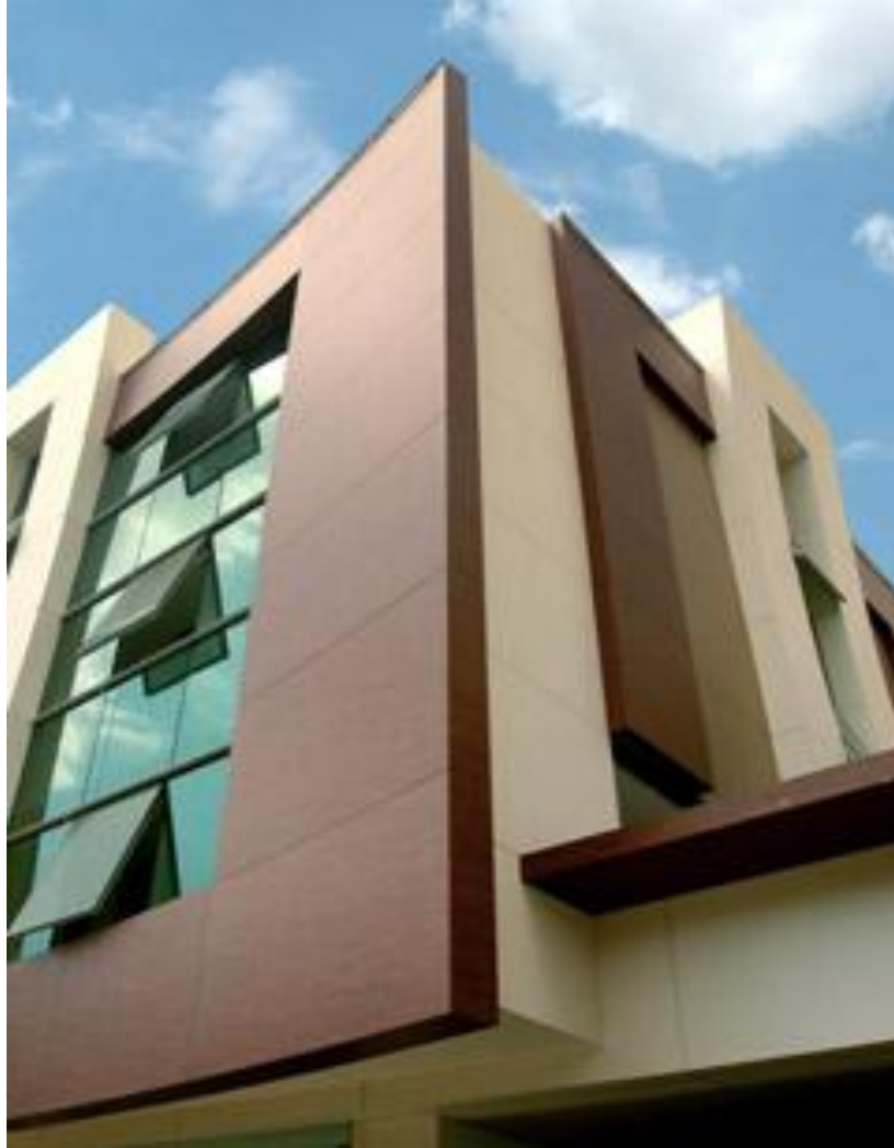
Resim 4.26. Perçinli Sistem Uygulanan Cephe Görüntüsü
