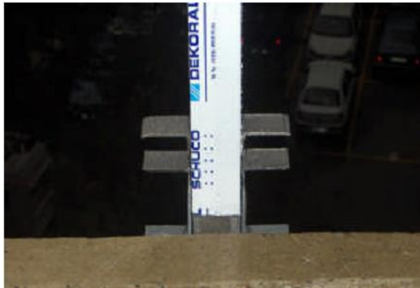
Resim 5.20. DüŖey Profillerde Profiller İçin Monte Edilen Takozlar
