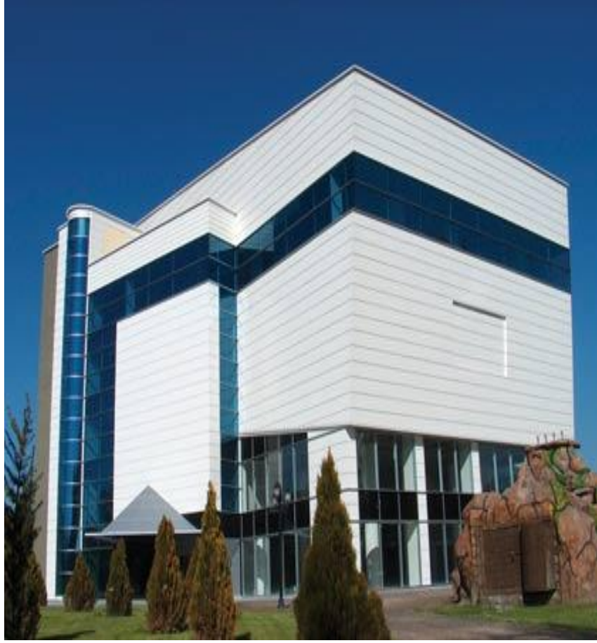
Resim 4.13. Alüminyum Kompozit Panel Cephe Görünüşü (Gülsoylar Alışveriş Merkezi, Kayseri)
