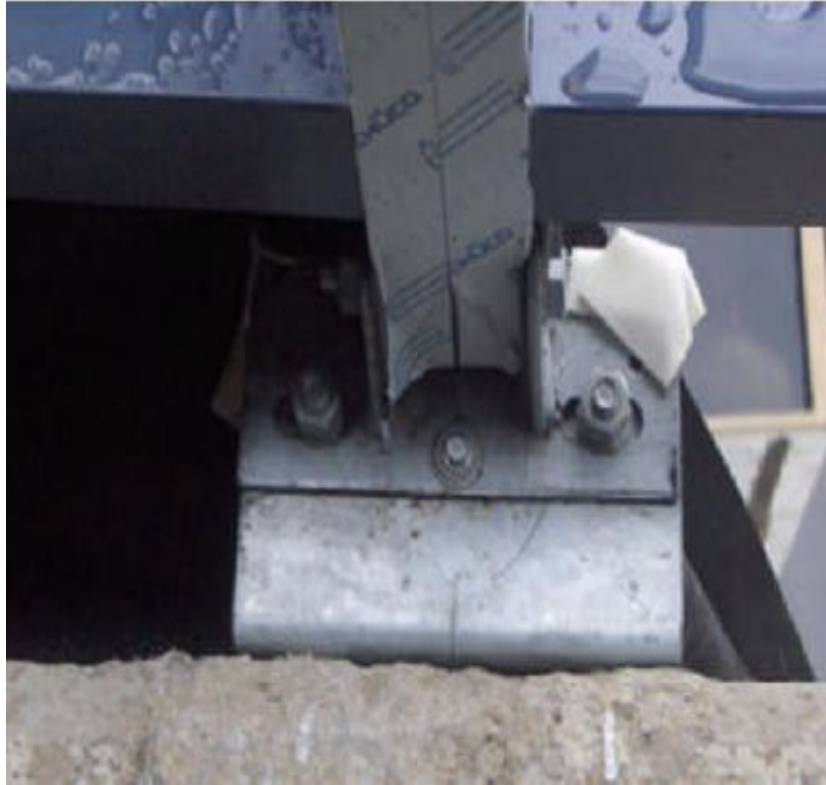
Resim 5.8. Parapet Duvara Koordinatlar Taşınarak Yapılan Ankraj
