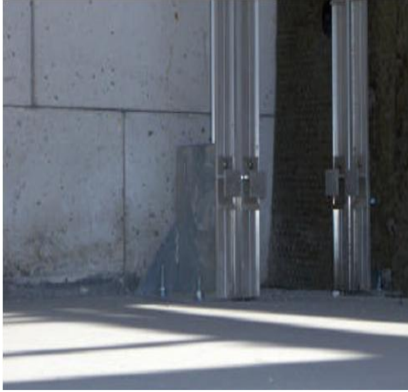
Resim 5.9. Döşemeye Montajı Yapılan Ankraj Montajı
