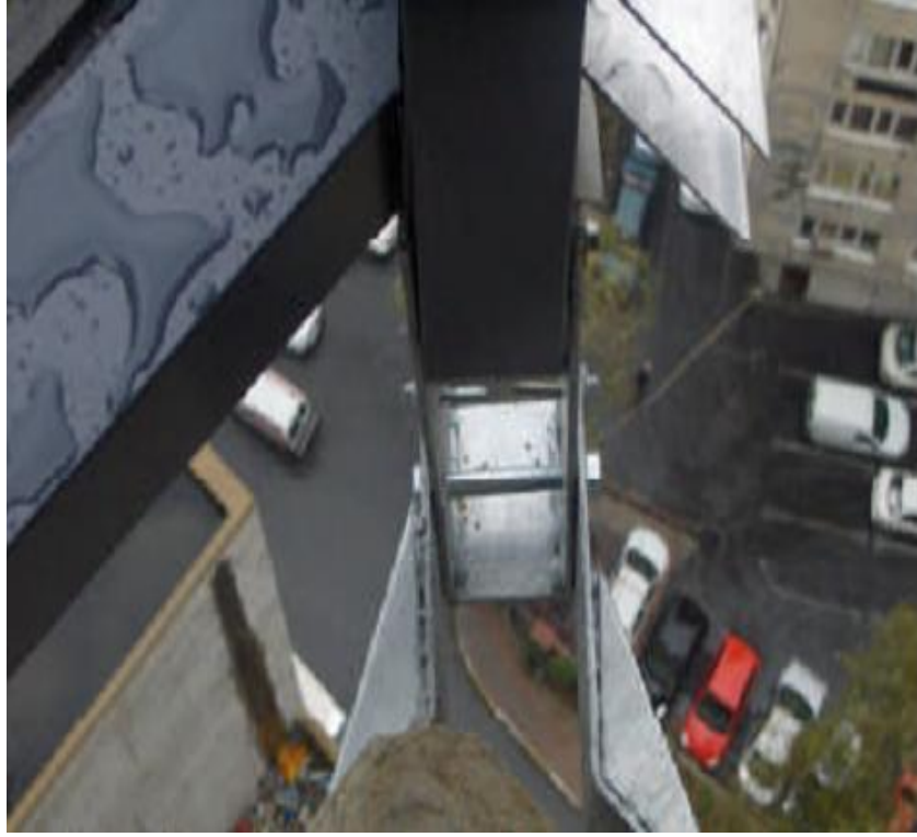
Resim 5.7. Betonarme Yüzeye Sabitlenen Köşe Ankraj
