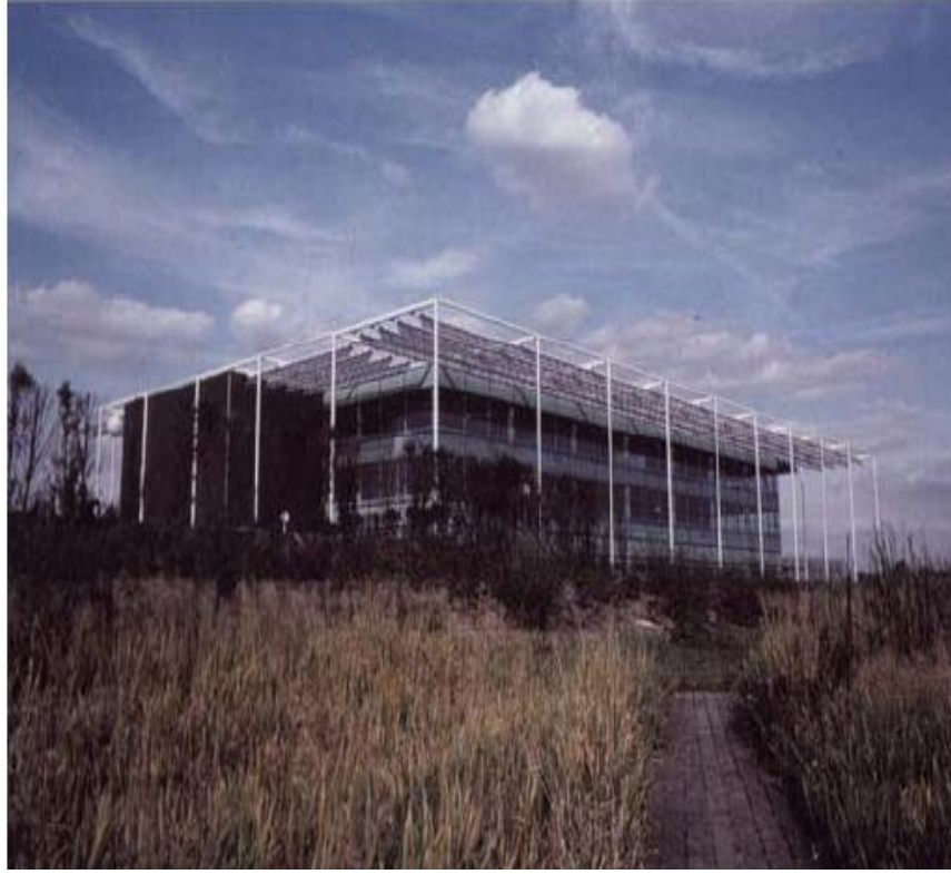
Resim 4.28. Dıştan Gölgelemeli Tek Tabakalı Cephe Örneği
