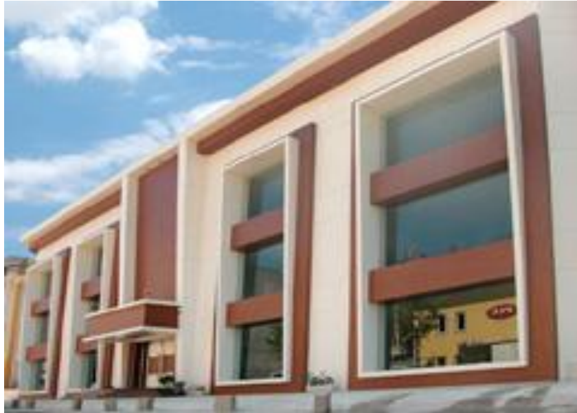
Resim 4.24. Yapıştırma Sistem Uygulaması Cephe Görünüşü (Lula Concept ,Y.Dudullu /İstanbul)
