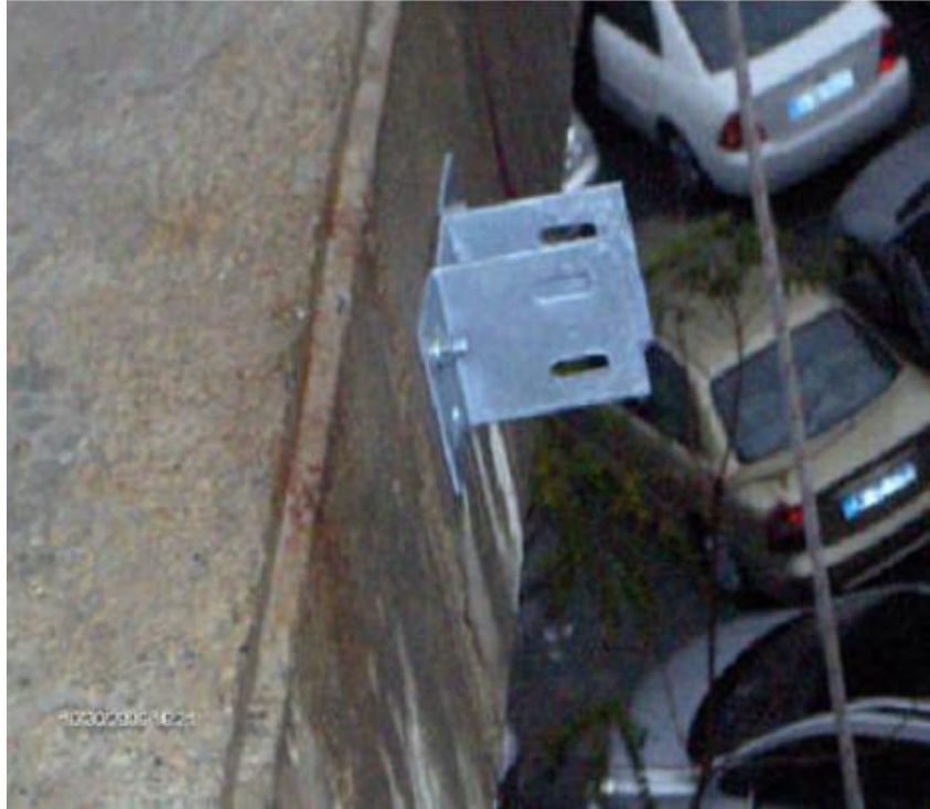
Resim 5.6. Betonarme Yüzeye Sabitlenen Ankrāj
