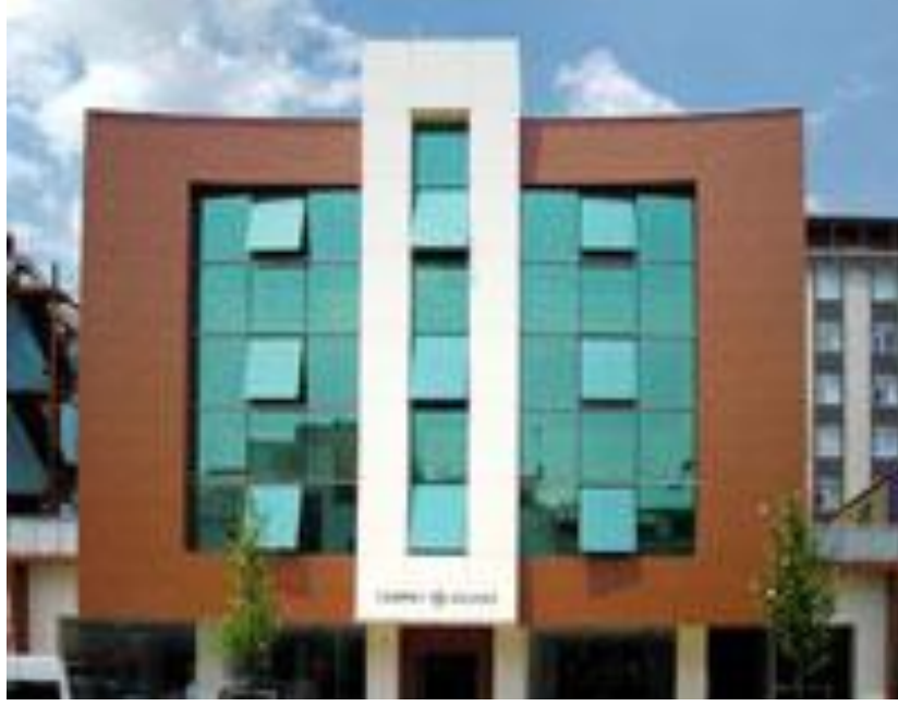
Resim 4.25. Agraflı Askı Sistemi Uygulaması Cephe Görünüşü (Nurpark Kumaş, Merter/İstanbul)
