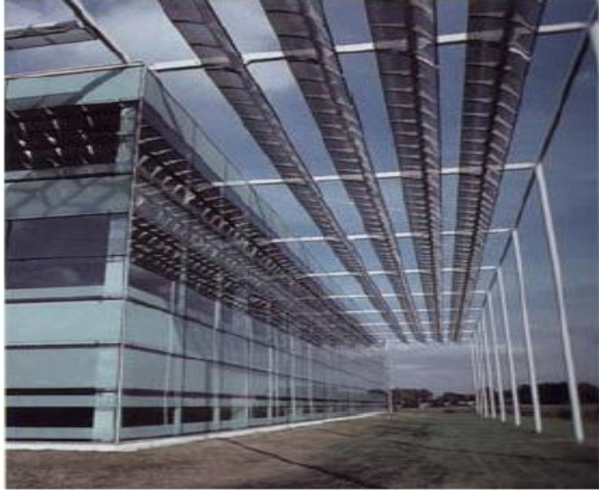
Resim 4.29. Dıştan Gölgelemeli Tek Tabakalı Cephe Görünüşü
