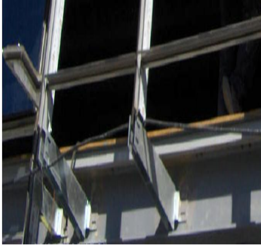
Resim 5.12. Ön Cephede Çelik Kiriş Kaynakla Yapılan Ankraj Montajı
