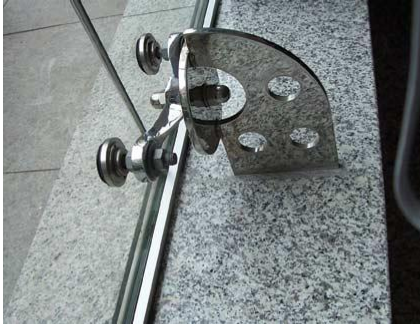
Resim 4.3. Cephe Bağlantı Elemanı Örneği
