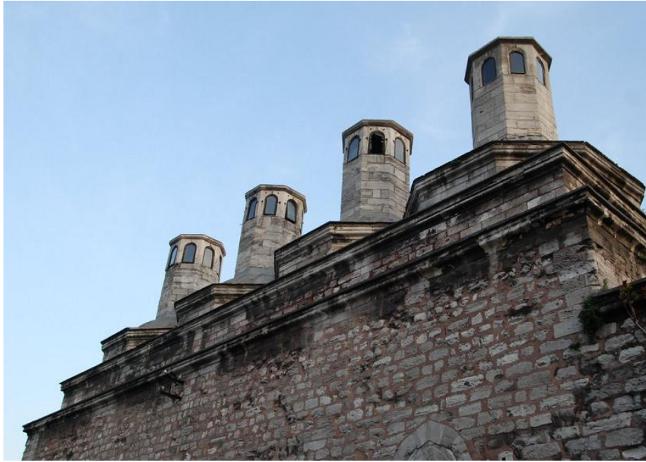
Fotoğraf 2.8 : Haseki Darüşşifası Cephesinden Görünüm
