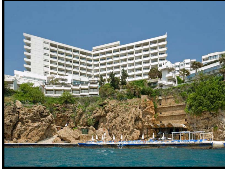
Şekil 4.9: (Kaynak: www.mavarethouse.com, 2010), Divan Antalya Hotel, Bina Görünüşü
