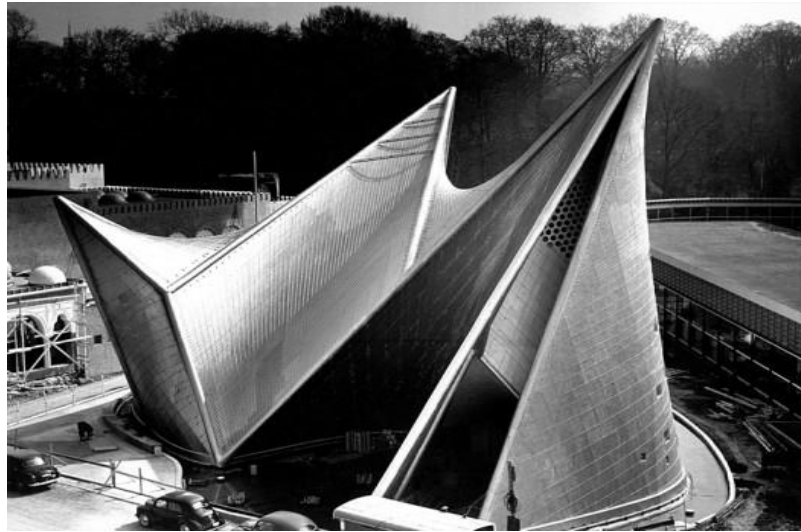
Resim 3.4. Brüksel dünya fuarı'nda le corbusier'in philips firması için gerçekleştirdiği hiperbolik paraboloid yapı 38
