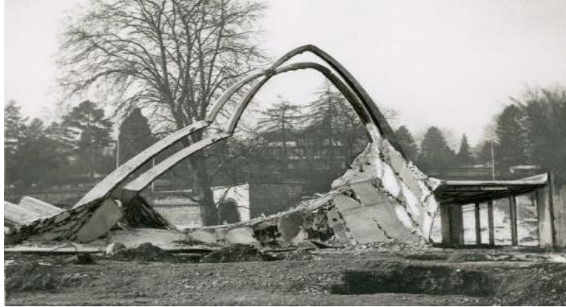
Resim 3.7. Zementhalle (Kabuğun Çökmesi), Zürih 41
