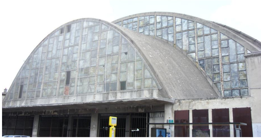
Resim 3.11. Algericas hal binası, İspanya 45
