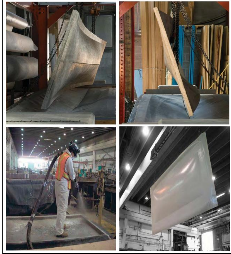
Resim 1.5. Püskürtme yöntemi ile yapılan kompozit esaslı prekast kabuk kalıp yapımı (2) 22
