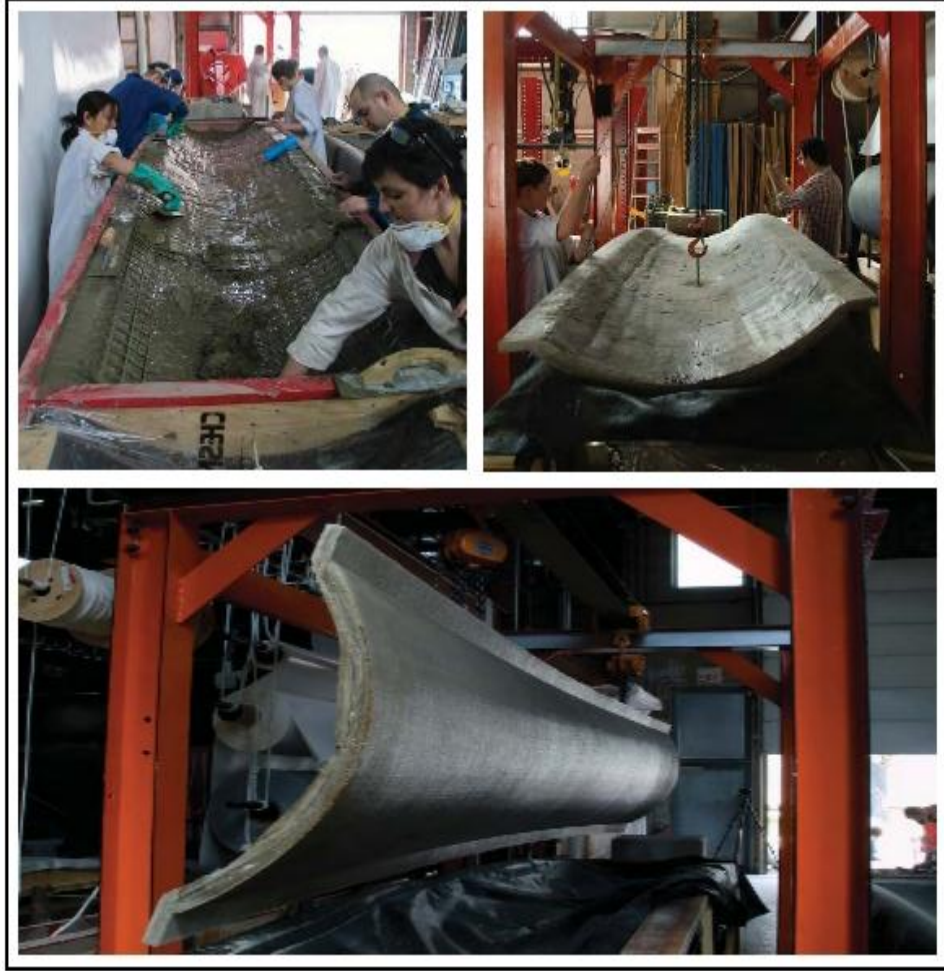
Resim 1.3. El yatırma yöntemi ile yapılan kompozit esaslı prekast kabuk kalıp yapımı (2) 21
