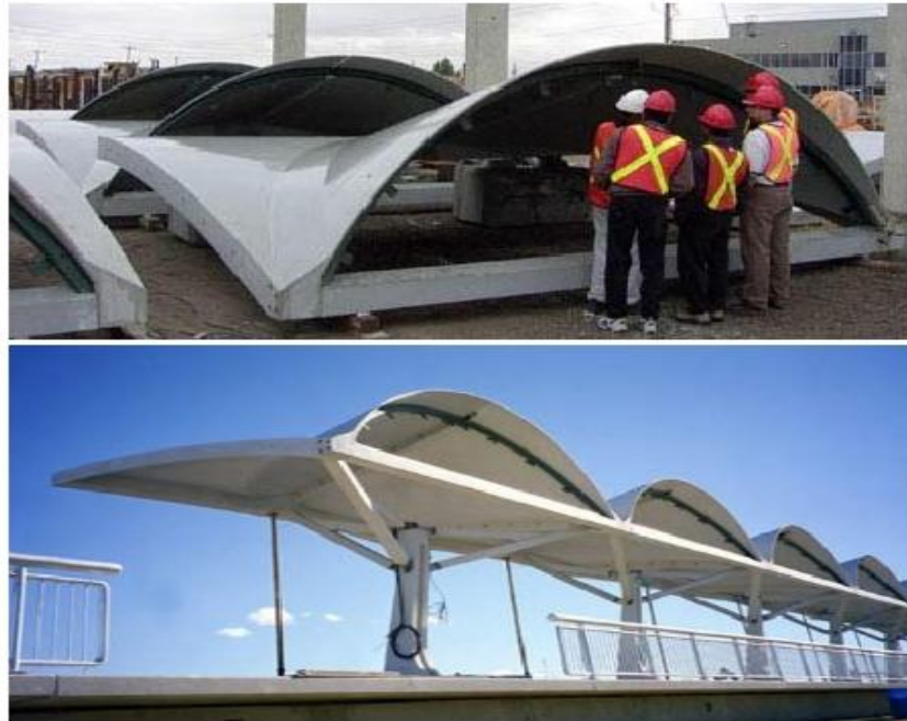
Resim 2.3. Kompozit Esaslı Kalıp Dökümlü Prefabrik Çatı Kaplaması 33
