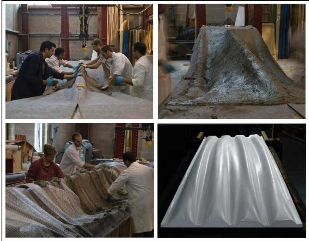
Resim 1.2. El yatırma yöntemi ile yapılan kompozit esash prekast kabuk kalıp yapımı (1)
