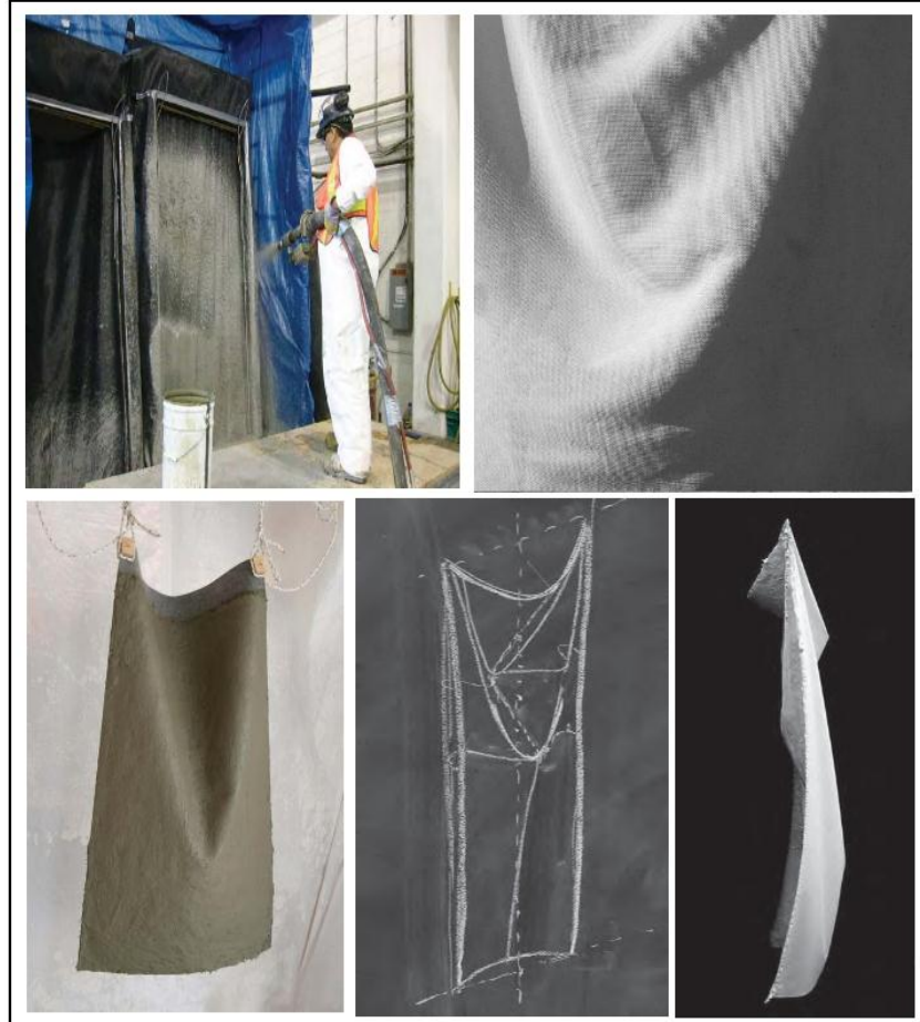
Resim 1.4. Püskürtme yöntemi ile yapılan kompozit esaslı prekast kabuk kalıp yapımı (1)
