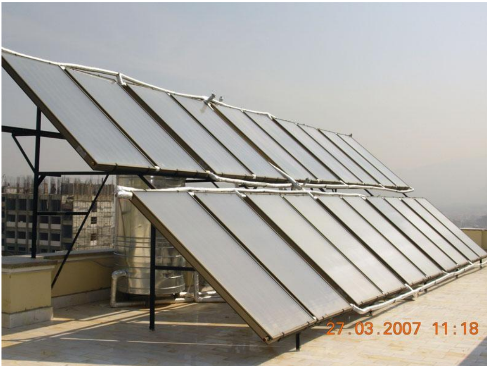
Resim 7.29:Isıtma ve Sıcak Su İhtiyacı için Kurulan Güneş Kollektörü Sistemi
