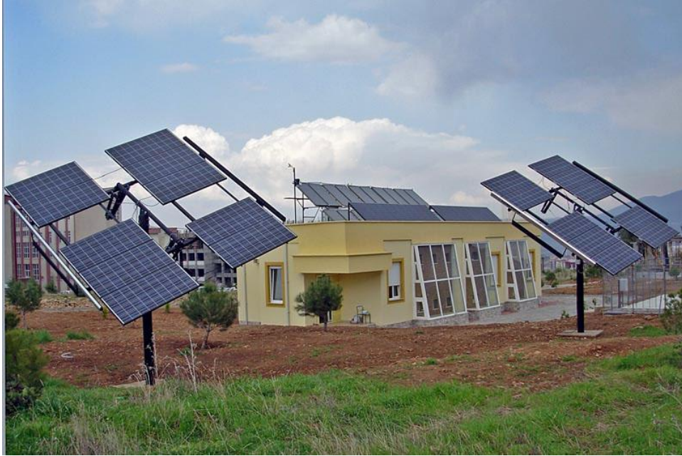
Resim 7.25: Evin Güney Cephesi ve Tek Eksenli Pasif Güneş İzleyicileri
