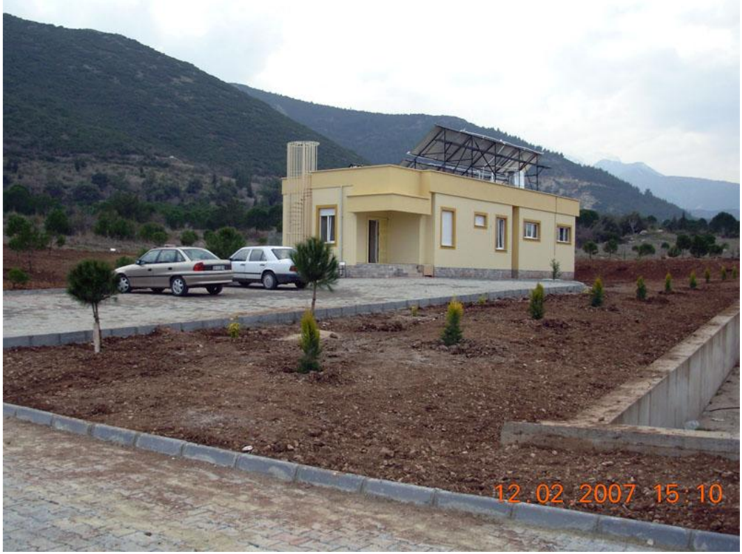
Resim 7.26:Evin Kuzey Cephesi
