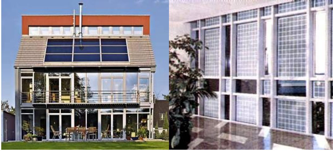
Resim 5.7: Fotovoltaik Sistemlerin Çatıda, Cephede Kullanımı
