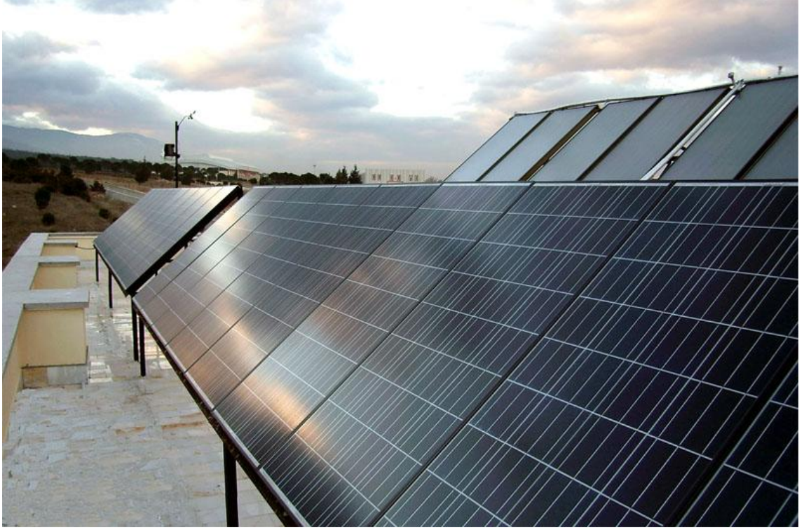
Resim 7.28:Çatıya Yerleştirilen Sabit Açılı Güneş Pili Panelleri ve Kollektörler
