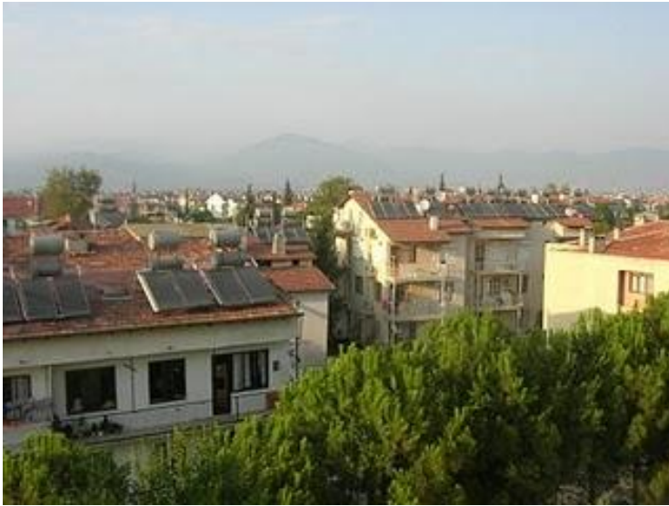
Resim 7.31:Konut Çatılarında Güneş Enerjisi Panellerinin Görünümü
