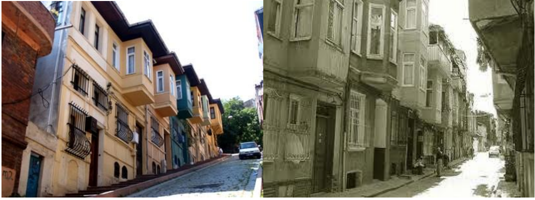
Resim 2.27: Yapı strüktürleri rehabilitasyonu
