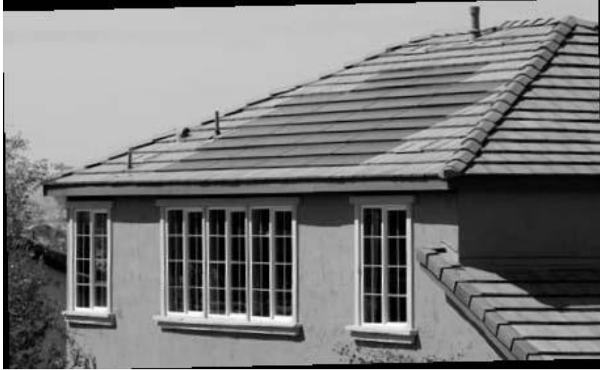
Resim 6.1:Yapıda çatı kiremidine entegre edilmiş panel uygulaması
