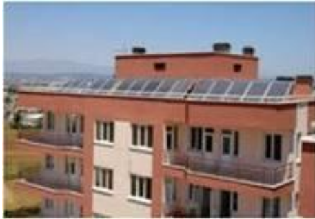
Resim 7.33:Çatılarda Güneş Sistemleri
