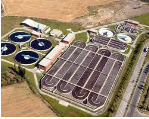
Resim 3.18: Atık Su Dönüşüm Tesisi
