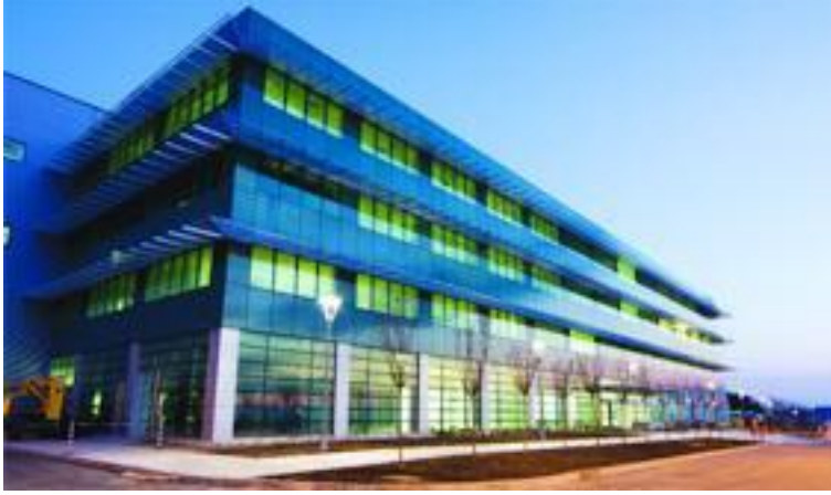
Resim 4.13: Yeşil Bina Monitörlü Siemens Binası
