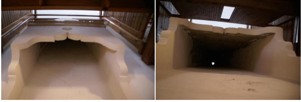
Resim 2.13 Yaşmak ve İçindeki Hava Bacası
