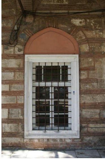
Resim 2.16. Erkekler Soyunmalık Bölümünün Zemin Kat Kotundaki Lokma Parmaklıklılı Pencere
