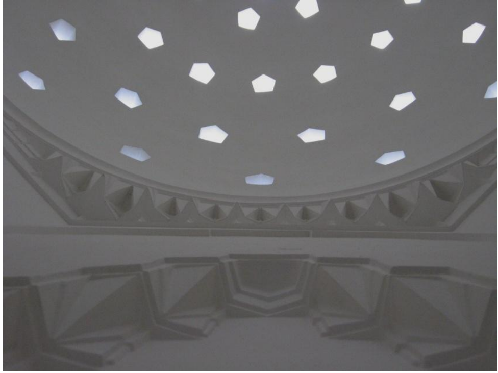
Resim 2.35. .Sıcaklık Bölümü Kubbesi
