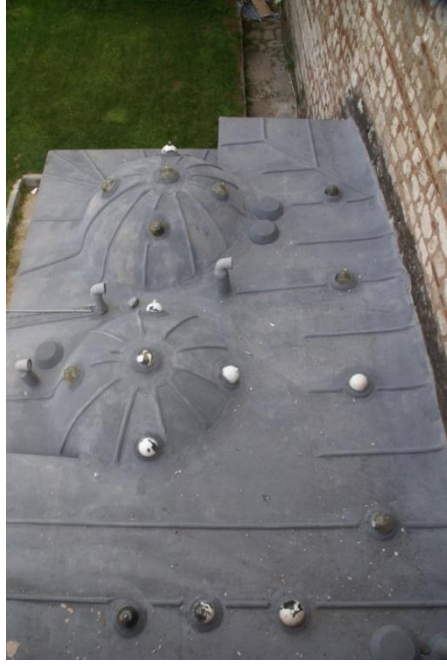
Resim 2.26. İki Kubbe Ve Bir Düz Bölümden Oluşan Tuvalet Üst Örtüsü
