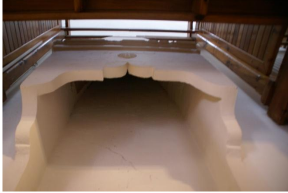
Resim 1.6. Yağmaklı Havalandırma Bacası
