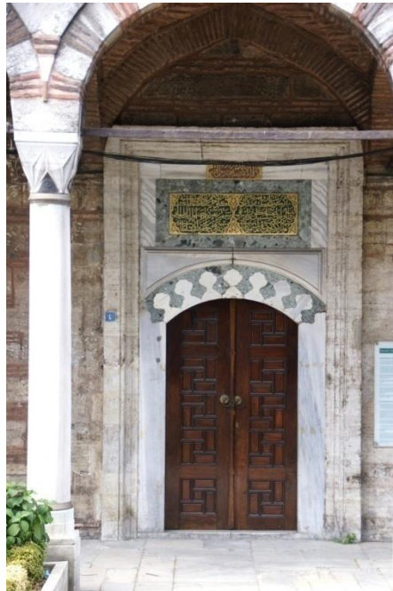
Resim 2.8. Erkekler Bölümünün Girişindeki Portal
