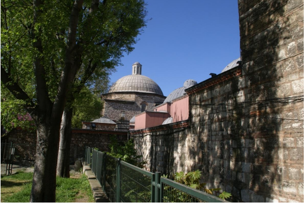
Resim 2.45. Binanın Güney Doğu Cephesi
