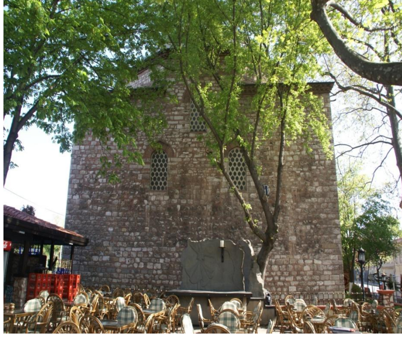
Resim 2.44. Binanın Güney Batı Cephesi
