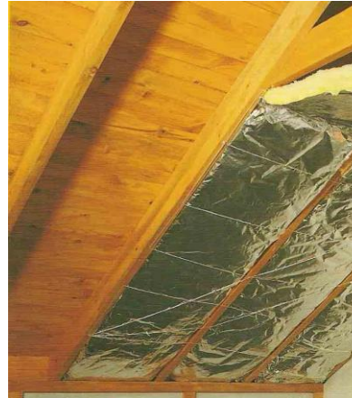
Resim 4.9. Alüminyum Folyo Kaplı Şiltenin Uygulanışı
