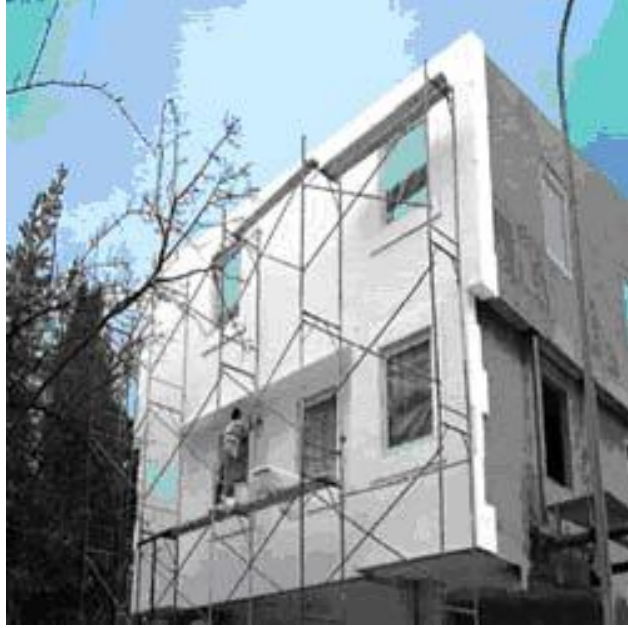
Resim 5.13. Dış Duvar Isı Yalıtımında EPS Uygulanması
