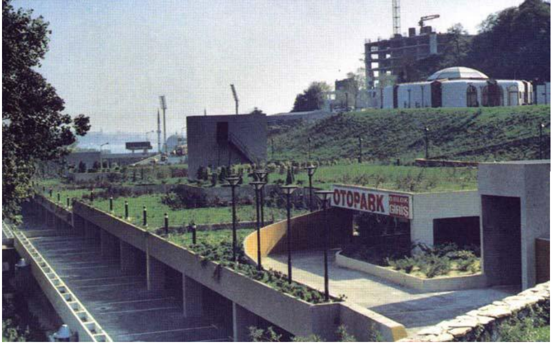
Resim 4.3. Gezilen Teras Çatı
