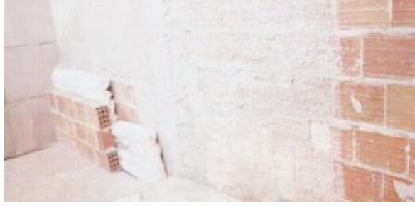
Resim 5.12. Genleştirilmiş Perlit Şiltenin Çift Duvar Arasında Uygulanması
