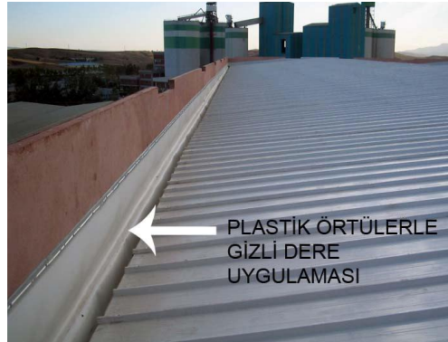
Resim 5.1. Plastik Örtülerle Dere Yalıtımı Yapılması
