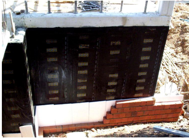
Resim 5.14. Bodrum Kat Isı Yalıtımında EPS Uygulanması
