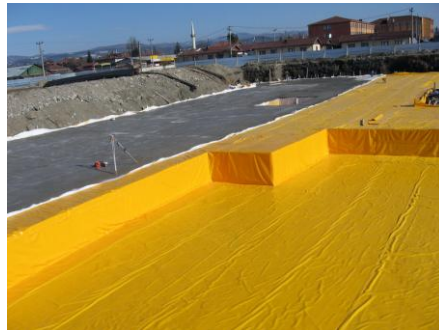
Resim 5.2. Plastik Örtülerle Temel Yalıtımı Yapılması
