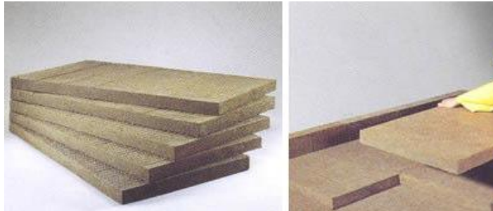
Resim 5.6. Taş Yünü'nün Döşemede Uygulanması
