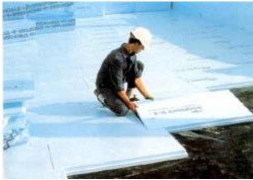
Resim 5.17. Teras Çatı Isı Yalıtımında XPS Uygulanması
