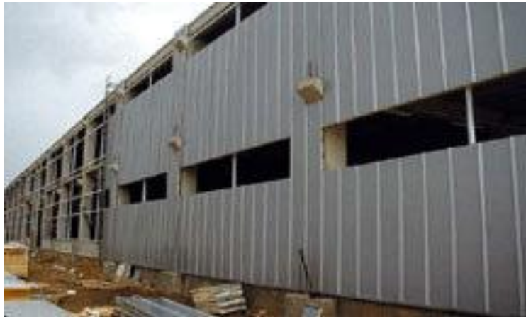
Resim 5.19. Yapılarda Poliüretan Sert Köpükten Oluşturulmuş Kompozit Panelin Dış Cephe Uygulanması
