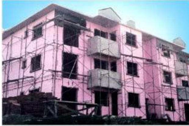
Resim 5.16. Dış Duvar Isı Yalıtımında XPS Uygulanması
