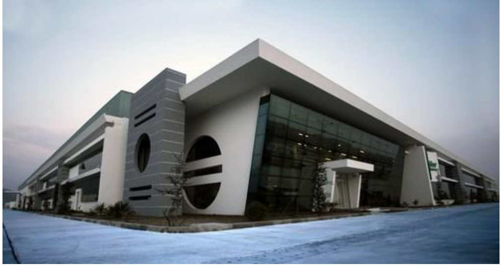
Şekil 4.20 : Schneider Electric Manisa Fabrikası
