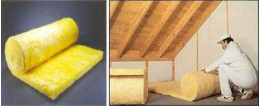
Resim 4.22 Isıtılmayan bir çatı arasında cam yünü uygulaması
