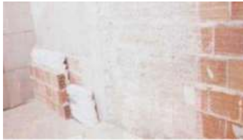
Resim 4.37 Genleştirilmiř perlit şiltenin çift duvar arasında uygulanması
