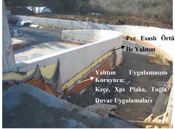
Resim 4.11 Pvc Esaslı Örtü İle Perde Yalıtımı Uygulaması
