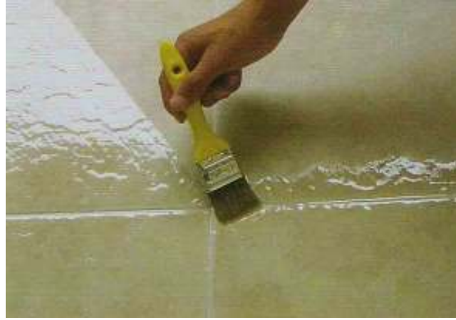
Resim 4.17 Poliüretan esaslı saydam kaplamannın ıslak hacimde uygulanması 121
