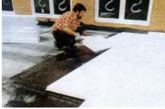
Resim 4.43 Teras çatı ısı yalıtımında EPS uygulaması 146
