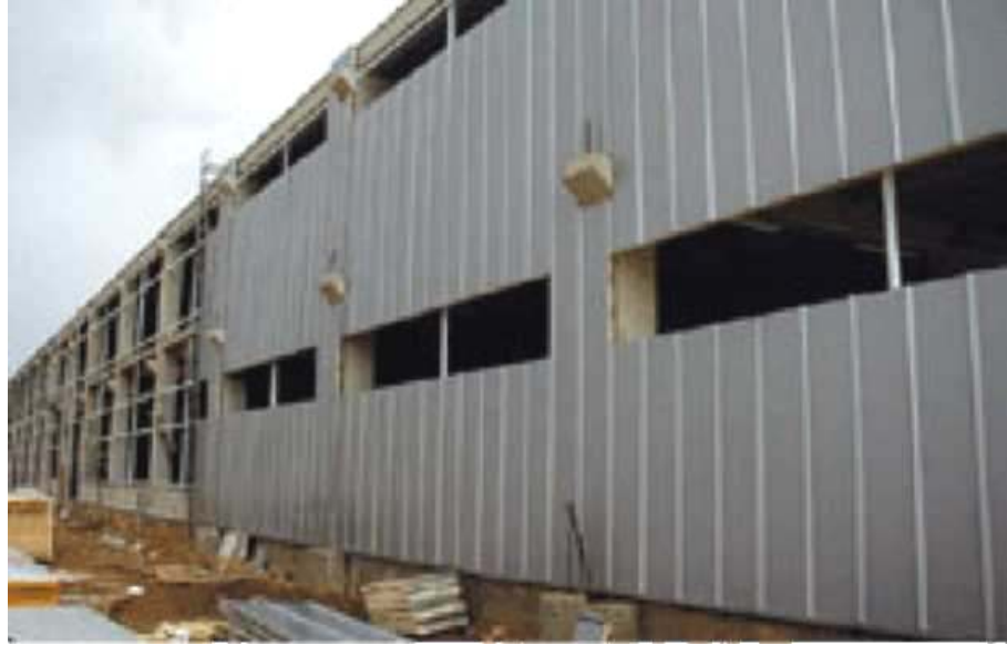
Resim 4.48 Yapılarda poliüretan sert köpükten oluşturulmuş kompozit panelin dış cephede uygulanması 151
