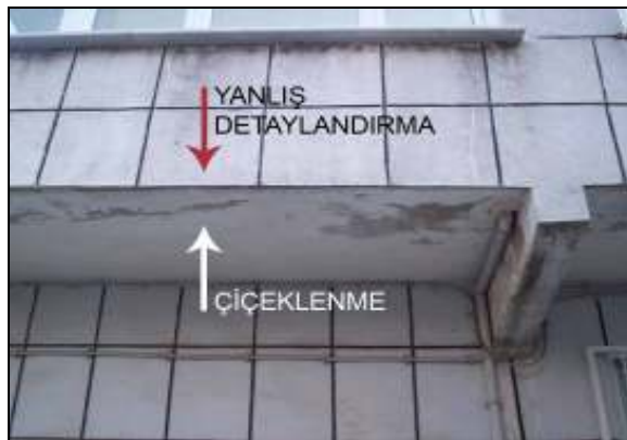
Resim 3.35 Konsol döşemede hatalı detaylandırma sonucu oluşan sorunlar 96
