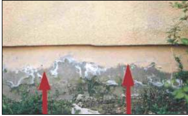
Resim 3.40 Yalıtım sorunlarına kesin çözüm oluşturulmadan yapılan ısı yalıtımı 99
