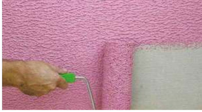
Resim 4.18 Akrilik esaslı kaplamanın dış cephe kaplaması olarak uygulanması
