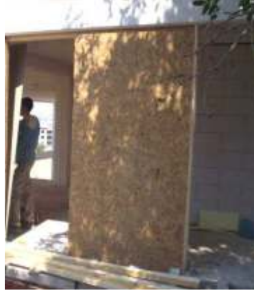
Resim 4.34 Rende yongasının dış duvarda uygulanması
