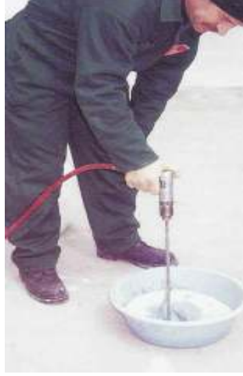
Resim 4.13 Çimento esaslı karışımın karıştırıcı ile karıştırılması 116
