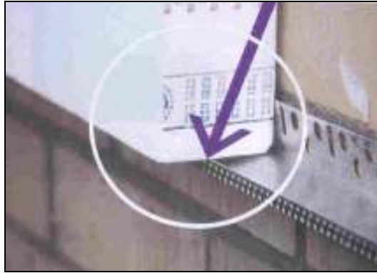
Resim 3.38 Isı yalıtımı çözümünde uyumsuz ürünlerin seçilmesi 97
