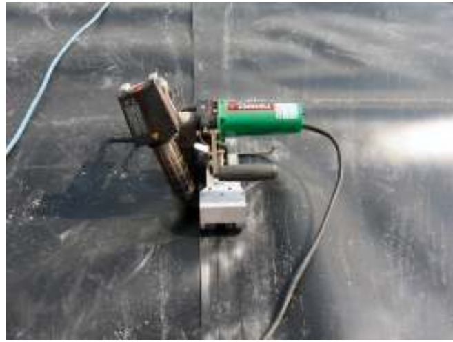
Resim 4.10 Plastik örtülerin robot kaynak makinesi ile kaynaklanarak birleştirilmesi 113
