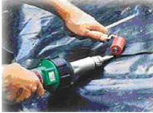
Resim 4.9 Plastik örtülerin el fön makinesi ile kaynaklanarak birleştirilmesi 112
