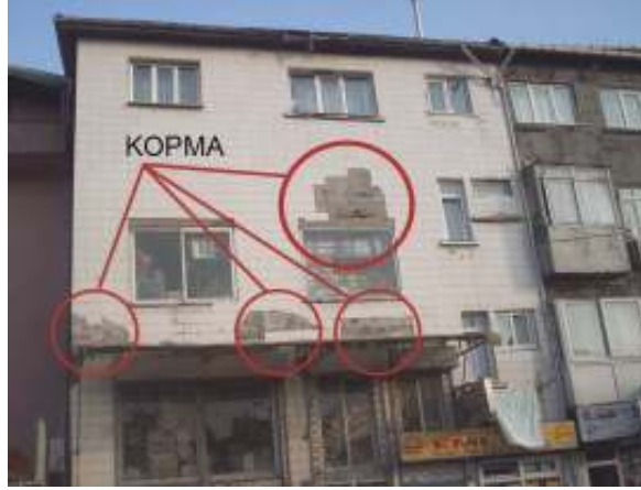
Resim 3.6 Cephede ürün-bağlayıcı arasındaki farklı gerilmelerle kopma gözlenmesi 61
