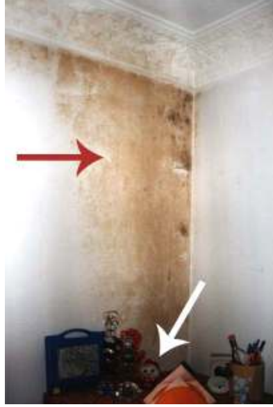
Resim 3.33 Tasarım aşamasında su ve ısı yalıtımlarına yönelik çözümlerin oluşturulmaması 93
