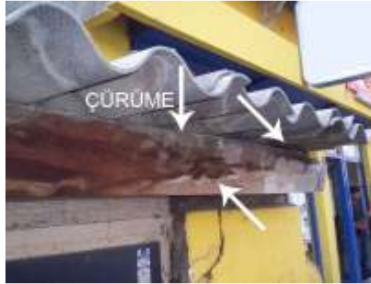
Resim 3.23 Su ve ısı etkenlerinin ahşap kirişte oluşturduğu çürüme sorunu 73
