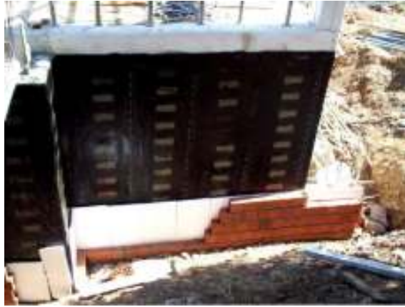
Resim 4.41 Bodrum kat ısı yalıtımında EPS uygulaması
