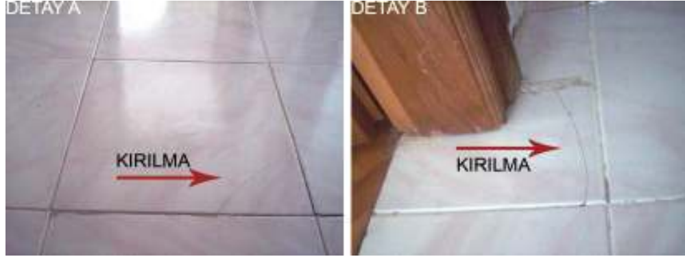
Resim 3.3 Isı değişimleri ile ortaya çıkan gerilmeler sonucu seramik ürününün dayanımının azalması ve üzerine gelen yükte kırılması
