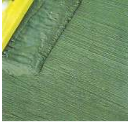
Resim 4.14 Çimento esaslı karışımın fırça yardımıyla yüzeye uygulanması 117
