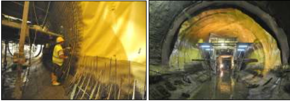
Resim 5.7 Tünellerde yalıtım uygulamaları örneği
