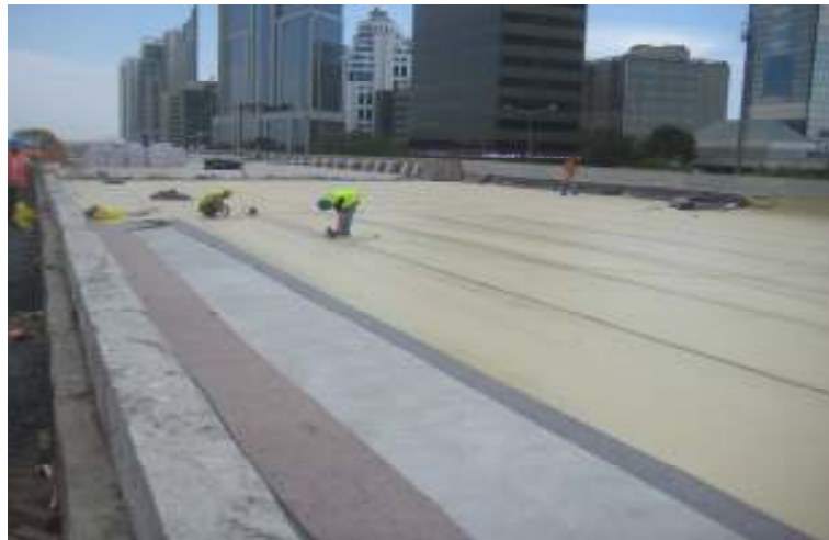
Resim 4.12 Pvc Esaslı Örtü İle Yalıtım Uygulaması
