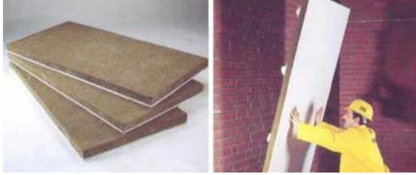
Resim 4.27 Kalibel ısı yalıtım ürününün duvarda uygulanması
