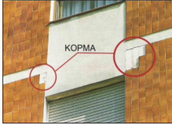
Resim 3.39 Isıl gerilmelere karşı uyumlu çalışmamış seramik ve bağlayıcısının birbirinden ayrılması 98
