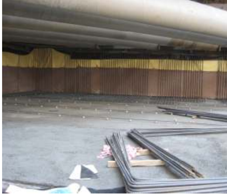
Resim 4.6 Plastik Esaslı Malzeme İle Yalıtım ve Koruyucu Keçe Uygulaması
