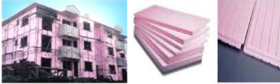
Resim 4.45 Dış duvar ısı yalıtımında XPS uygulaması
