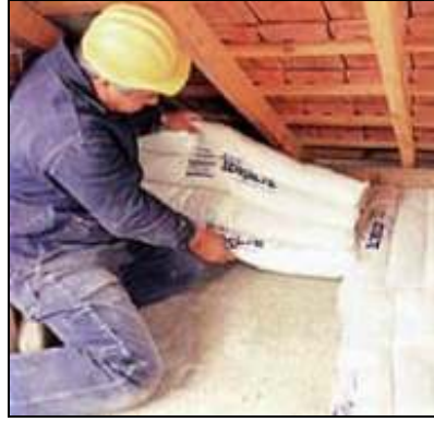
Resim 4.36 Genleştirilmiř perlit şiltenin kapalı çatılarda uygulanması 140
