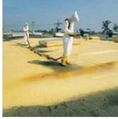
Resim 4.49 Yapılarda poliüretan sert köpüğün püskürtme yoluyla uygulaması 153
