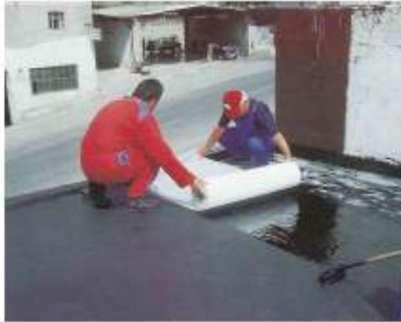
Resim 4.15 Yalıtım olarak kullanılan karışımın katları arasına taşıyıcı serilmesi 119
