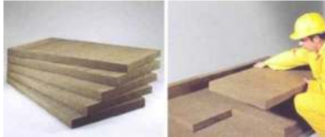
Resim 4.25 Levha şeklindeki taş yünü ısı yalıtım ürününün döşemede uygulanması 131
