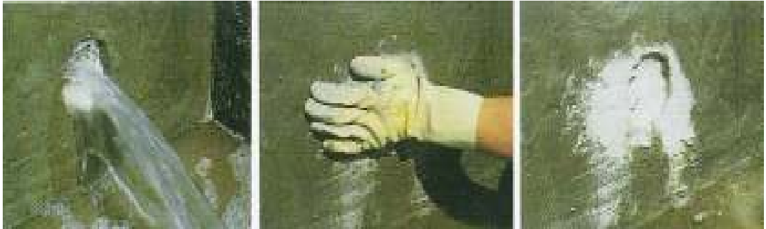
Resim 4.19 Aktif su kaçağının şok prizli su tıkaçı ile kapatılması 124
