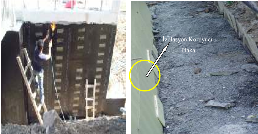
Resim 4.3 Yalıtım için astarlanmış yüzeye şalümo alevi ile polimer bitümlü örtünün yapıştırılması ve yalıtım koruyucu plaka yapılması
