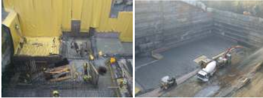
Resim 5.6 Metro istasyon binası yapım aŖamasında Pvc Membran uygulaması
