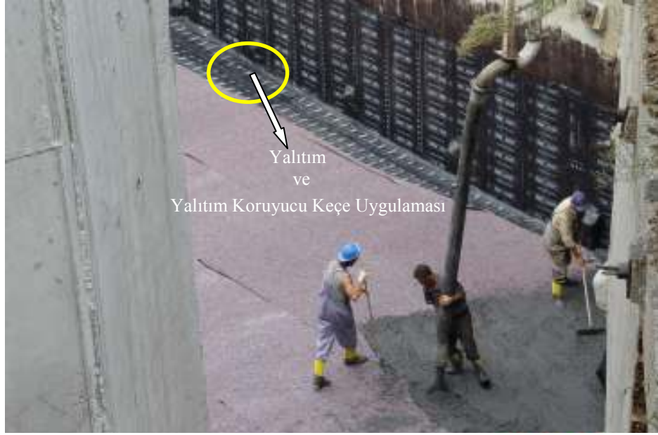
Resim 4.4 Yalıtım ve Yalıtım Koruyucu Keçe Uygulaması
