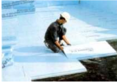
Resim 4.46 Teras çatı ısı yalıtımında XPS uygulaması 148
