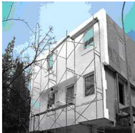
Resim 4.42 Dış duvar ısı yalıtımında EPS uygulaması 145
