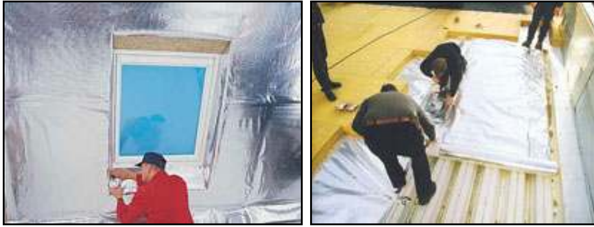
Resim 4.51 Buhar bariyeri sistemi uygulama örneği
