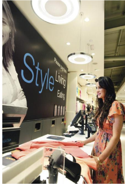
Şekil 3.56 Ödeme Noktası aydınlatma Örneği. Ödeme noktaları üzerine, genel aydınlatmaya ek olarak, lokal (bölgesel) aydınlatma sağlayan armatürlerin yerleştirilmesi (Philips, 2011: 14).
