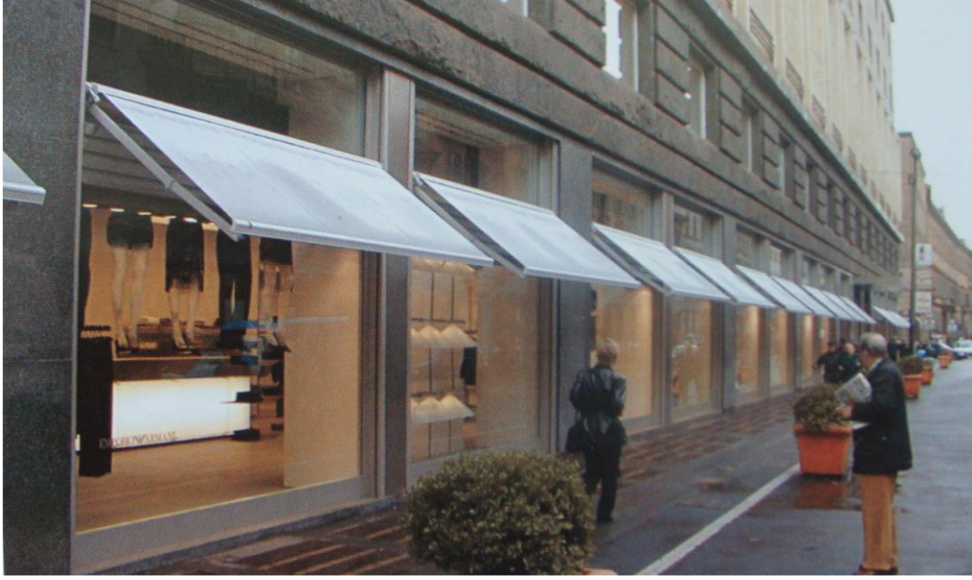
Şekil 3.18 Armani Merkez Mağazası Milano. İtalya Milano’da bulunan Armani Merkez Mağazası’nın vitrinlerinin üzerinde bulunan tenteler müşterileri iklim koşullarından korumaktadırlar (The New Boutique, 2005: 52).
