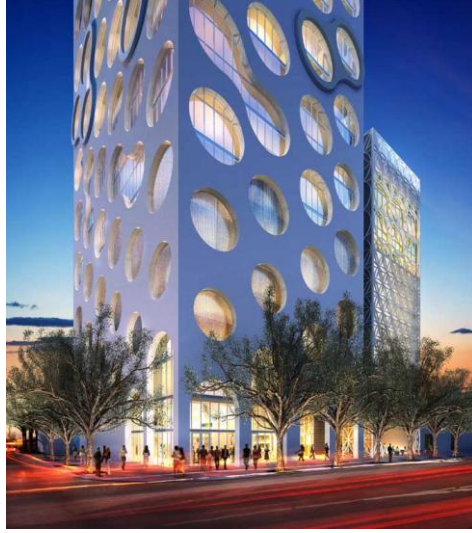
Şekil 5.34. COR Binası'nın cadde seviyesinden görünüşü. 255
