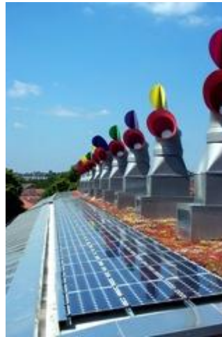
Şekil 5.25: Bedzed Konutları havalandırma bacaları ve PV panelleri. 244
