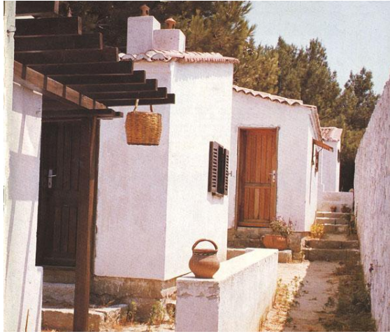
Şekil 5.8. Bahçe Duvarı ve Yapı Grupları, Çanakkale'deki Gürel Evi 206
