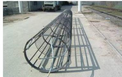
Şekil 4.34: Donatı kazıklarının üzerine yerleştirilen kolektör borularının uygulama yöntemi. 141
