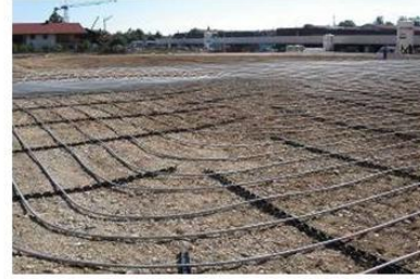
Şekil 4.33: Yatay borulamanın uygulama yöntemi. 139
