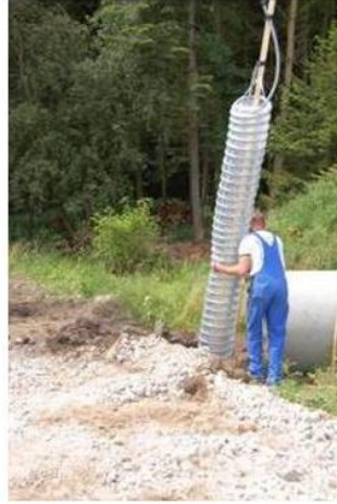
Şekil 4.32: Helix Sondanın Uygulaması. 137
