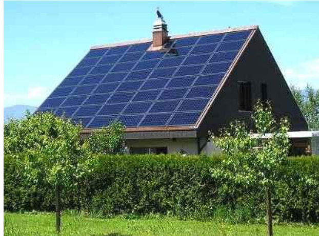
Şekil 4.23: Güneş Pilinin Çatıda Uygulanması. 111
