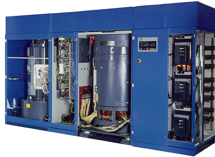
Şekil 2.4. Kinetik enerji depolu DKGK.
