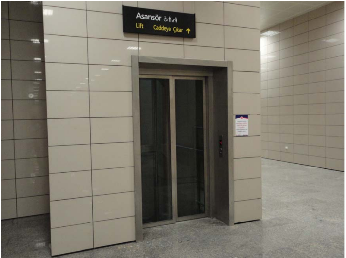
Şekil 3.9: Seyrantepe metro istasyonu söve uygulaması (Gökhan Mermi Arşivi)
