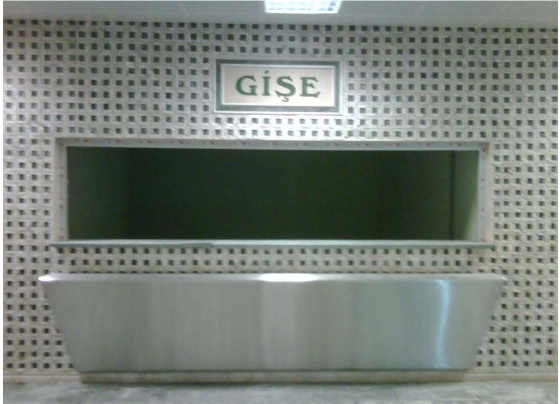
Şekil 5.25: Darüşşafaka Metro İstasyonu paslanmaz çelik kaplama bilet gişesi (Gökhan Mermi Arşivi)
