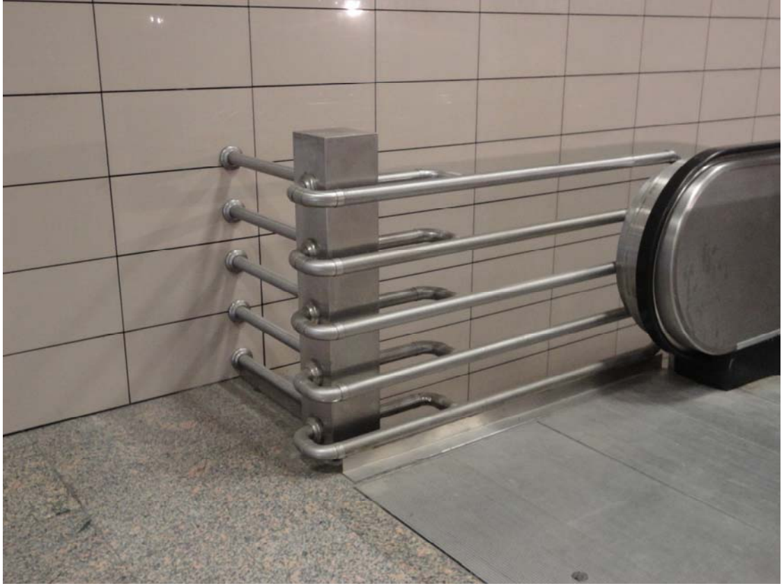
Şekil 3.8: Seyrantepe metro istasyonu korkuluk uygulaması (Gökhan Mermi Arşivi)
