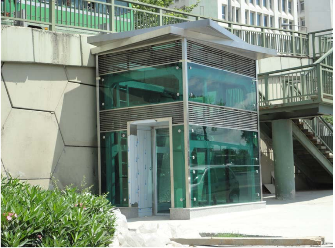
Şekil 5.28: İTÜ Metro İstasyonu Paslanmaz cam kaplama panoramik asansör (Gökhan Mermi Arşivi)
