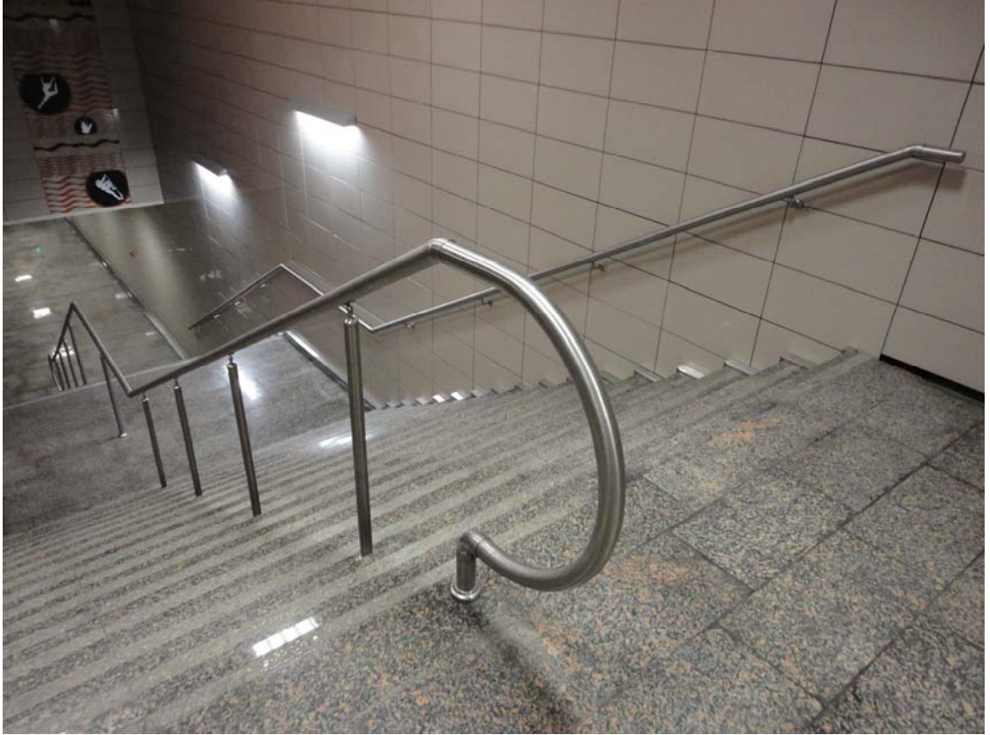
Şekil 3.1: Seyrantepe metro istasyonu paslanmaz çelik korkulukları (Gökhan Mermi Arşivi)
