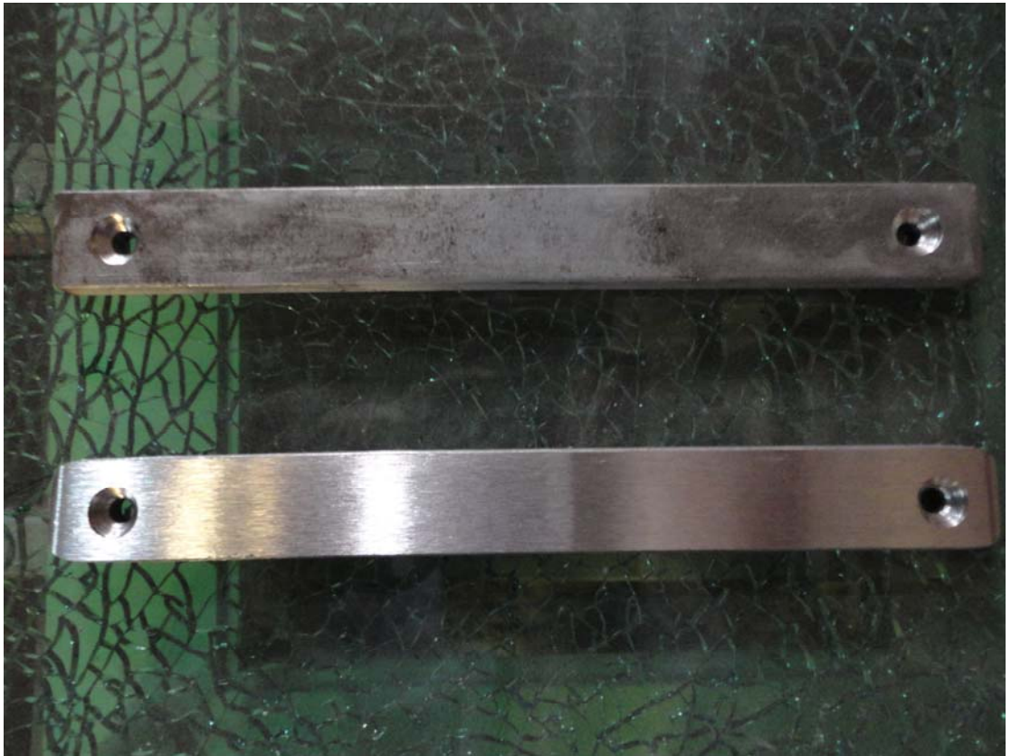
Şekil 5.27: Paslanmaz çelik lama cam tutucu bağlantısı (Gökhan Mermi Arşivi)
