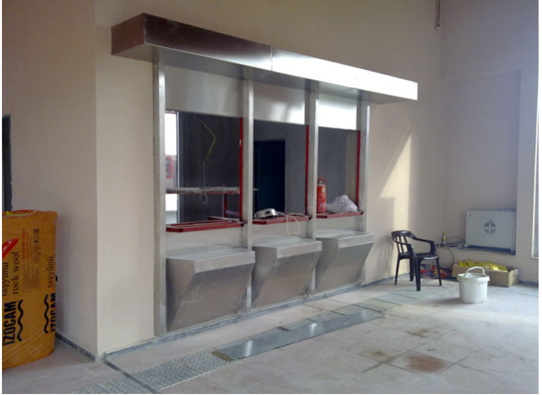
Şekil 5.24: Esenler Metro İstasyonu paslanmaz çelik kaplama bilet gişesi (Gökhan Mermi Arşivi)
