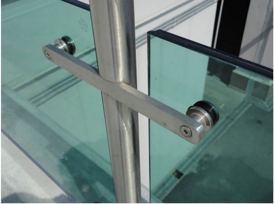
Şekil 5.26: Lamalı paslanmaz çelik korkuluk dikmesi ve cam tutucusu (Gökhan Mermi Arşivi)
