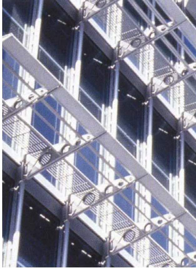
Şekil 3.12. Hongkong ve Shanghai Bankası cephe sistemi
