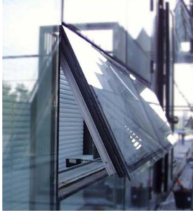
Şekil 3.33. Doğal havalandırmaı cephelerde kullanılan mekanik pencere örneđi
