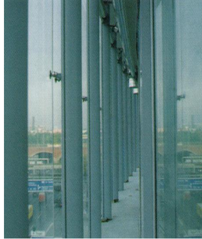
Şekil 4.15. Kabuklar arası görünüş
