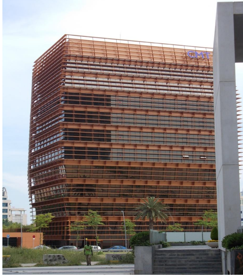
Şekil 3.16. Izgara sistemli güneş kırıcılar
