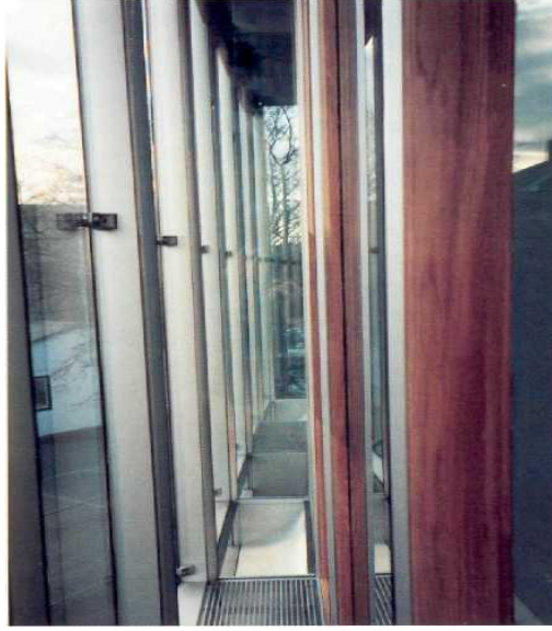
Şekil 3.31. Şaft Tipi Çift Kabuk Sistemi
