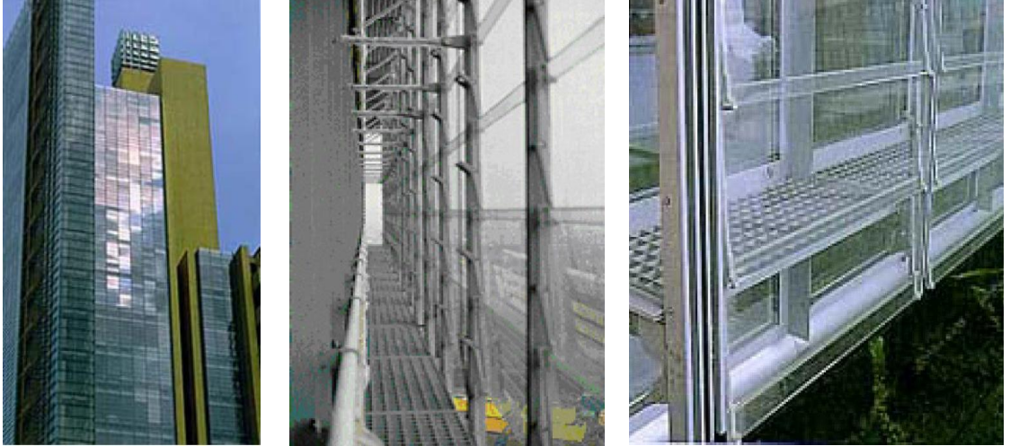
Şekil 4.11. Debis Merkez Ofisi cephe görünüşü ve çift kabuk detayı
