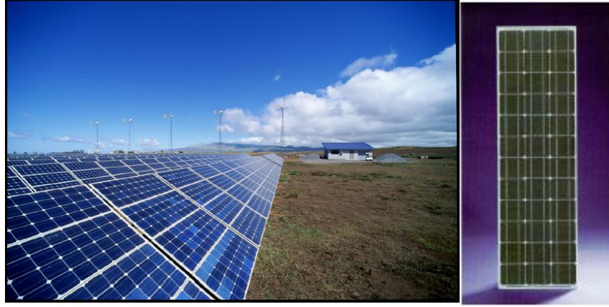
Şekil 3.37 Fotovoltaik Pil Tarlası
