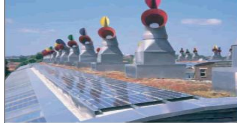
Şekil 3.87 Rüzgar ile Isı Geri Kazanımlı Havalandırma Yapan Rüzgar Bacaları ve Güneş Pilleri
