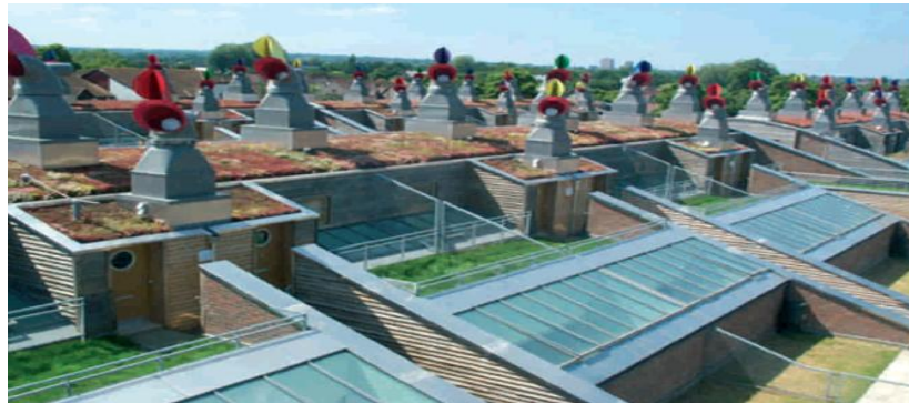
Şekil 3.86 Çatı Bahçeleri, Rüzgar Bacaları, Sedum Çatı Örtüleri
