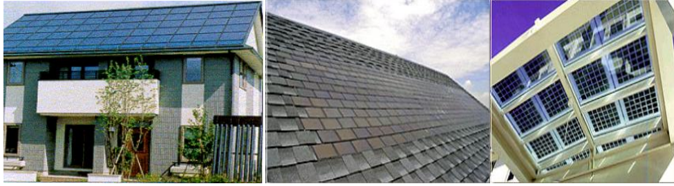
Şekil 3.39 a) Çatıda Uygulanmış b) Asfalt Görünümde c) Tepe Işıklığı olarak Kullanılan Fotovoltaik Sistemler
