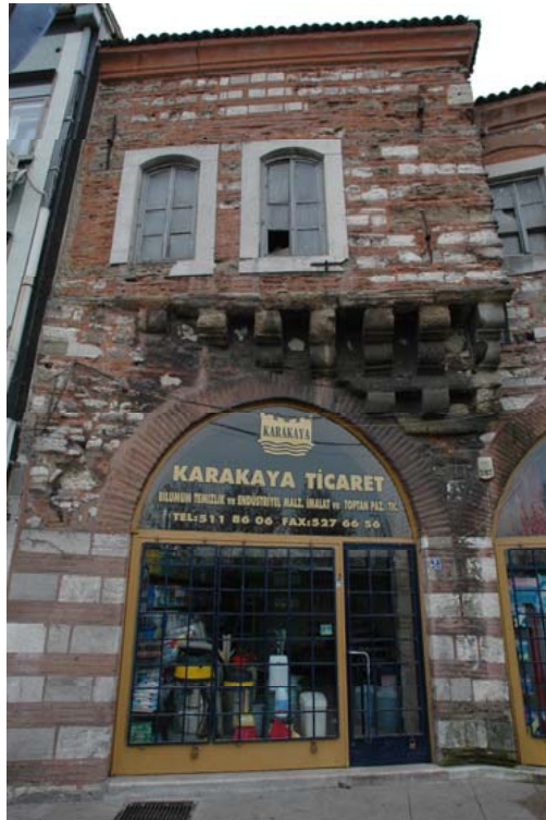
Resim 3.30. Ali Paşa Hanı 1 almaşık sistem duvar ve oda çıkması
