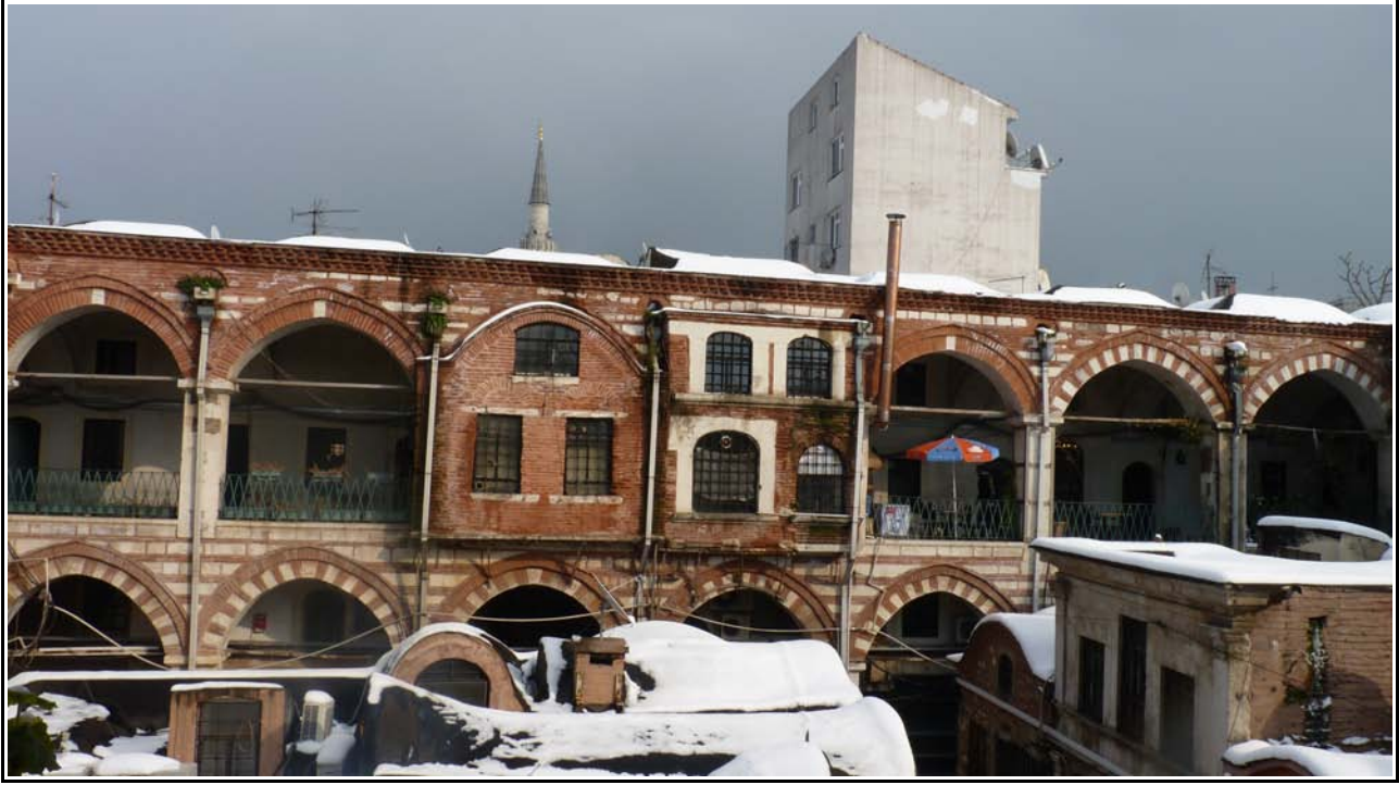
Resim 3.43. Çuhacı Han avluya bakan 28 m açıklığa sahip cephesi ve kapatılmış revak örneği
