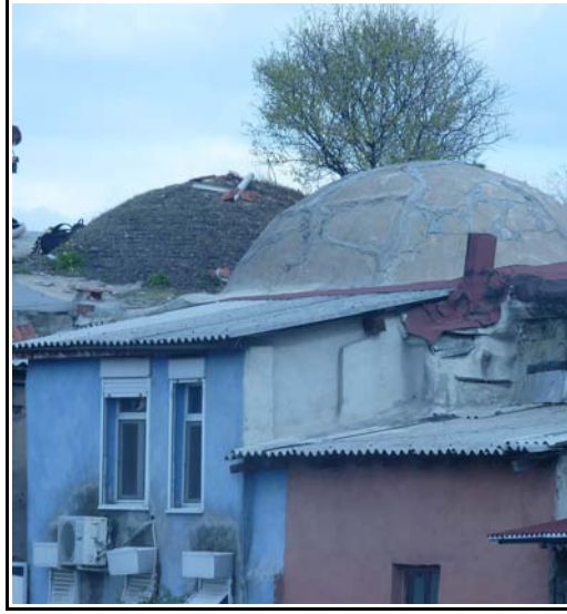
Resim 3.28. Büyük Valide Han avluya bakan kubbeler ve önde bulunan ek binaların görünümü
