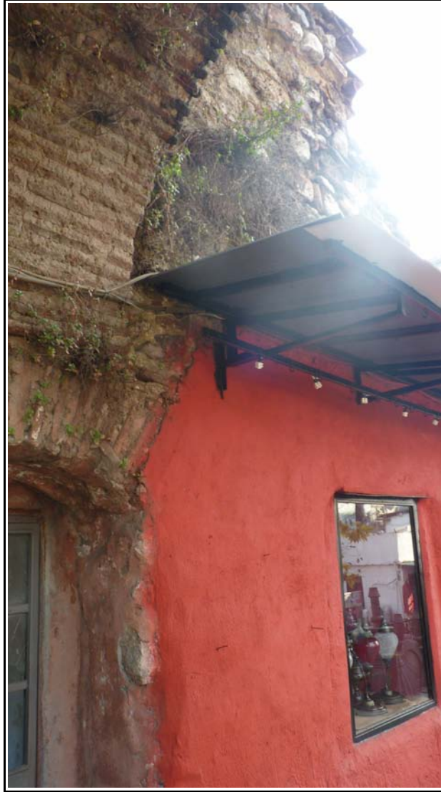
Resim 3.37. Cebeci Han taş duvar yüzeyine sıva uygulaması
