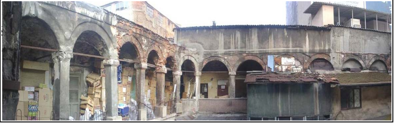
Resim 3.22. Leblebici Han avlu etrafını saran yuvarlak kemerli revaklar
