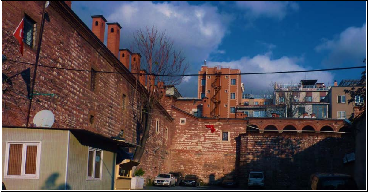
Resim 3.52. Taş Han dış cephe ve giriş holü cepheden görünüş
