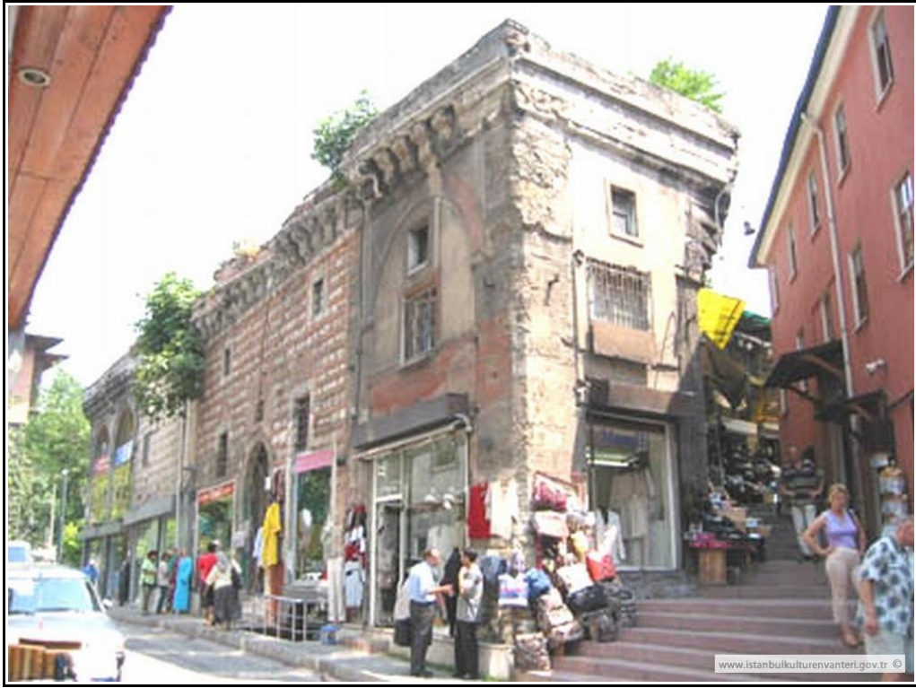
Resim 4.4. Hasan Paşa Hanı dış cephe
