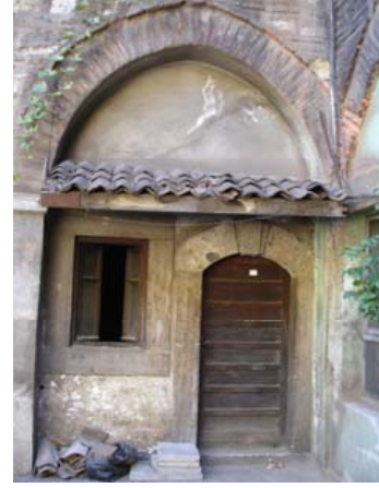
Resim 3.31. Ali Paşa Hanı 1. revakların görünümü ve kapatılmış revak örneği
