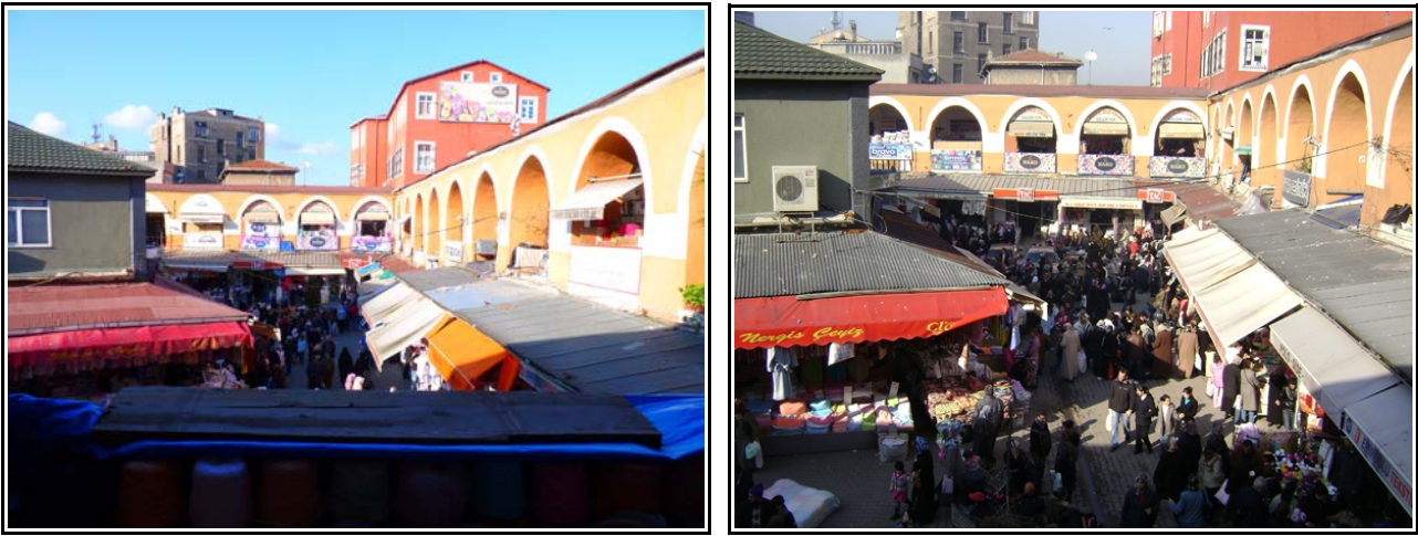
Resim 3.7 15. yüzyıl Kürkçü Han avluya bakan cephe
