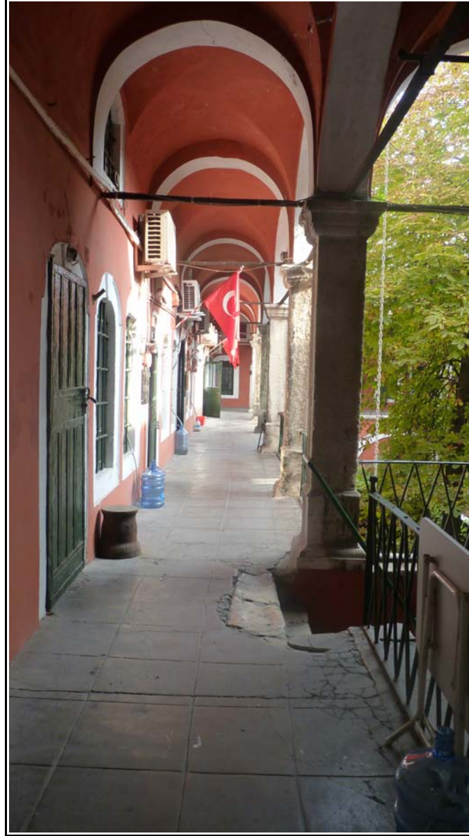
Resim 3.55. Zincirli Han avluya bakan birinci kat teras ve revak görünümü
