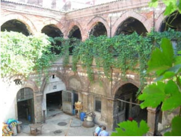
Resim 3.31. Ali Paşa Hanı 1. revakların görünümü ve kapatılmış revak örneği
