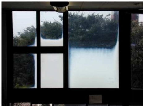
Şekil.4.35. Termokromik Camın Geçirgenliği Koşulunda Görünümleri
