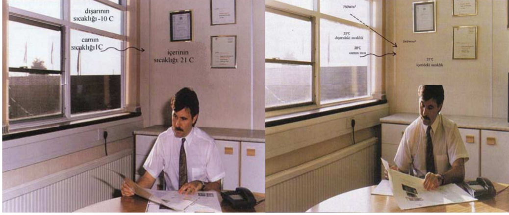
Şekil.4.21. Pencerelerinde ısı soğuran cam kullanılmış bir ofis binasında sırasıyla kış ve yaz ayları iç /dış ortam sıcaklığı karşılaştırmaları. İç ortamın sıcaklığı camdan 1 metre uzakta ölçülmüştür.
