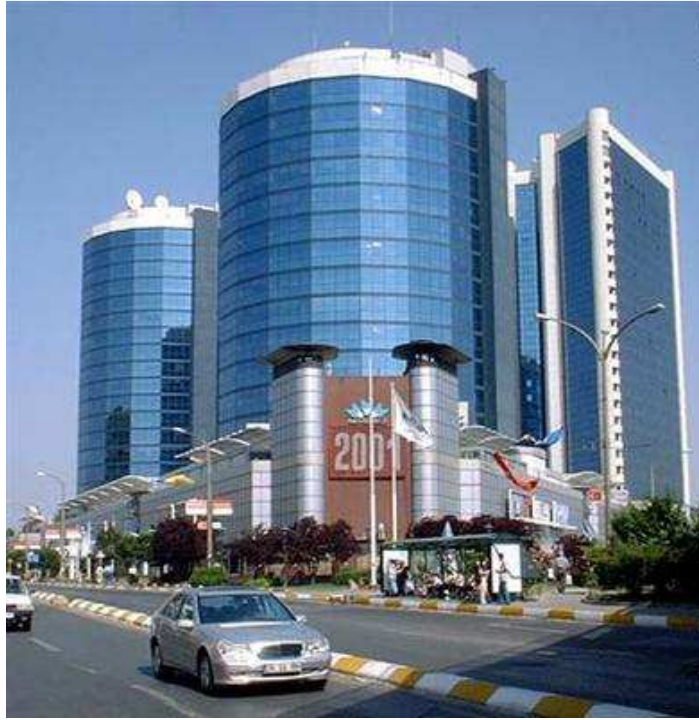
Şekil .2.31. Akmerkez- Etiler İstanbul
