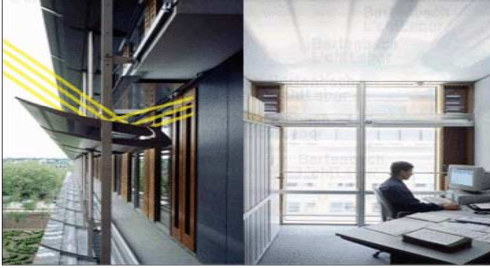
Şekil.4.12. Gelişmiş Işık Rafı Sistemleri – İç-Dış Uygulama Örnekleri
