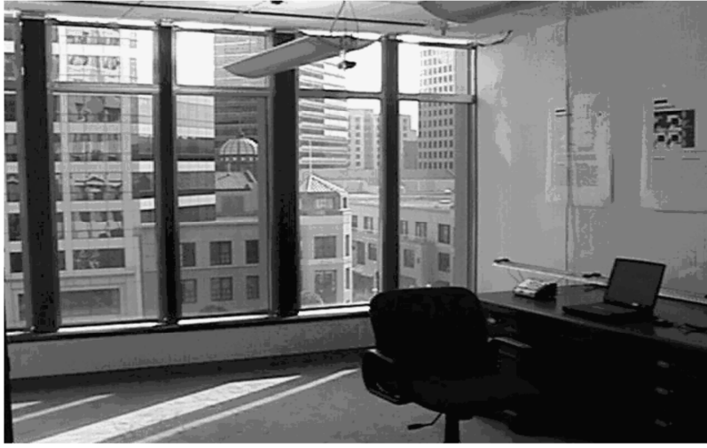
Şekil 4.25. Tayfsal seçici cam kullanılmış bir ofis penceresi
