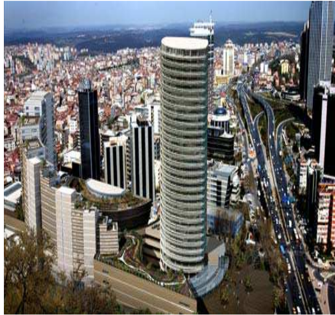
Şekil. 2.34. Eczacıbaşı Kanyon Alışveriş Merkezi Dış Görünüş
