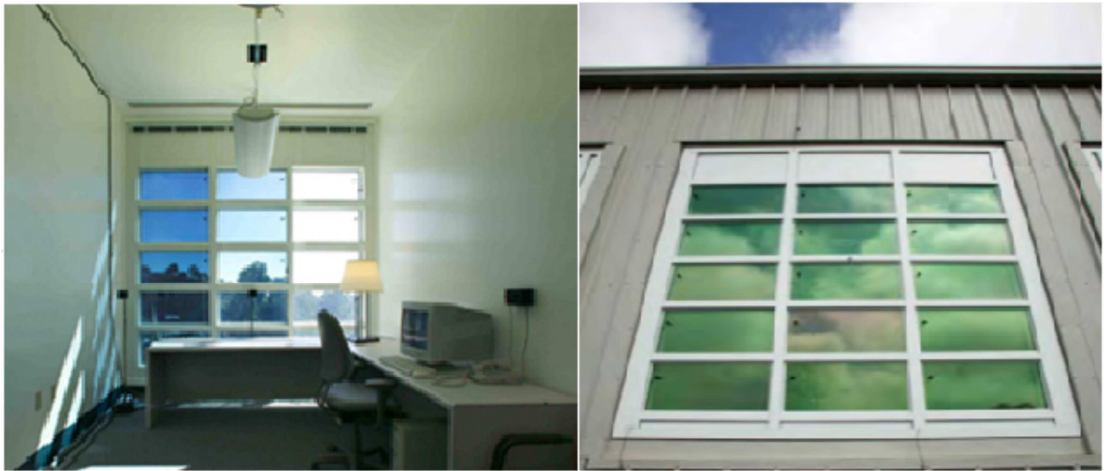
Şekil .4.40. Elektrokromik Camın 3 Farklı Koşulda Kullanımı
