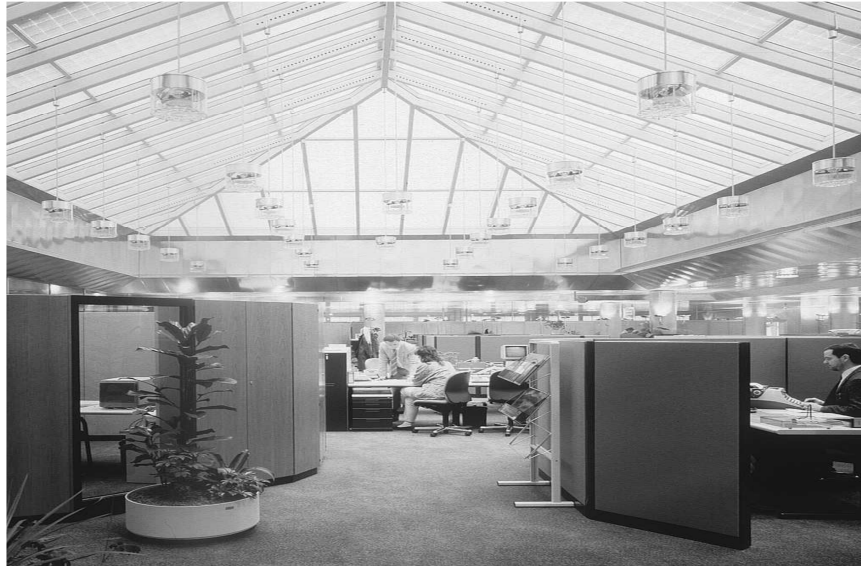
Şekil .4.30. Tepe Açıklığında Çift Cam Arasında Prizmatik Panel Uygulaması
