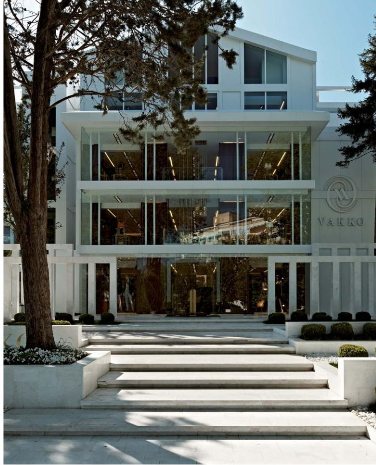
Şekil 5.28. Vakko Kavaklıdere Mağazası Dış Cephesi
